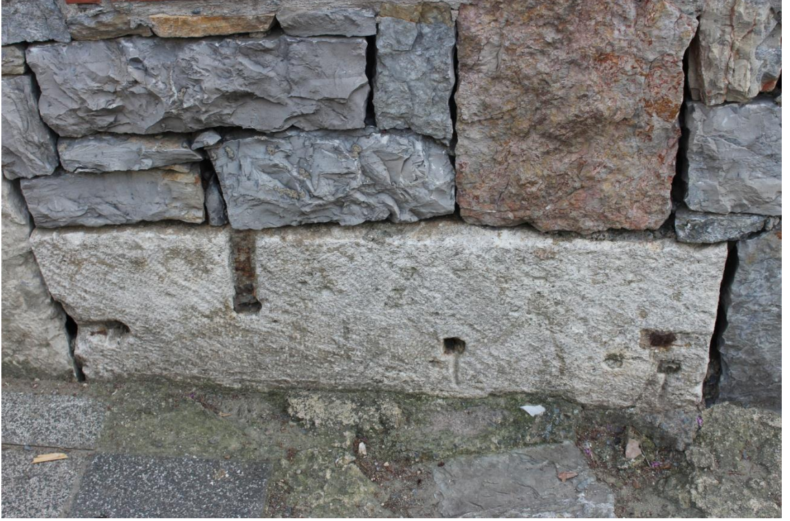
Resim 9a: Hazîre duvarından ayrıntı
