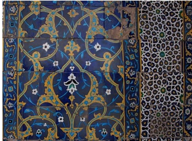
Yavuz Sultan Selim Türbesi Detay
