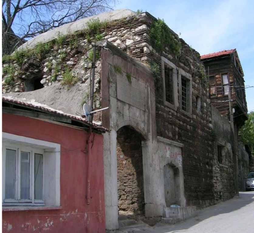
Fotoğraf 34: Hacı Beşir Ağa Sıbyan Mektebi ve Medrese Giriş Kapısı (2004)
