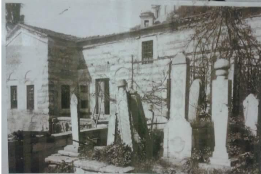
Fotoğraf 50: Mihrişah Valide Sultan Sıbyan Mektebi Doğu (Giriş) Cephesi (1940 Öncesi)
