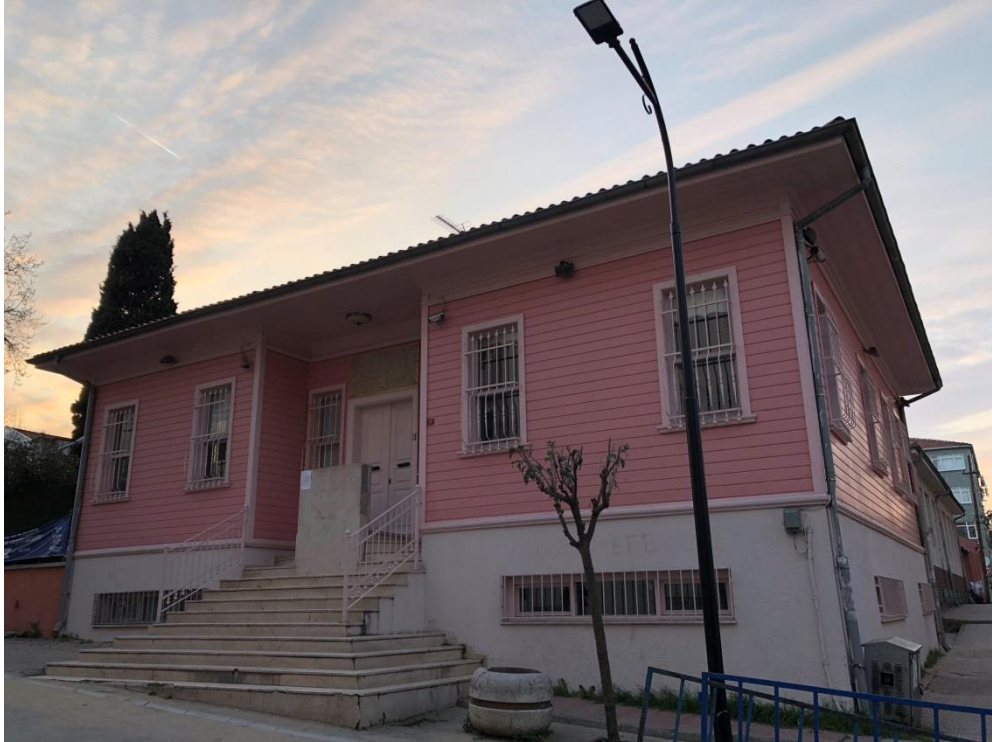
Fotoğraf 25: Hacı Ali Paşa Sıbyan Mektebi Güney (Giriş) ve Doğu Cephesi (2019)
