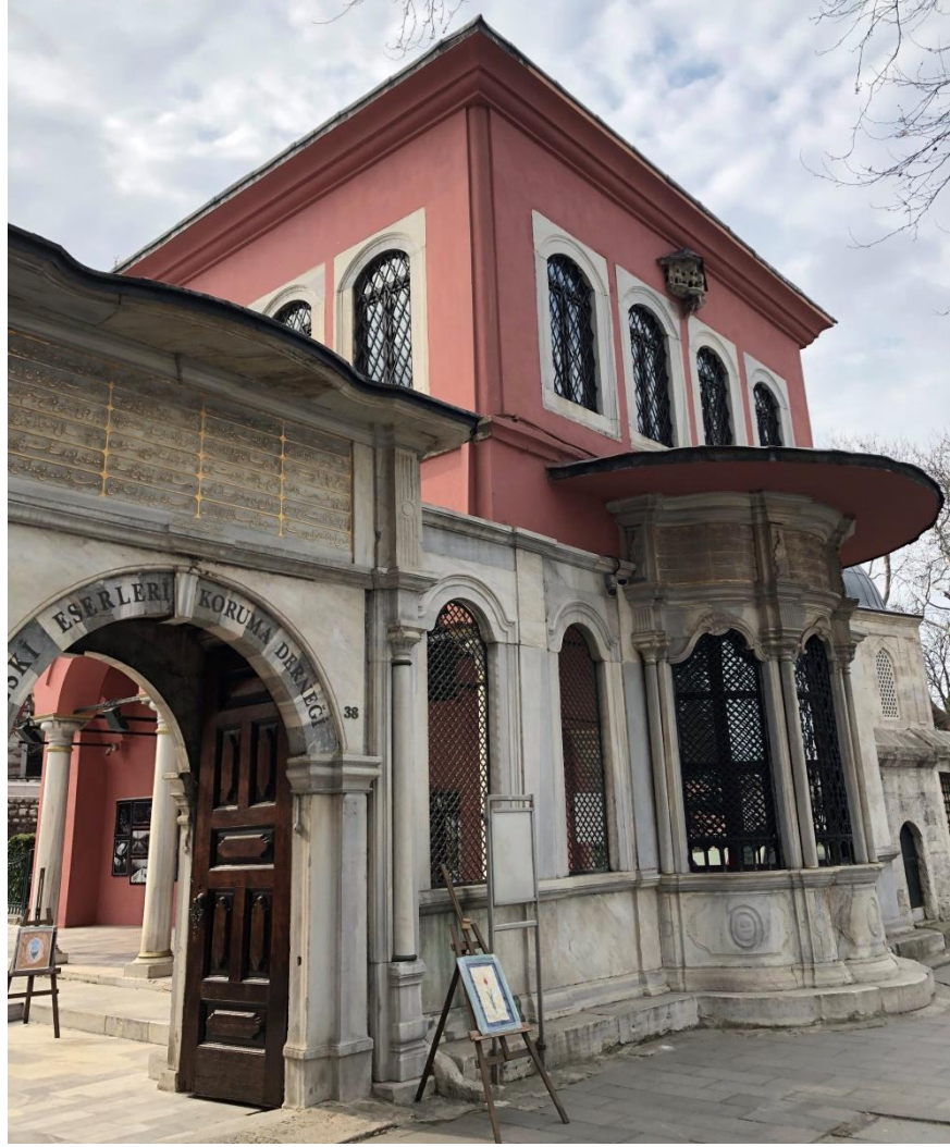
Fotoğraf 70: Şah Sultan Sıbyan Mektebi ve Külliye Girişi (2019)
