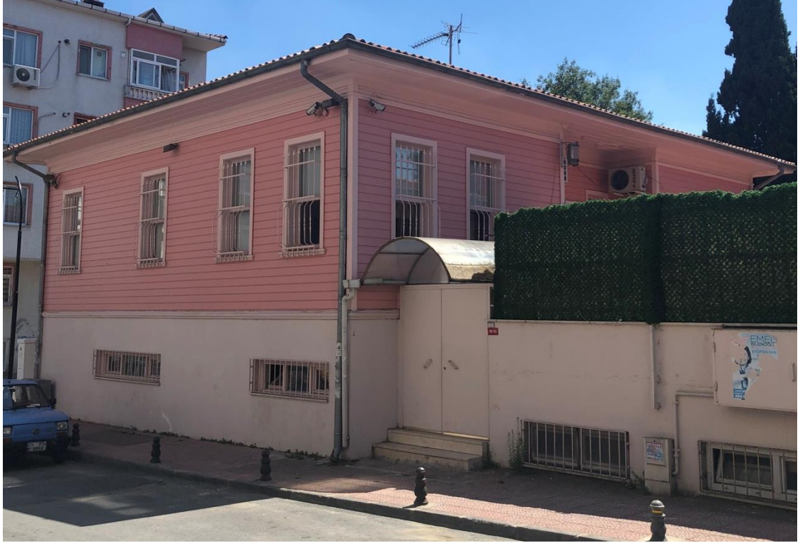
Fotoğraf 26: Hacı Ali Paşa Sıbyan Mektebi Doğu ve Kuzey Cephesi (2019)
