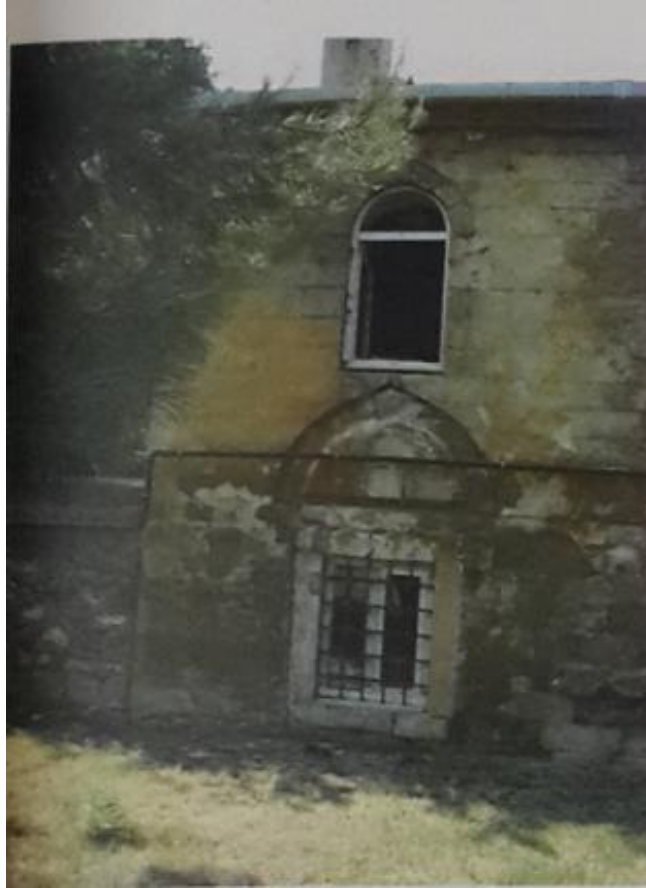
Fotoğraf 88: Pîrî Mehmed Paşa Sıbyan Mektebi Güney Cephe (2018)
