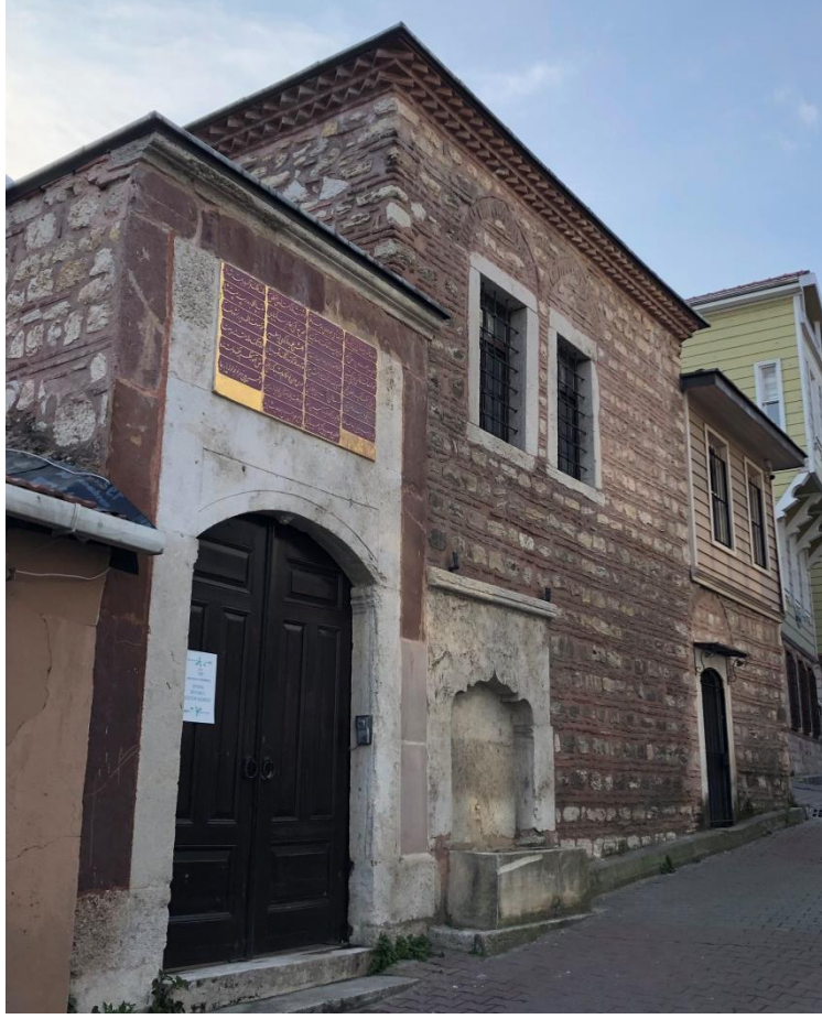
Fotoğraf 30: Hacı Beşir Ağa Sıbyan Mektebi ve Medrese Giriş Kapısı (2019)
