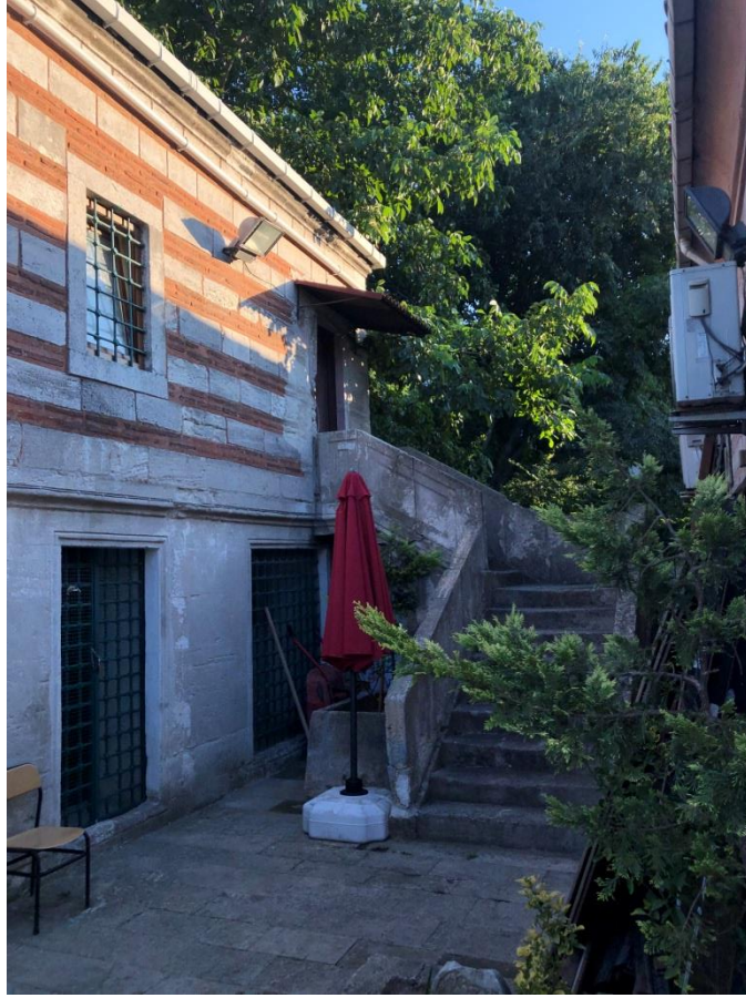
Fotoğraf 56: Ramazan Ağa Sıbyan Mektebi Batı (Giriş) Cephesi (2019)
