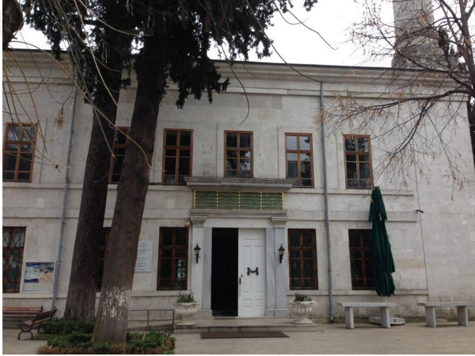
Emirgan Camii giriş kapısı cephesi
