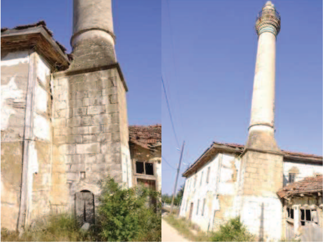
Fotoğraf 85; Fotoğraf 86: Bedi Köyü Camii minare kaidesi; Bedi Köyü Camii minaresi
