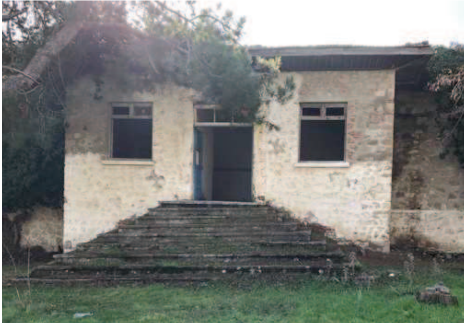
Bedi Köyü Okulu giriş merdivenleri
