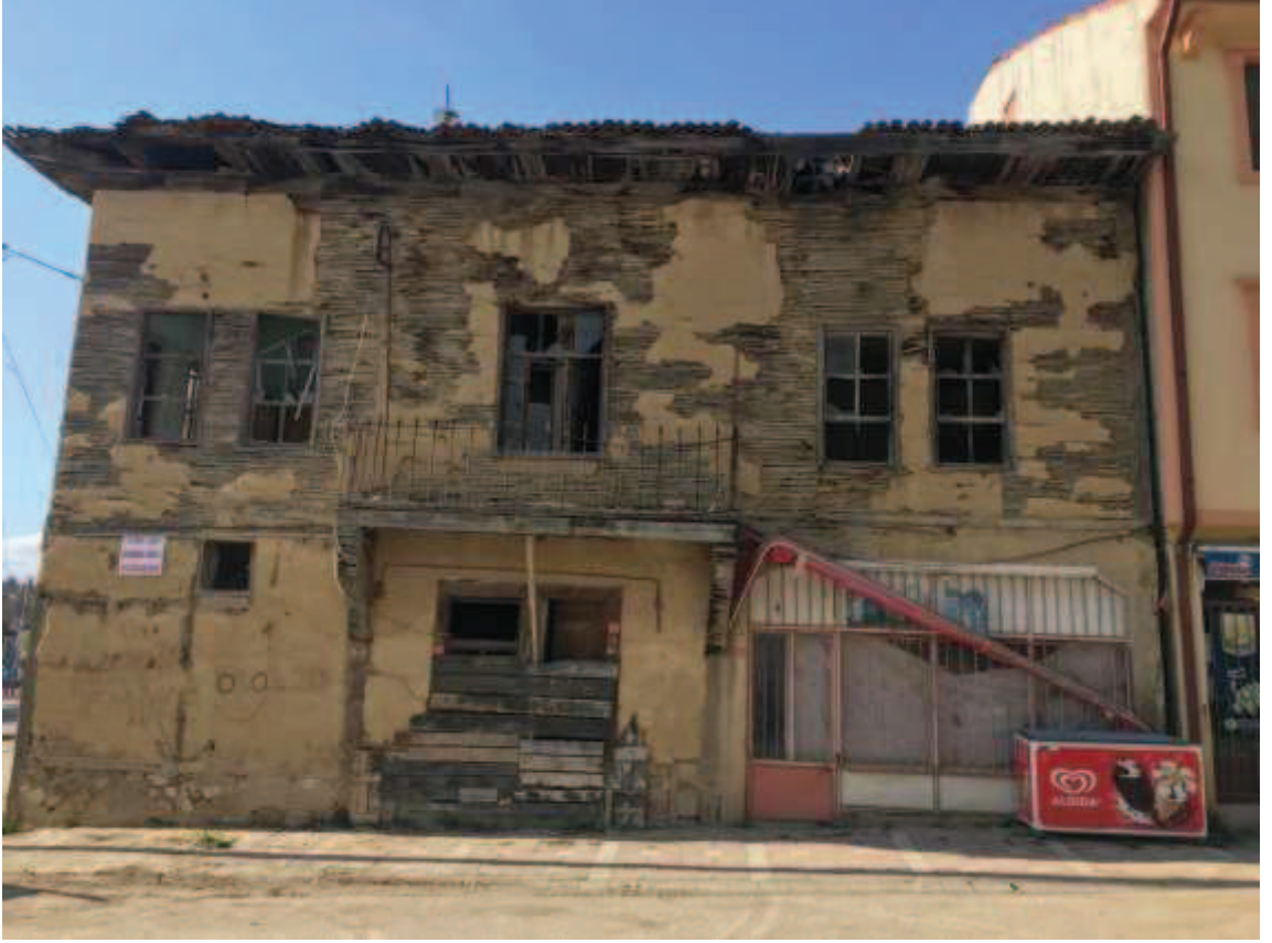
Fotoğraf 11: Muazzez Manzeoğlu Evi güney cephesi
