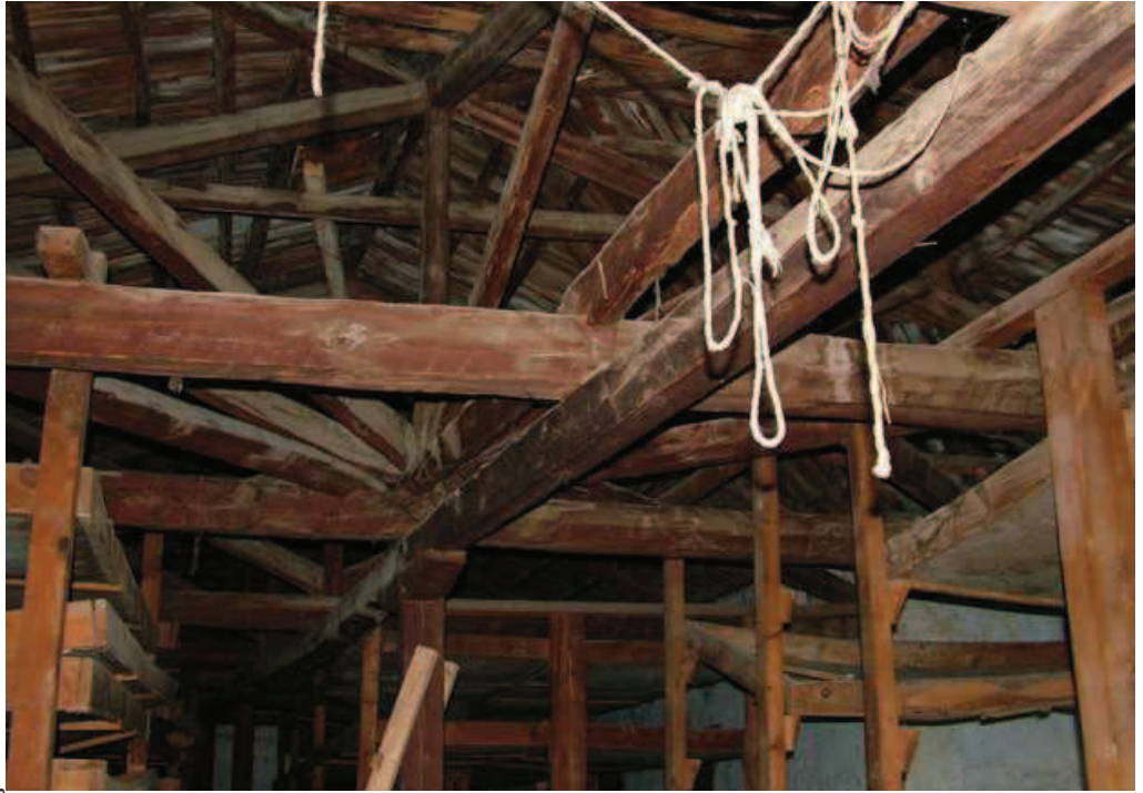
K.F. 36: Osmaneli evi çatı konstrüksiyonu
