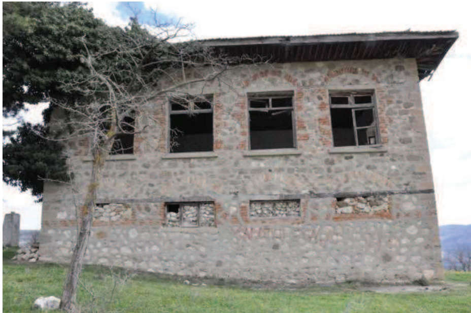
Bedi Köyü Okulu yan cephe bodrum kat pencere dolguları
