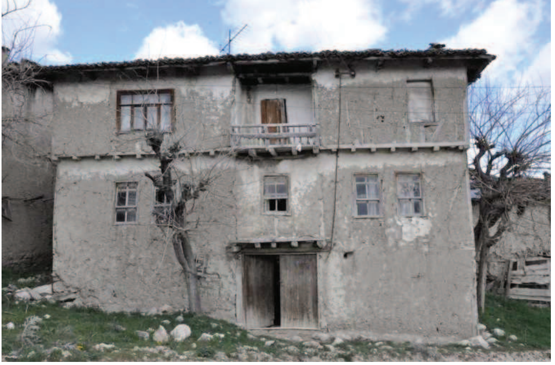
Fotoğraf 93: Ahmet Göktepe Evi giriş cephesi
