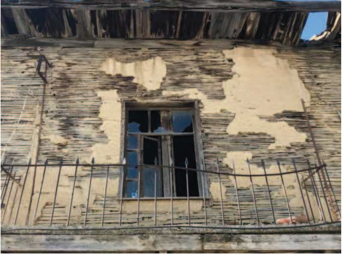
Fotoğraf 14: Muazzez Manzeoğlu Evi bağdadi duvar tekniği
