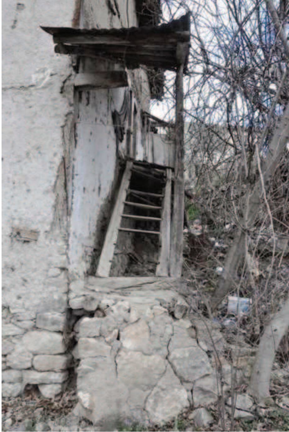
Fotoğraf 107: Osman Kayacık Evi güney cephe müştemilat merdiveni
