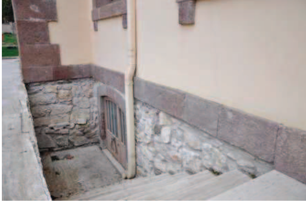
Dârüleytam düzensiz moloz taş malzemesi
