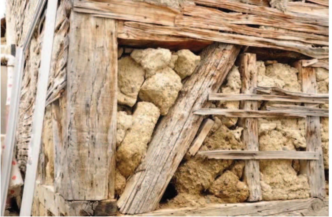
Enver Yazıcı Evi ahşap karkas arası kerpiç kullanımı
