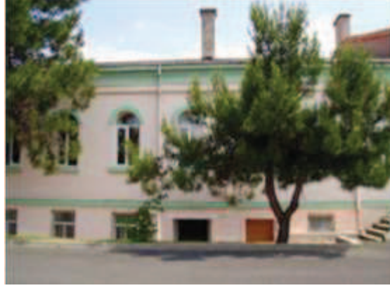
Fotoğraf 127: Güneydoğu Kanadı İç Cephe**
