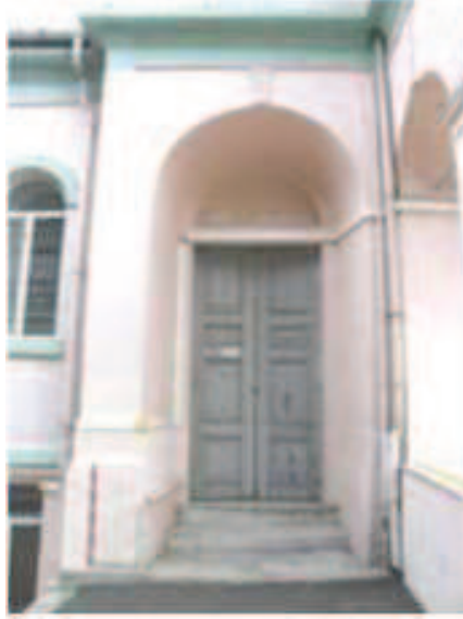
Fotoğraf 143: Kuzeydoğu Kanadı İç Cephe**
