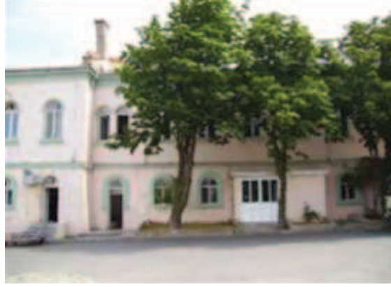
Fotoğraf 99: Kuzeybatı Kanadı Dış Cephe**
