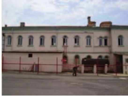
Fotoğraf 94: Kuzeydoğu Kanadı Dış Cephe**
