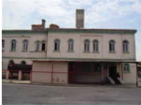
Fotoğraf 95: Kuzeydoğu Kanadı Dış Cephe**
