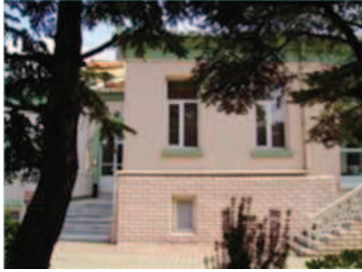
Fotoğraf 116: Güneydoğu Kanadı İç Cephe**
