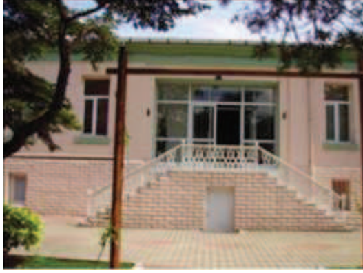
Fotoğraf 115: Güneydoğu Kanadı İç Cephe**
