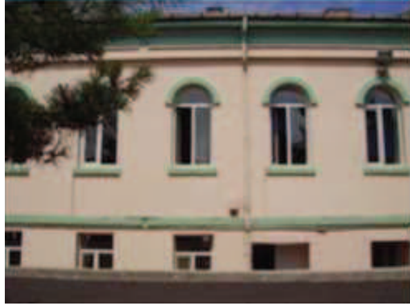
Fotoğraf 136: Kuzeydoğu Kanadı İç Cephe**
