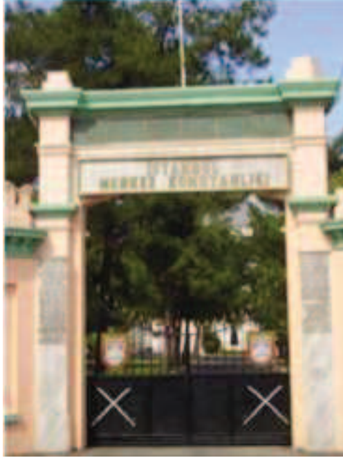
Fotoğraf 52: Ana Giriş Kapısı Yol Cephesi**
