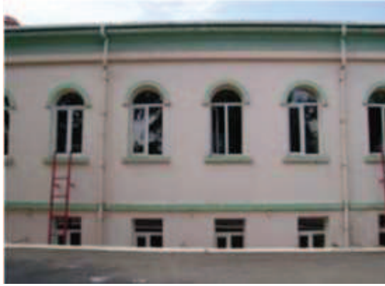
Fotoğraf 160: Kuzeybatı Kanadı İç Cephe**
