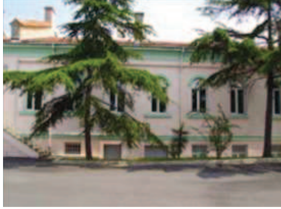
Fotoğraf 122: Güneydoğu Kanadı İç Cephe**
