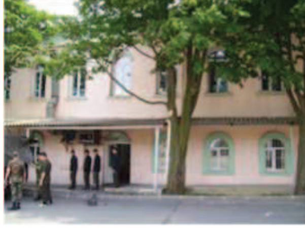
Fotoğraf 102: Kuzeybatı Kanadı Dış Cephe**
