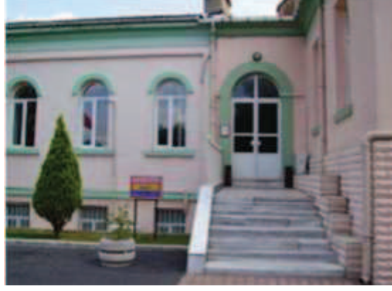
Fotoğraf 119: Güneydoğu Kanadı İç Cephe**
