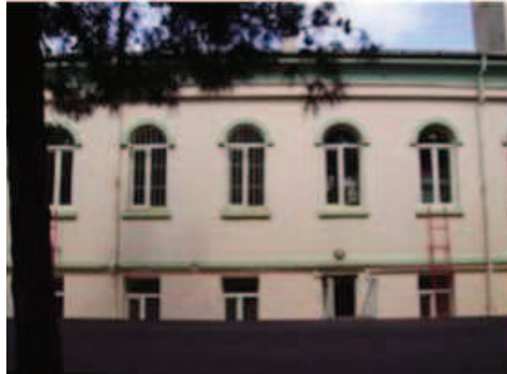
Fotoğraf 150: Kuzeydoğu Kanadı İç Cephe**
