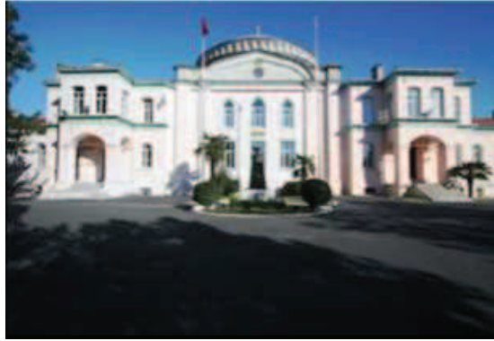
Fotoğraf 139: Kuzeydoğu Kanadı İç Cephe**
