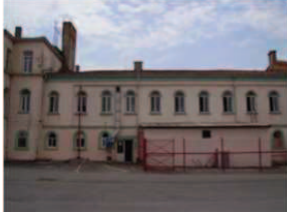
Fotoğraf 93: Kuzeydoğu Kanadı Dış Cephe**
