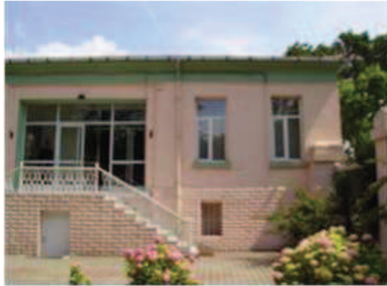
Fotoğraf 114: Güneydoğu Kanadı İç Cephe**
