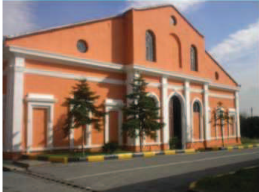
Demirkapı Kışlası Ek Yapı*
