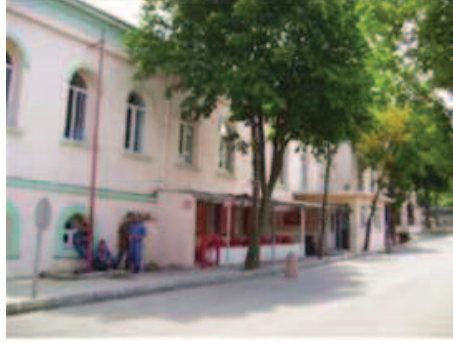
Fotoğraf 105: Kuzeybatı Kanadı Dış Cephe**
