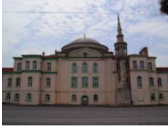
Fotoğraf 83: Kuzeydoğu Kanadı Dış Cephe**
