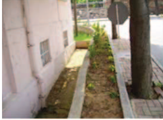
Fotoğraf 113: Kuzeybatı Kanadı Dış Cephe**
