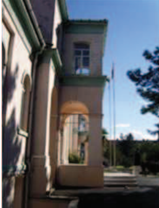
Fotoğraf 144: Kuzeydoğu Kanadı İç Cephe**
