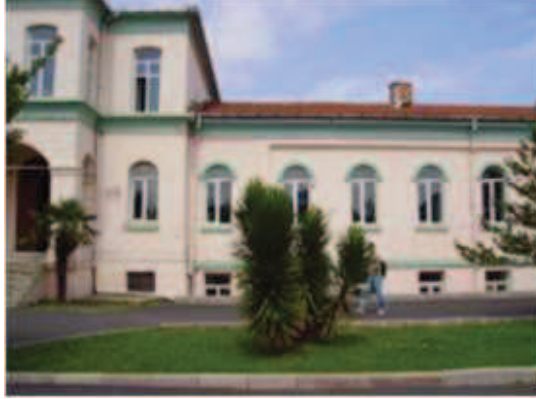
Fotoğraf 138: Kuzeydoğu Kanadı İç cephe**
