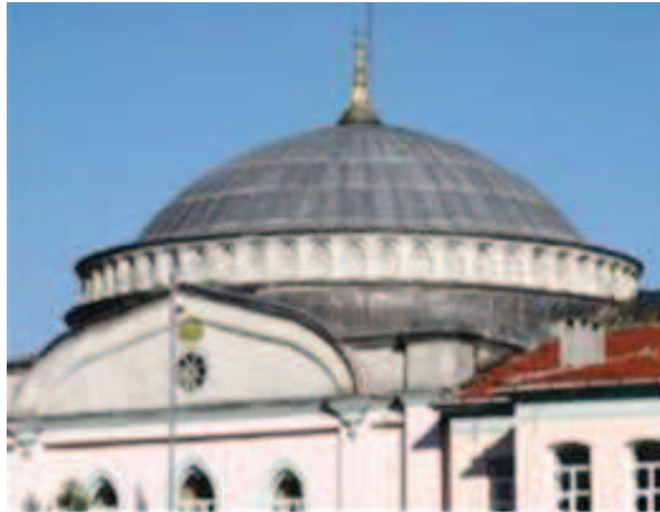
Fotoğraf 140: Kuzeydoğu Kanadı İç Cephe**
