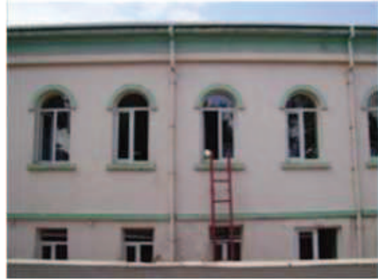
Fotoğraf 161 Kuzeybatı Kanadı İç Cephe**
