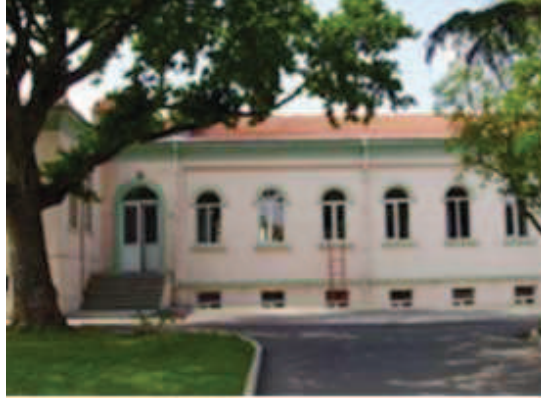
Fotoğraf 159: Kuzeybatı Kanadı İç Cephe**
