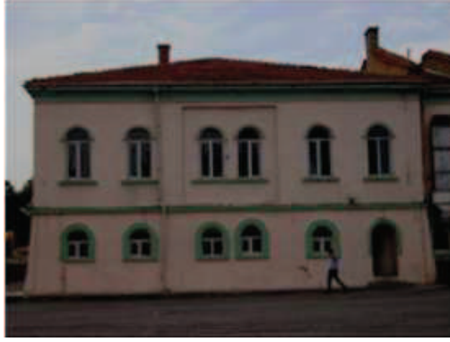
Fotoğraf 81: Kuzeydoğu Kanadı Dış Cephe**
