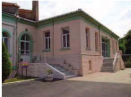
Fotoğraf 117: Güneydoğu Kanadı İç Cephe**
