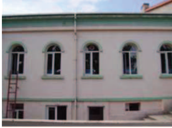
Fotoğraf 162: Kuzeybatı Kanadı İç Cephe**
