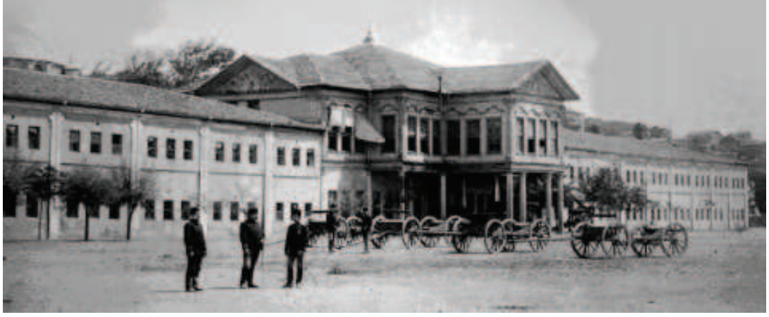
Fotoğraf 4: Humbaracılar Kışlası Ön Cephesi*
