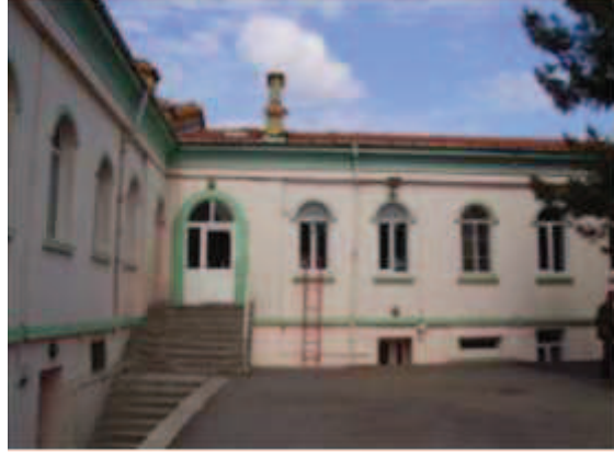
Fotoğraf 152: Kuzeydoğu Kanadı İç Cephe**
