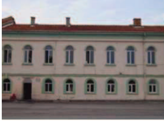
Fotoğraf 90: Kuzeydoğu Kanadı Dış Cephe**
