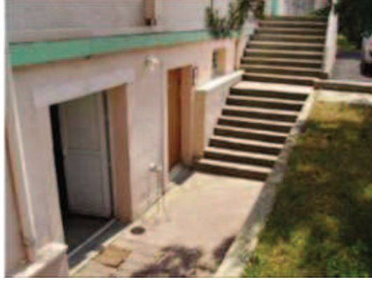
Fotoğraf 125: Güneydoğu Kanadı İç Cephe**
