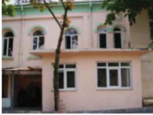
Fotoğraf 108: Kuzeybatı Kanadı Dış Cephe**
