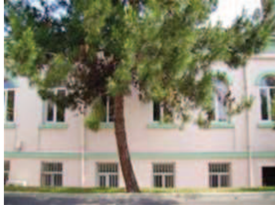
Fotoğraf 129: Güneydoğu Kanadı İç Cephe**
