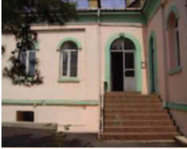
Fotoğraf 132: Kuzeydoğu Kanadı İç Cephe**
