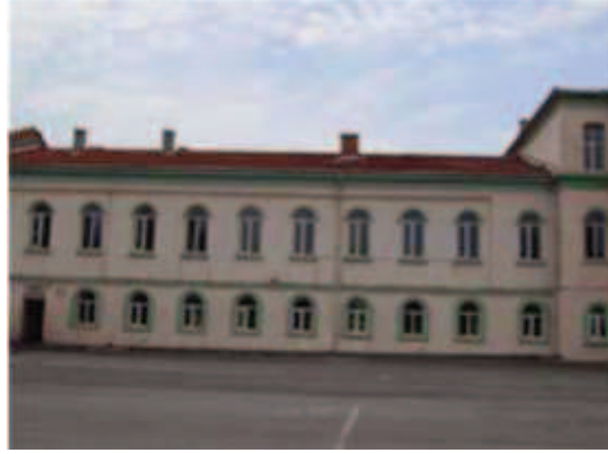
Fotoğraf 91: Kuzeydoğu Kanadı Dış Cephe**
