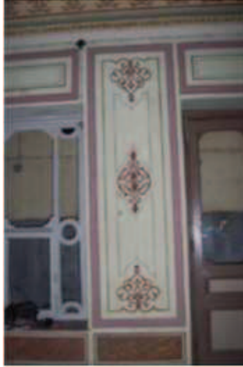
Giriş Kat Ara Duvar Görüntüsü**
