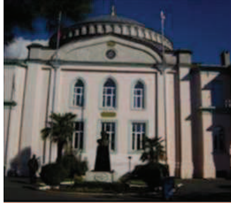
Fotoğraf 146: Kuzeydoğu Kanadı İç Cephe**
