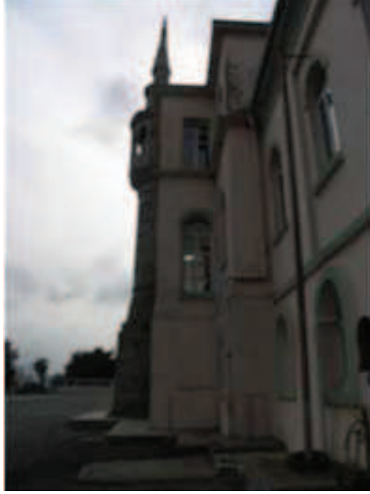
Fotoğraf 88: Kuzeydoğu Kanadı Dış Cephe**
