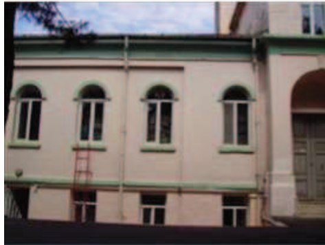
Fotoğraf 147: Kuzeydoğu Kanadı İç Cephe**
