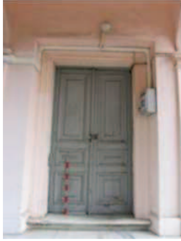
Fotoğraf 145: Kuzeydoğu Kanadı İç Cephe**
