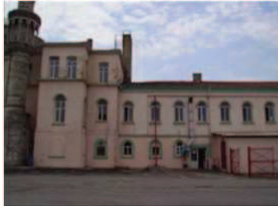
Fotoğraf 92: Kuzeydoğu Kanadı Dış Cephe**
