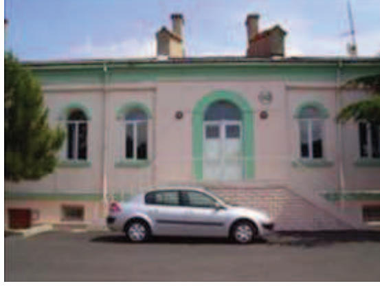
Fotoğraf 124: Güneydoğu Kanadı İç Cephe**
