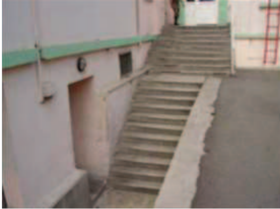
Fotoğraf 170: Kuzeybatı Kanadı İç Cephe**
