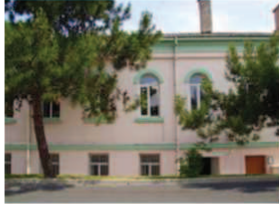
Fotoğraf 128: Güneydoğu Kanadı İç Cephe**
