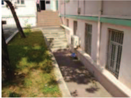
Fotoğraf 126: Güneydoğu Kanadı İç Cephe**
