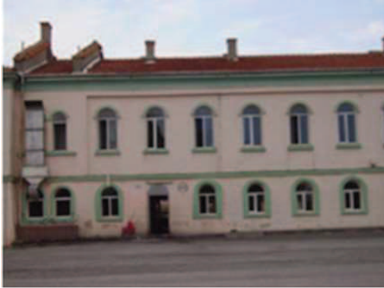
Fotoğraf 89: Kuzeydoğu Kanadı Dış Cephe**
