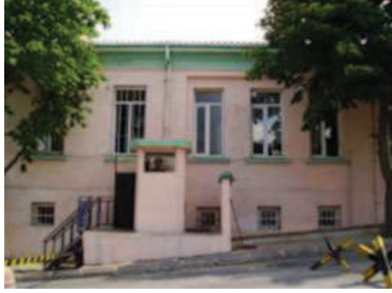
Fotoğraf 111: Kuzeybatı Kanadı Dış Cephe**
