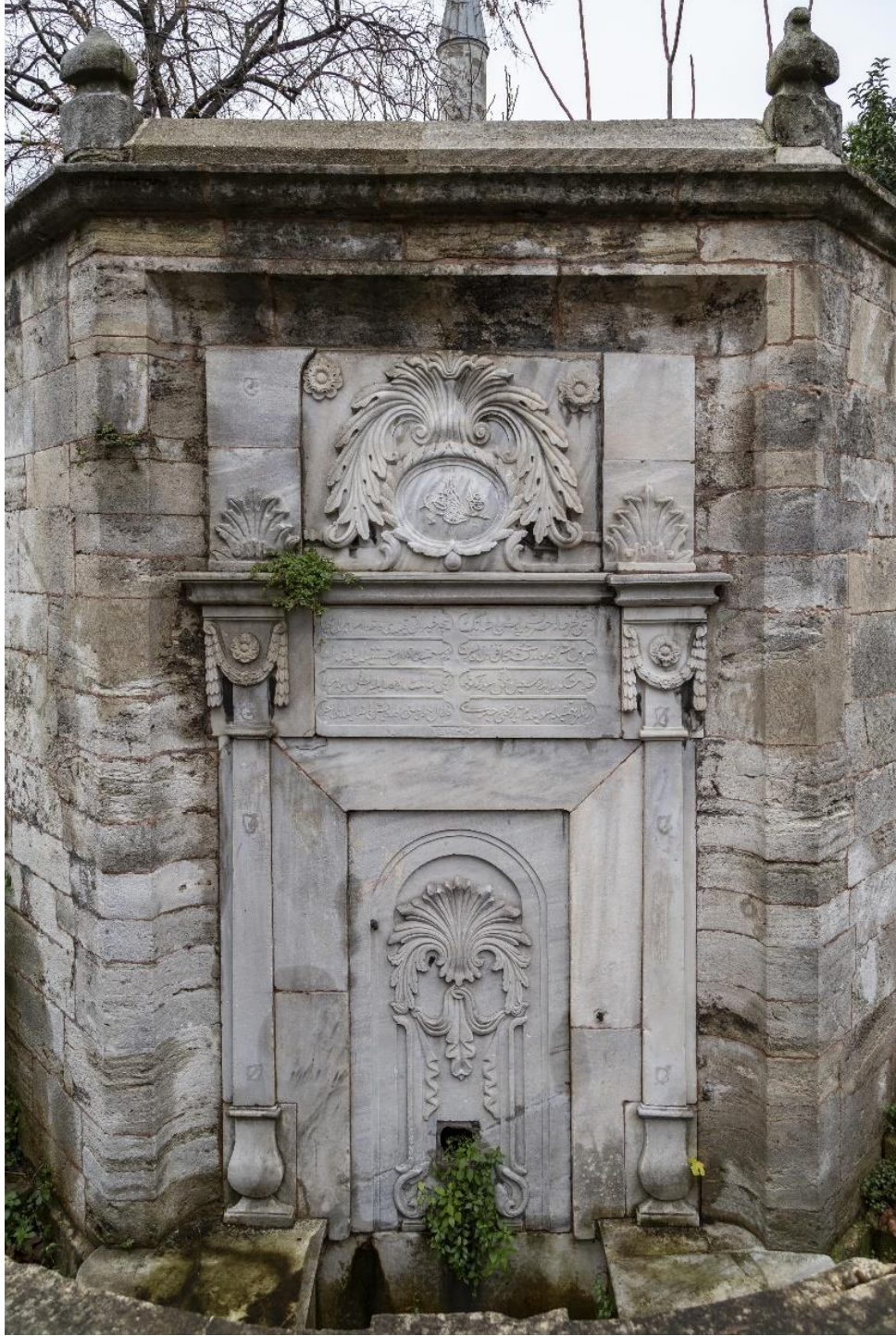
Fotoğraf 99: Takkeci İbrahim Ağa Külliyesi Derviş Mehmed Paşa Çeşmesi
