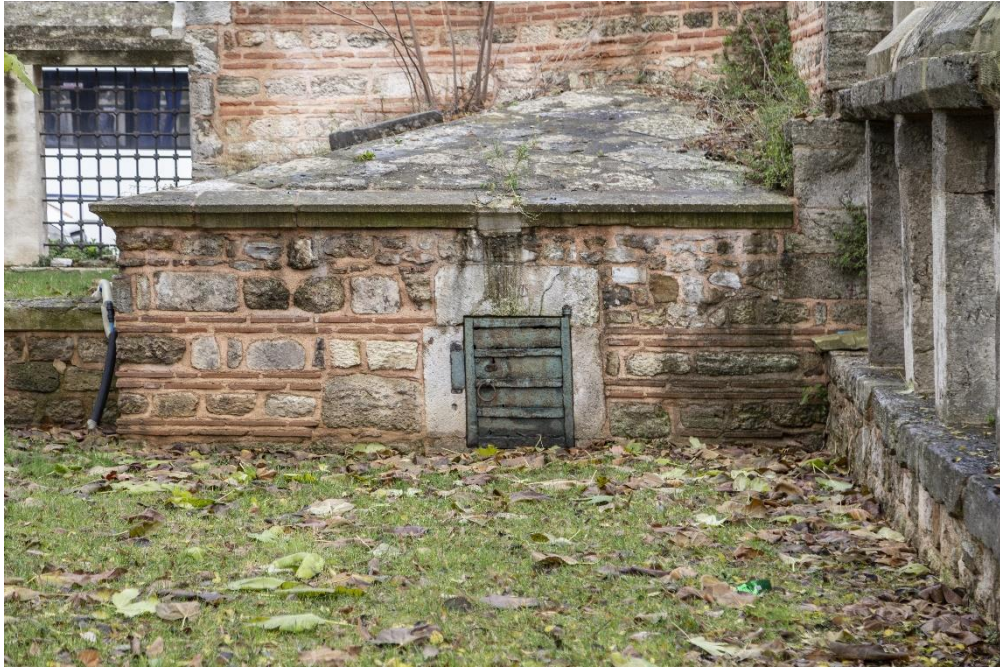
Takkeci İbrahim Ağa Külliyesi Derviş Mehmed Paşa Çeşmesi'nin Avlu İçinde Kalan Su Haznesi
