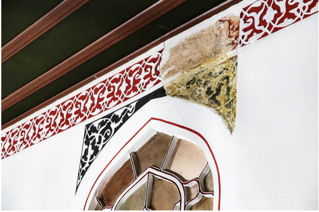
Fotoğraf 82: Takkeci İbrahim Ağa Camii'nde Görülen Malakari Bezemelerin Eski Halinden Kalan İzler Ve Yenilenmiş Hali
