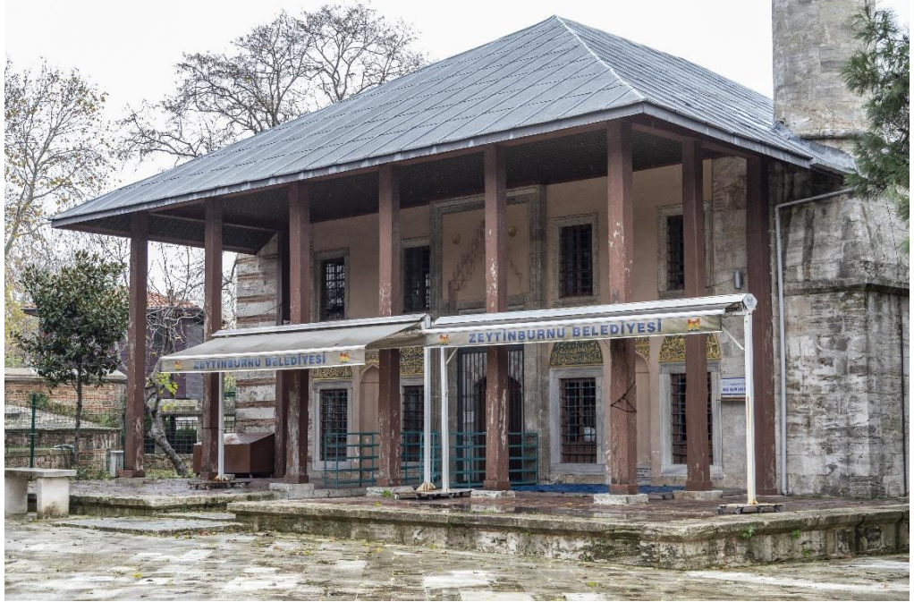
Takkeci İbrahim Ağa Camii Günümüzdeki Çatı Sistemi Ve Son Cemaat Yeri
