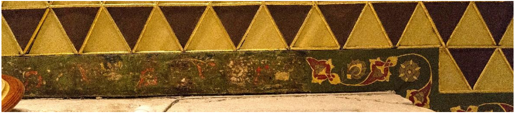
Takkeci İbrahim Ağa Camii Ahşap Mahfil Tavanı Etrafında Görülen Kelemişi
