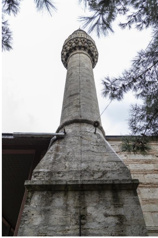
Fotoğraf 38: Takkeci İbrahim Ağa Camii Minaresi
