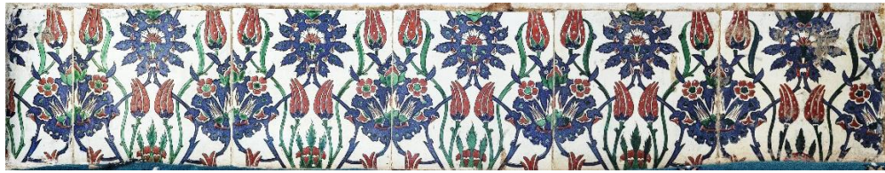
Fotoğraf 129: Mihrap Duvarında Yer Alan S1
