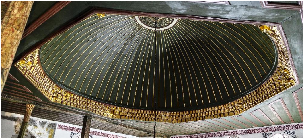
Fotoğraf 69: Takkeci İbrahim Ağa Camii Ahşap Kubbesi
