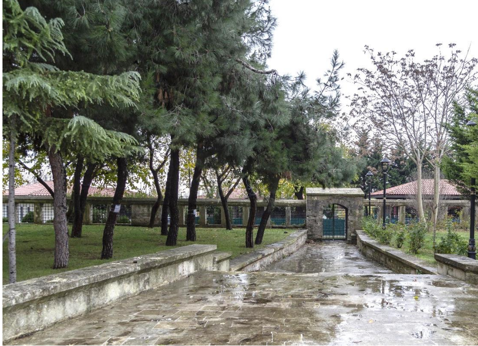
Takkeci İbrahim Ağa Camii Güney Avlu Duvarı Ve Güney Giriş Kapısı
