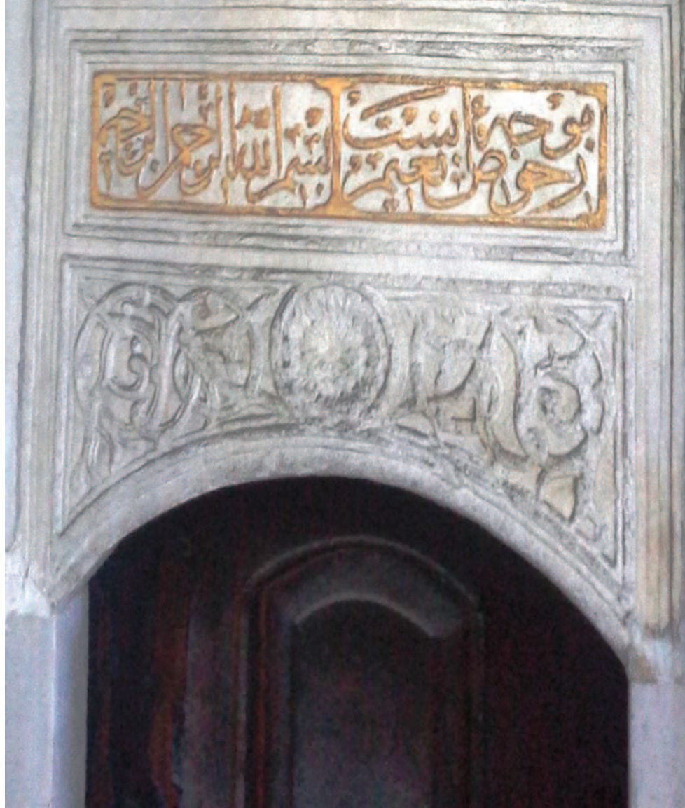
Saliha Sultan Sebili Basık Kemerli Kapı Süslemesi ve Kitabes Detayı.
