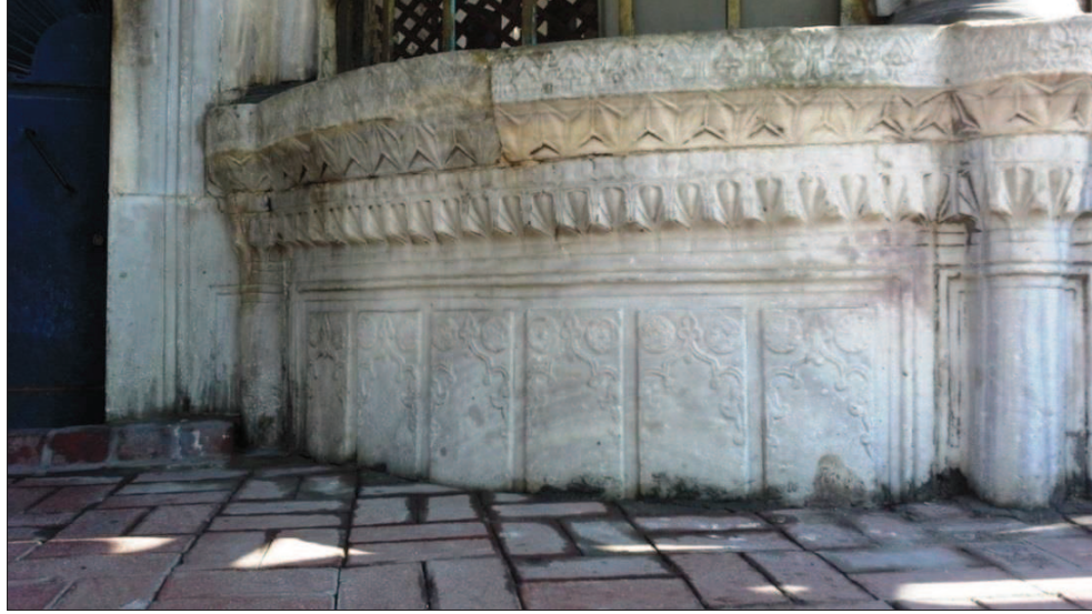
Damat İbrahim Paşa Sebili'nin Sütun Plastırlar ile Bölümlenmiş Dış Bükey Kaide.
