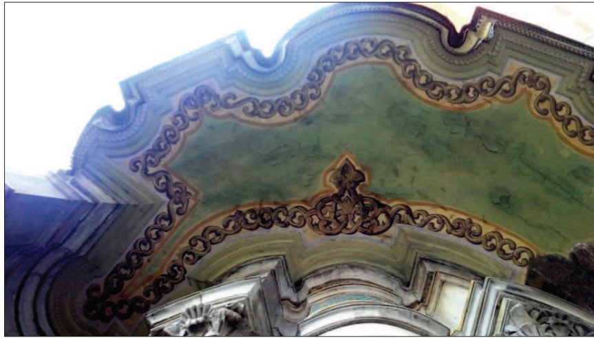
Seyyid Hasan Paşa Sebili Dilimli Saçak ve Kalem İşi Süsleme Detayı.
