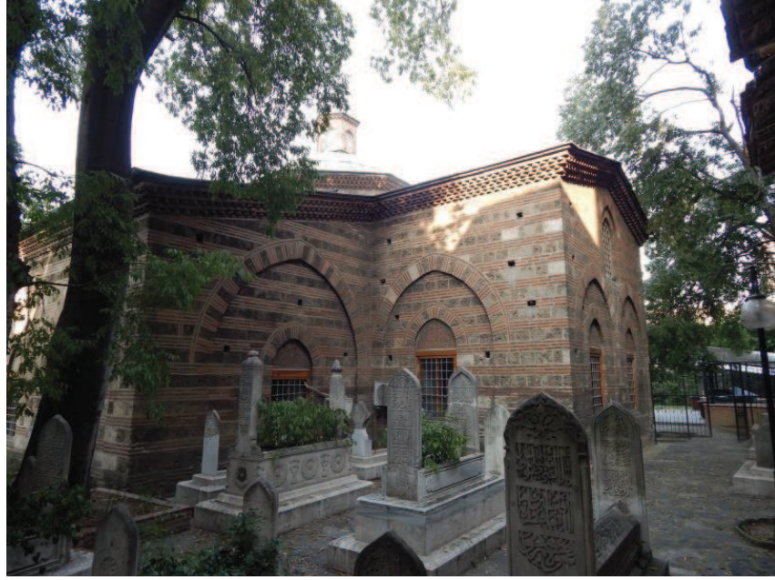
Bursa Timurtaş Paşa Camii, Dış Cephelerin Kemer Düzeni
