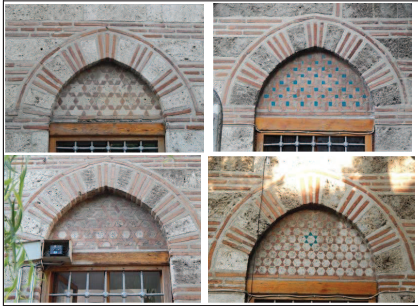
Bursa Timurtaş Paşa Camii, Alt Sıra Pencere Kemer Alınlıklarında Yer Alan Geometrik Bezemeler
