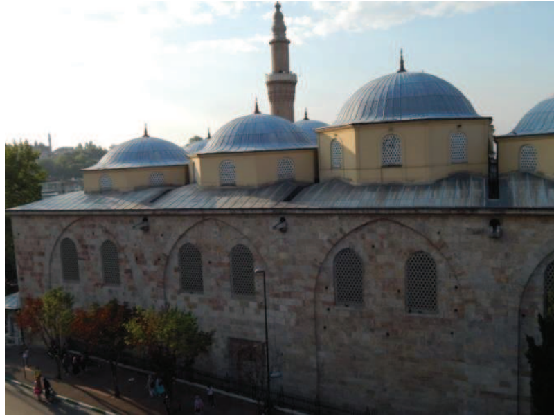
Bursa Ulu Camii, Güney Cephenin Kemer Düzeni.
