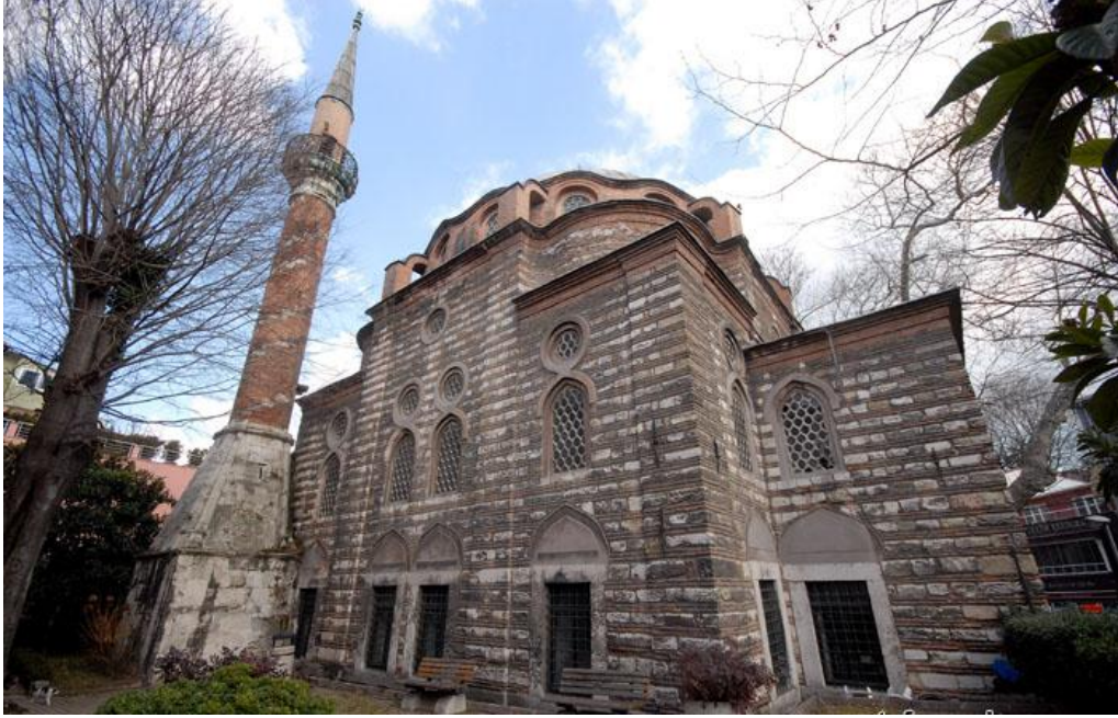
Batı Cephesinden Zeyneb Sultan Camii Pencerelelerinin Görünüşü
