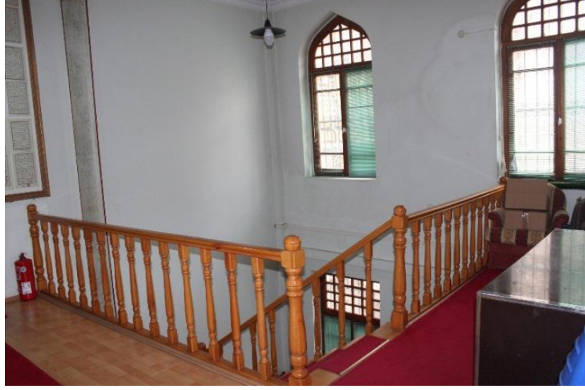
Fotoğraf 59: Medresenin Bodrum Kata İnişi Sağlayan İç Merdivenleri
