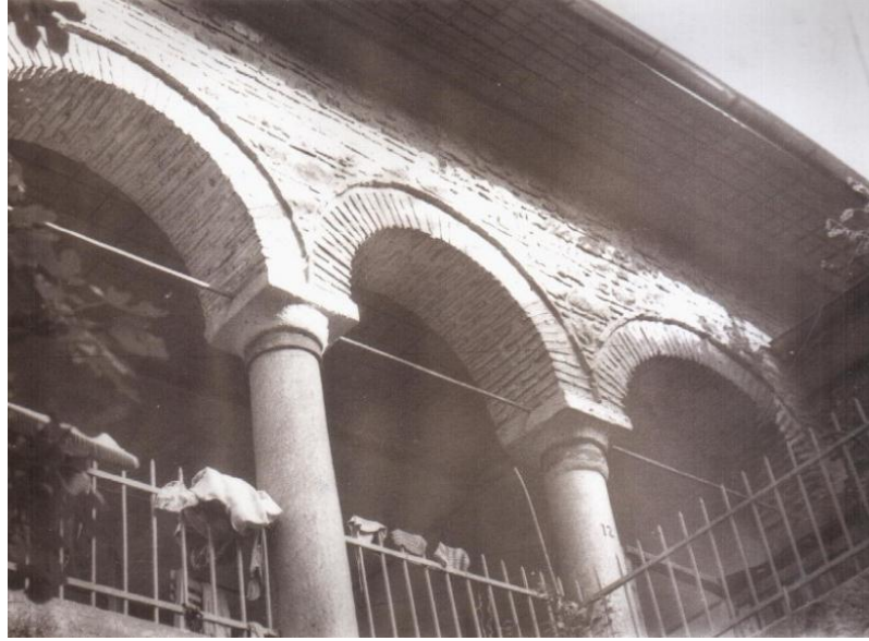
Sıbyan Mektebi Giriş Revağı Sütunları Arasındaki Korkuluklar (1982)
