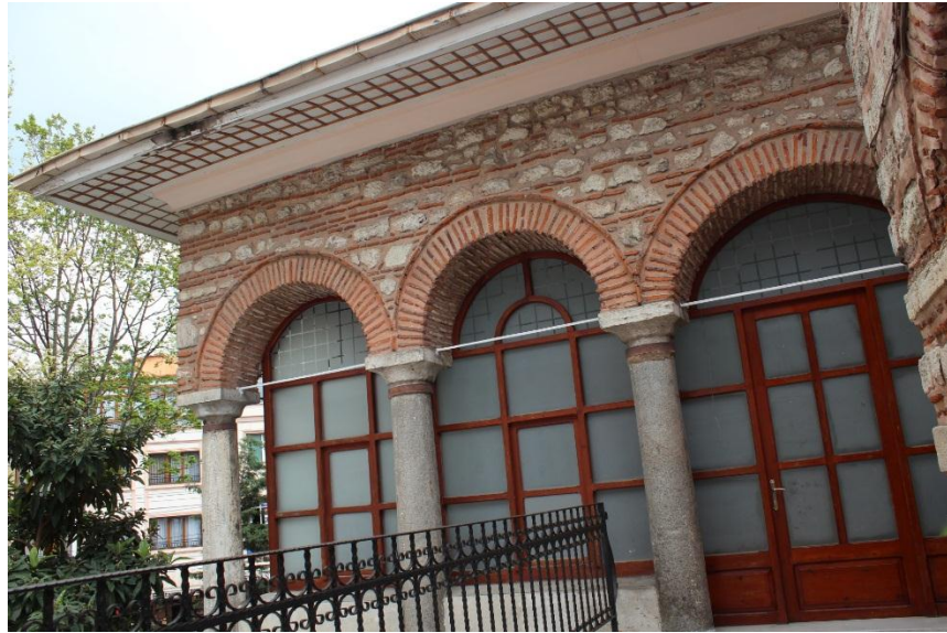
Sıbyan Mektebi Giriş Revağı
