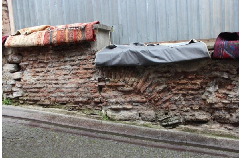
Fotoğraf 51: Avlu Duvarında Raspa İle Ortaya Çıkarılan Tuğla Kemerli Kısım
