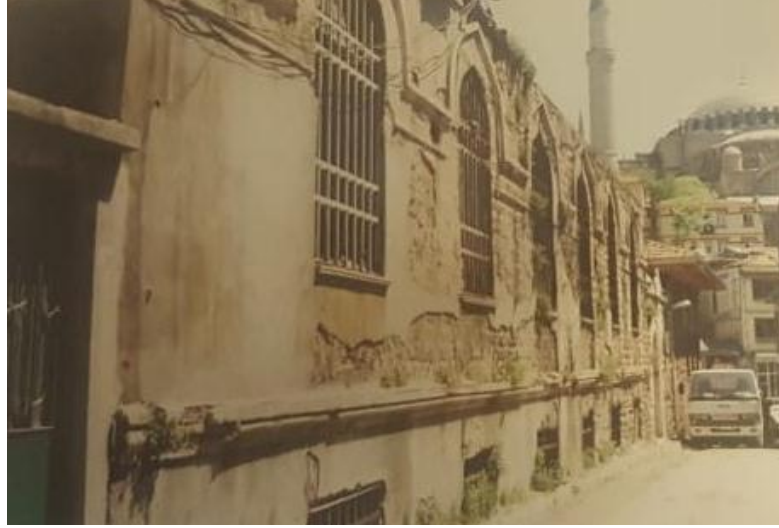
Fotoğraf 54: Medresenin 1997 Onarımı Öncesindeki Durumu
