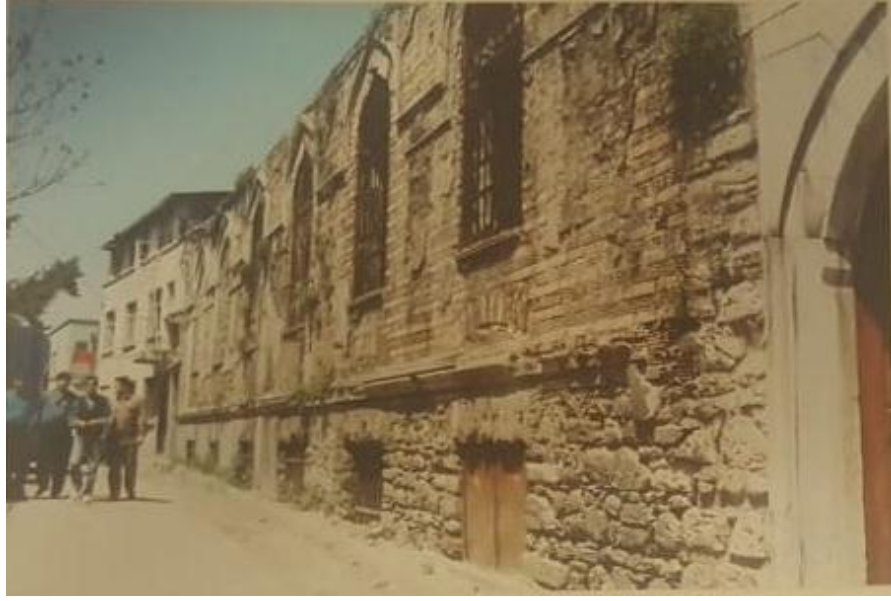
Fotoğraf 62: Medresenin Duvar Örgüsü
