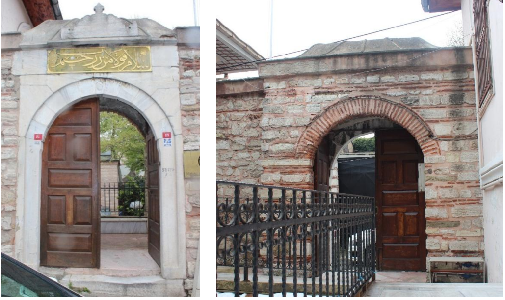
Külliyenin Duâcızâde İmzalı Kitabenin Bulunduğu Güneybatı Giriş Kapısı
