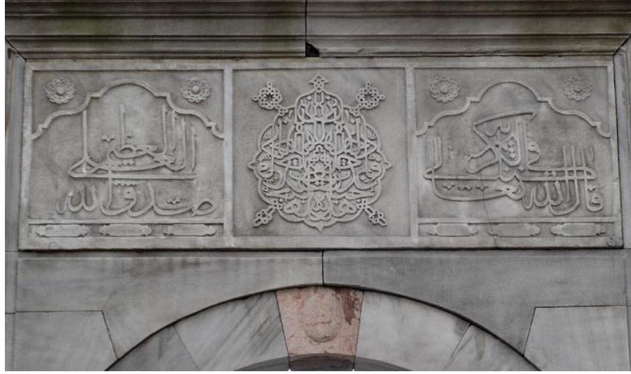
Fotoğraf 7: İç Avluya Girişi Sağlayan Doğu Giriş Kapısı Üzerinde Bulunan Kitabe
