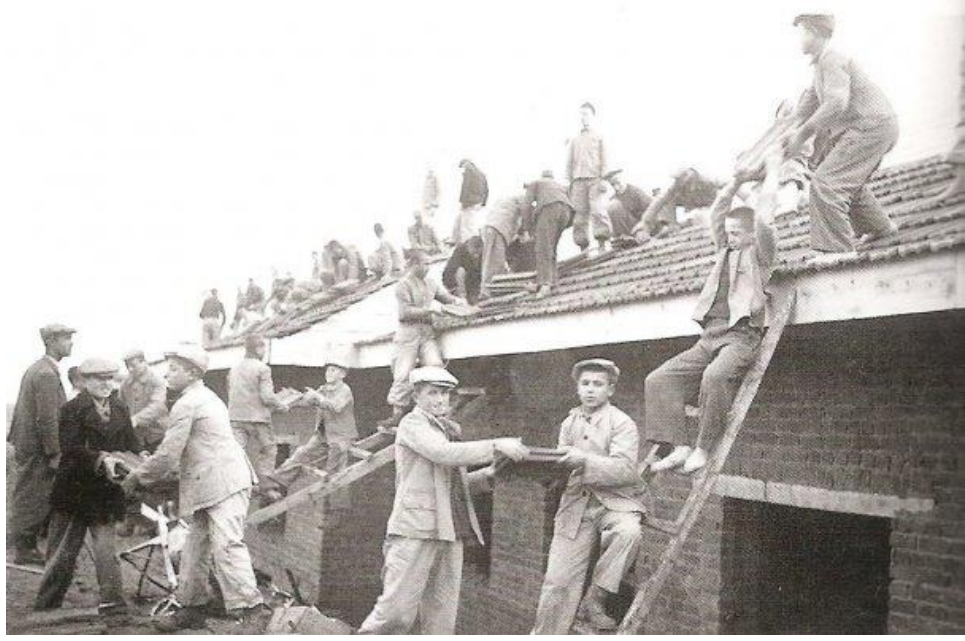
Resim 52: Enstitü binası yapımına yardım eden öğrenciler
