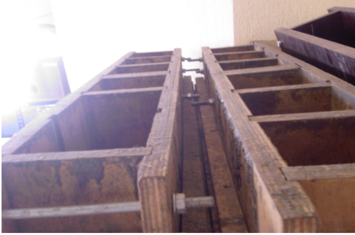
Şekil 6.7. Plywood kalıplardan görünüş
