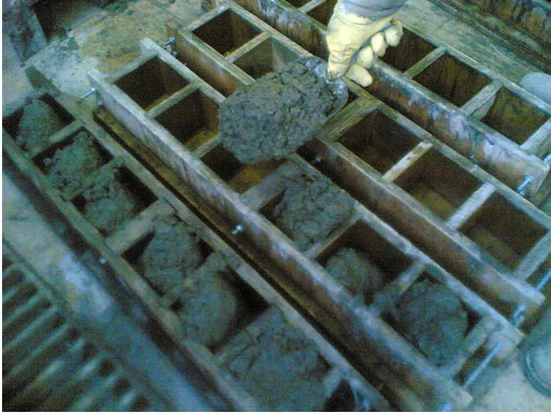
Şekil 6.11. Kalıplara beton karışımı koyulurken görünümü
