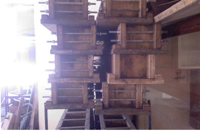
Şekil 6.8. Plywood kalıpların yandan görünüşü
