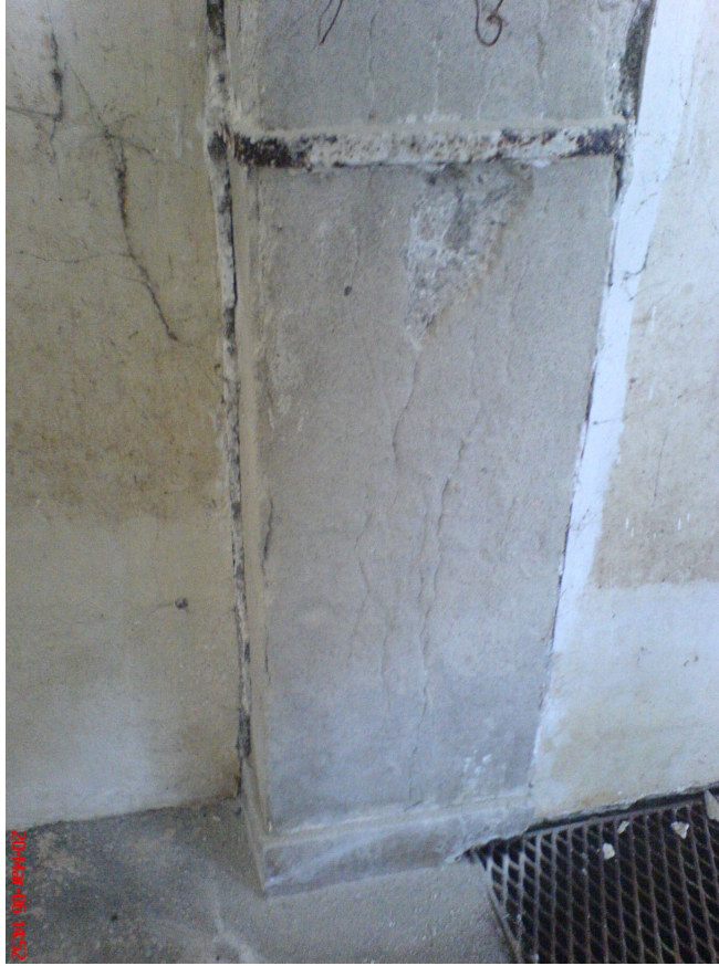
Şekil 4.4. Tuz etkilerine maruz kalmış kolon
