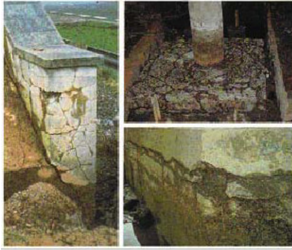
řekil 4.11. ASR den kaynaklanan atlaklara ait grnřler
