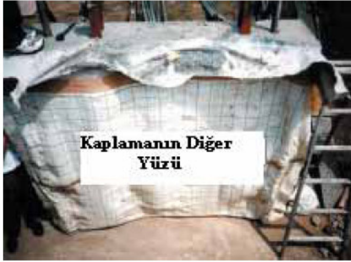
Şekil 4.19. Kaplama yöntemiyle betonarme bir yapının korunması
