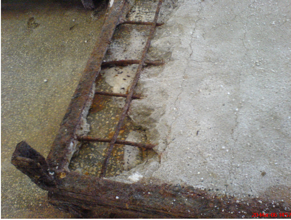
Şekil 4.6. Hayvan derilerinin tuzlanarak üstüne koyulduğu betonarme palet yakın görünüm
