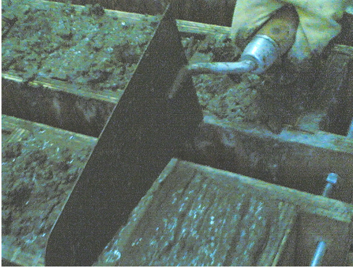
Şekil 5.4. Kalıplardaki betonun tesviye işlemi
