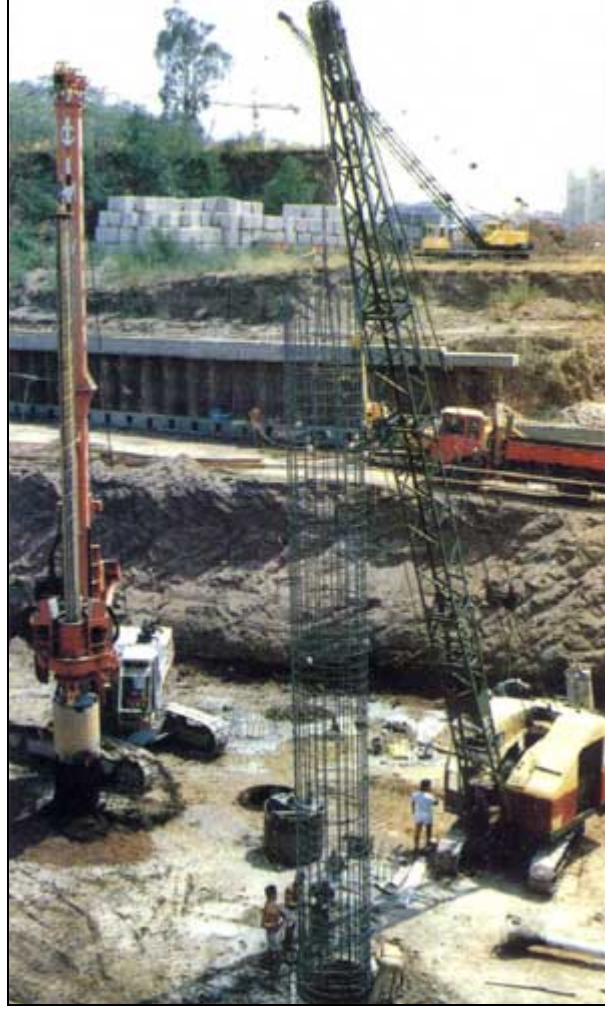
Resim 7.18. Donatı kafesinin zemine indirilmesi [109]
