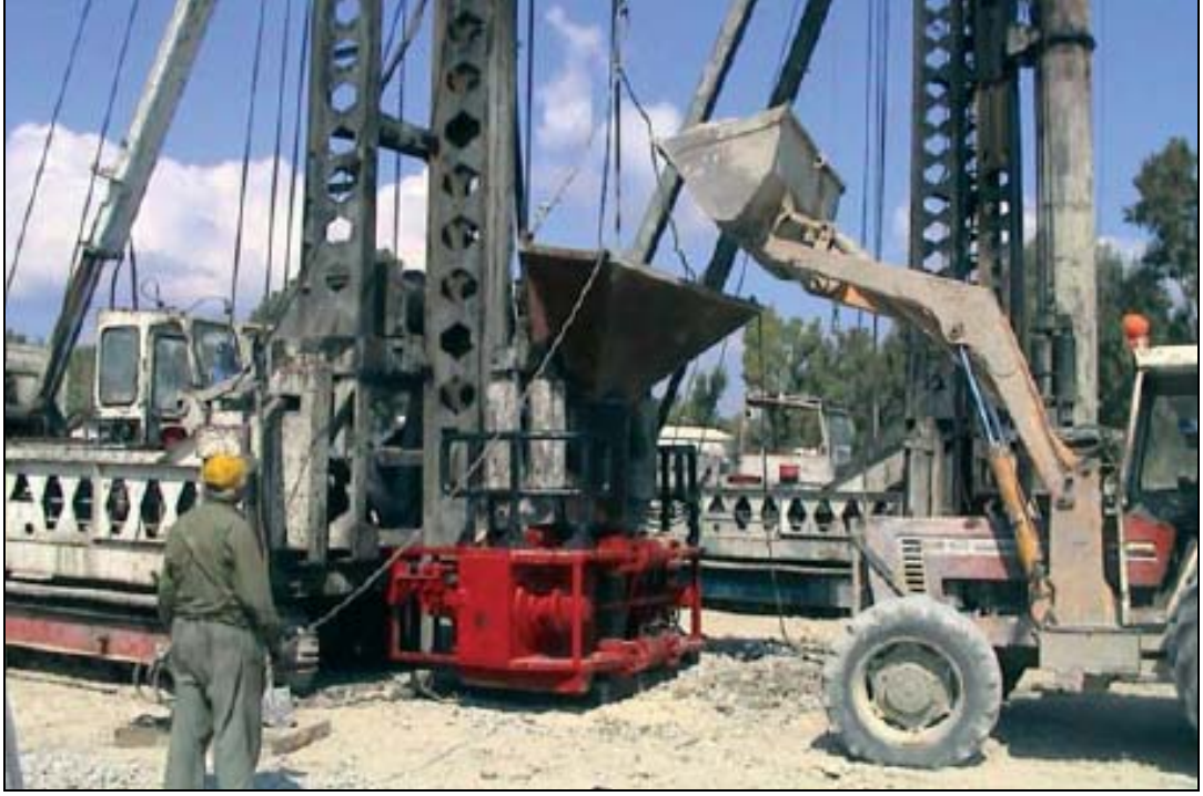
Resim 7.21. Muhafaza borusu içine çakıl dökülmesi [34]
