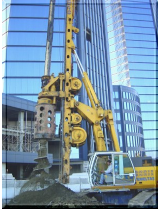
Resim 7.17. Foraj esnasında dışarı atılan zemin [100]
