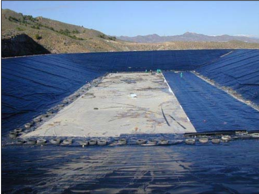
Resim 7.14. Geomembran uygulaması
