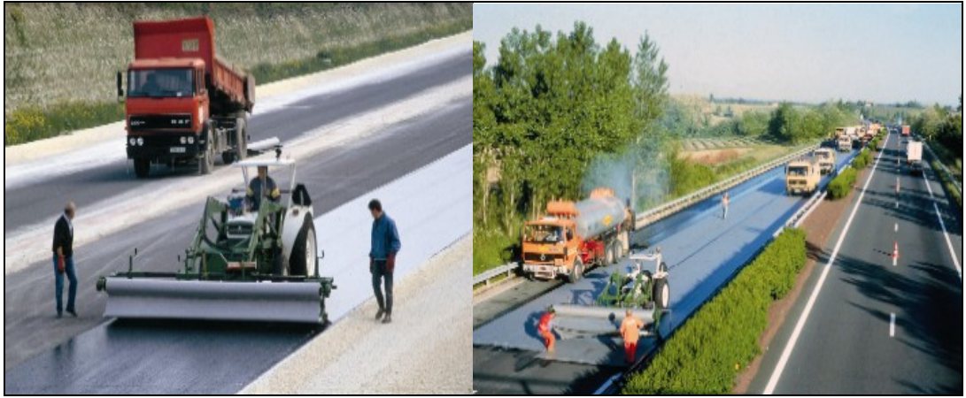
Resim 7.11a-11b. Asfalt geotekstill uygulaması – takviye geotekstilller
