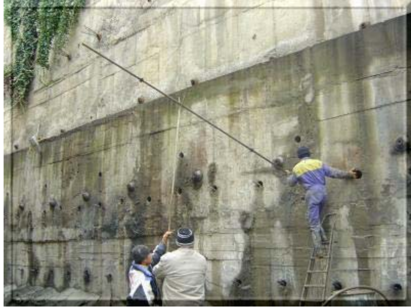
EK B.6. Donatının deliklere yerleřtirilmesi
