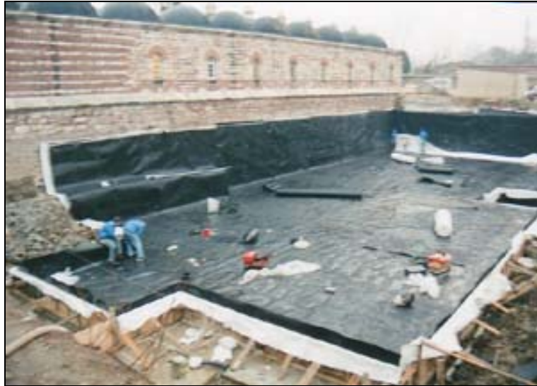
Resim 7.13. Geomembran temel uygulaması
