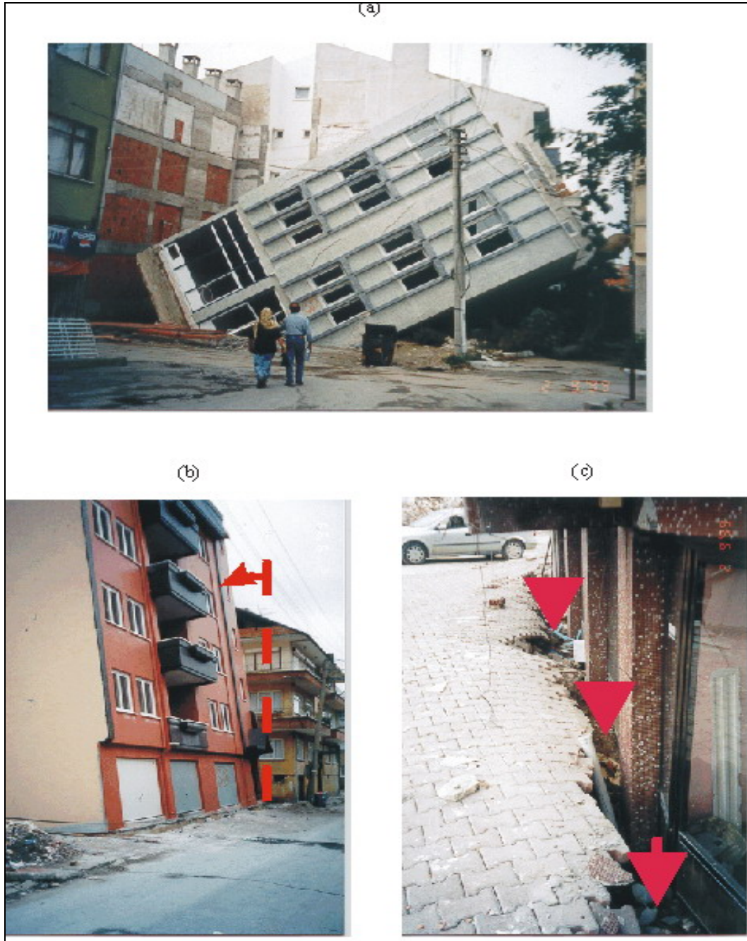
Resim 5.1. Adapazarında sivilaşma sonucu devrilmiş (a), geriye yatmış (b), zemine oturmuş – gömülmüş binalar (c) [25]
