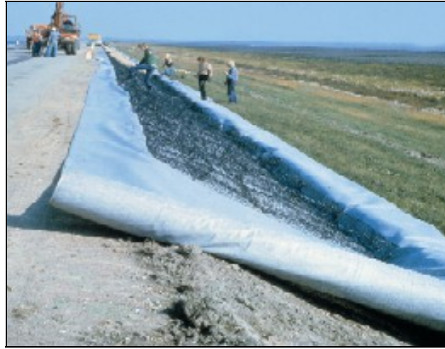
Resim 7.10. Drenaj amaçlı geotekstill uygulaması
