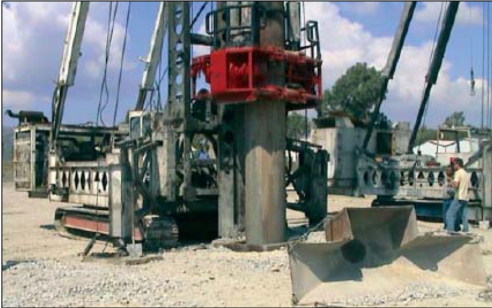
Resim 7.22. Muhafaza borusunun vibrasyonla geri çekilmesi [34]
