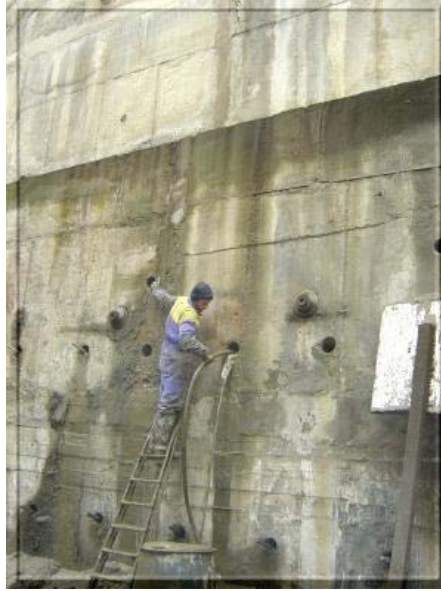
EK B.5. Deliklerin enjeksiyonla temizlenmesi
