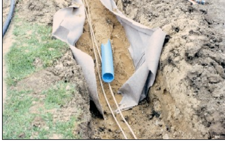
Resim 7.9. Filtrasyon amaçlı geotekstill uygulaması
