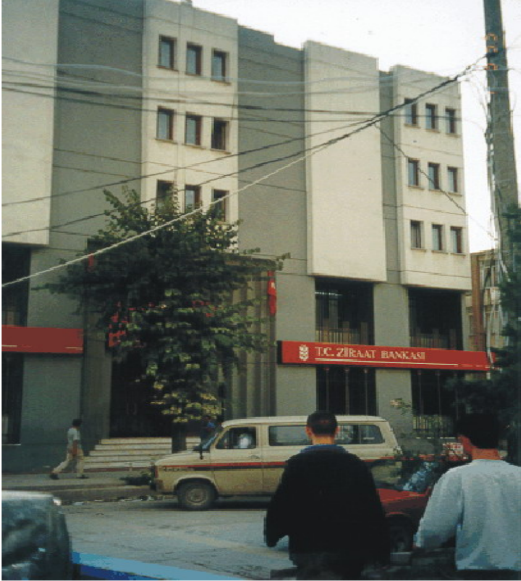
Resim 5.4. Adapazarı'nda hasarsız binalara örnek [25]
