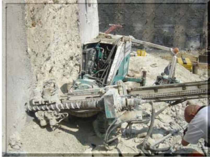
EK B.4. Zemin çivisi yöntemi için delme işlemi
