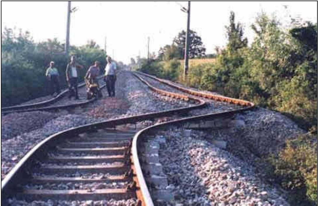
Resim 4.2. Arifiye demiryolunda meydana gelen 2.7 metrelik yanal yer deęiřtirme [42]
