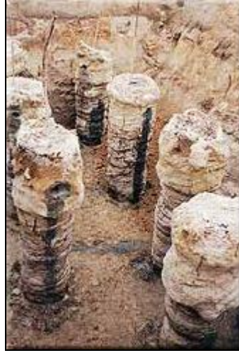
Şekil 7.23. Jet enjeksiyonu ile zemin iyileştirmesi
