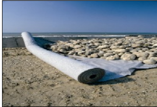
Resim 7.8. Ayırma amaçlı geotekstill
