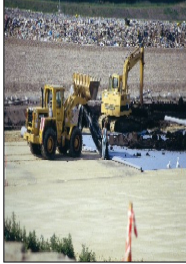
Resim 7.7. Koruma amaçlı geotekstil uygulaması
