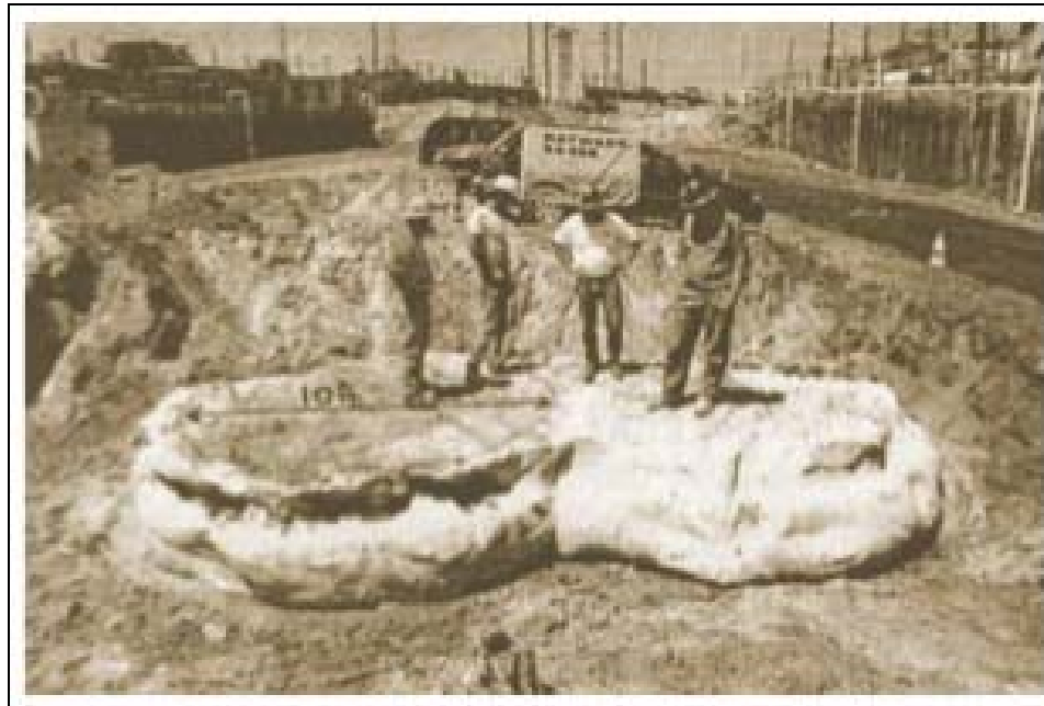
Resim 7.23. Süper Jet Uygulaması İle Büyük Çaplı Kolonların Oluşturulması [15]
