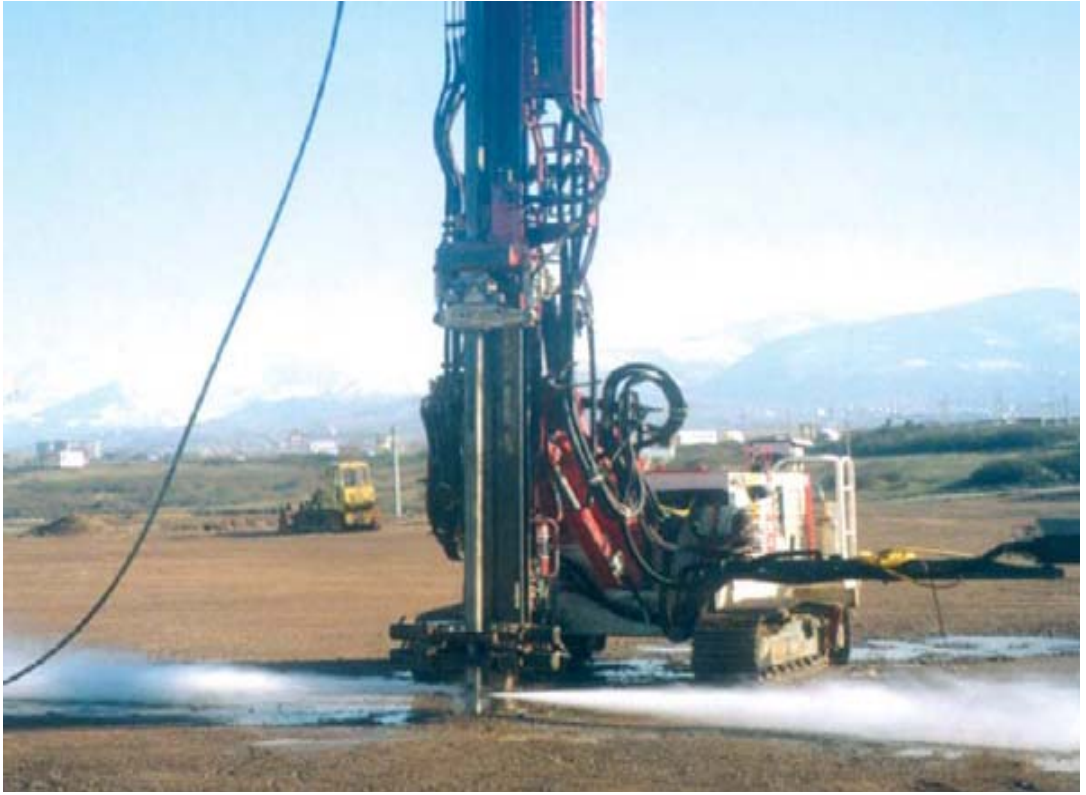
EK B.1. Jet Grout Nozzlelarından Çıkan Su Jeti Görünümü
