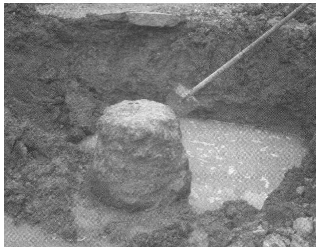
Şekil 5.21. Jet enjeksiyon yöntemiyle oluşturulan kolonun görünümü
