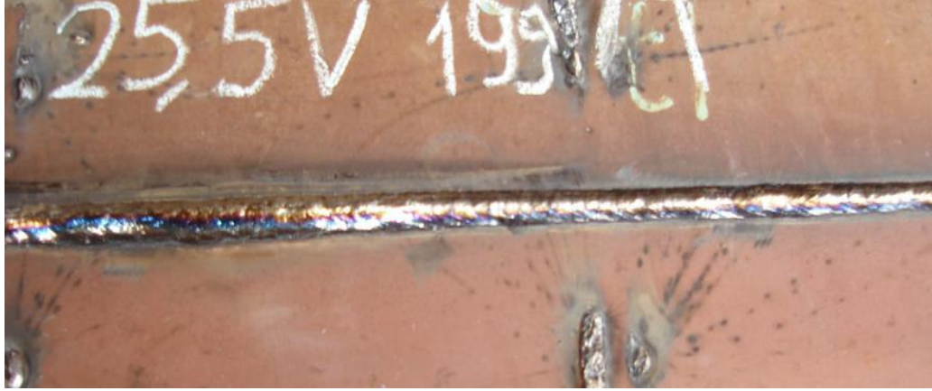
Şekil 7.3. Kaynaklı numunelerin gözle muayenesi
