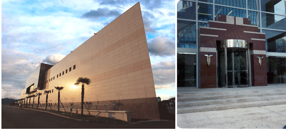
Şekil 3.10. Cephede granit uygulanması
