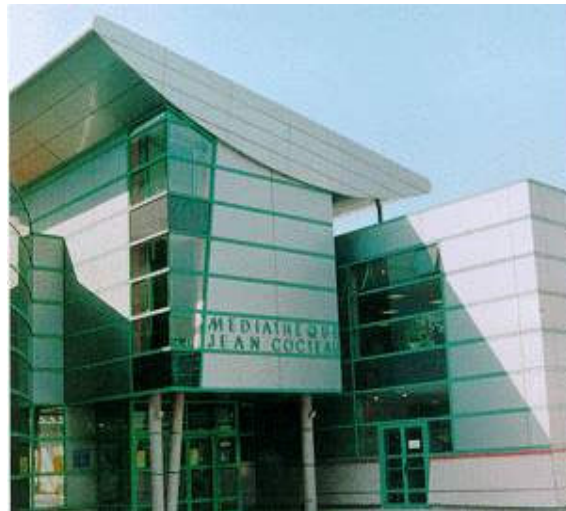
Şekil 3.16. Metal dış cephe kaplaması
