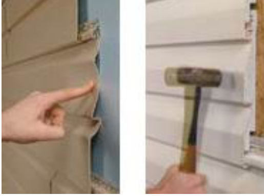
Şekil 3.20. PVC kaplama uygulaması
