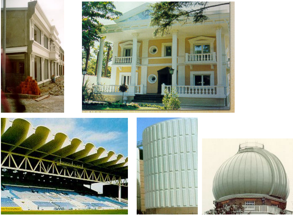
Şekil 4.14. CTP' nin cephelerde uygulanması
