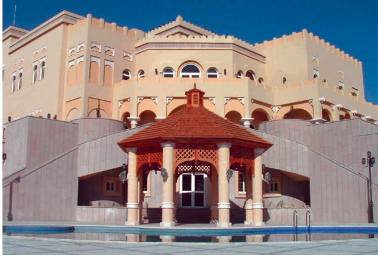
Şekil 3.11. Cephede mermer uygulanması
