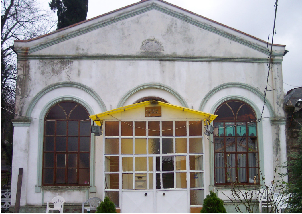
Şekil 4.10. Rahime Sultan Camii kuzey cephesinden görünüşü
