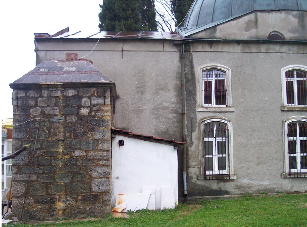
Şekil 4.4. Rahime Sultan Camii minare kaidesinin görünüşü
