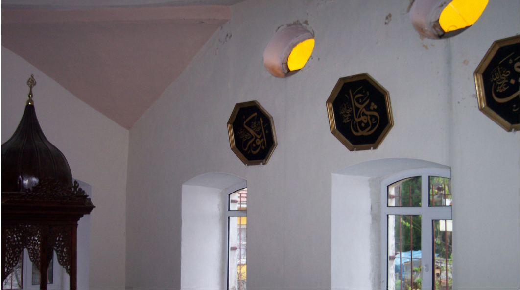
b) Cami içinde güney-batı cephe görünüşü
