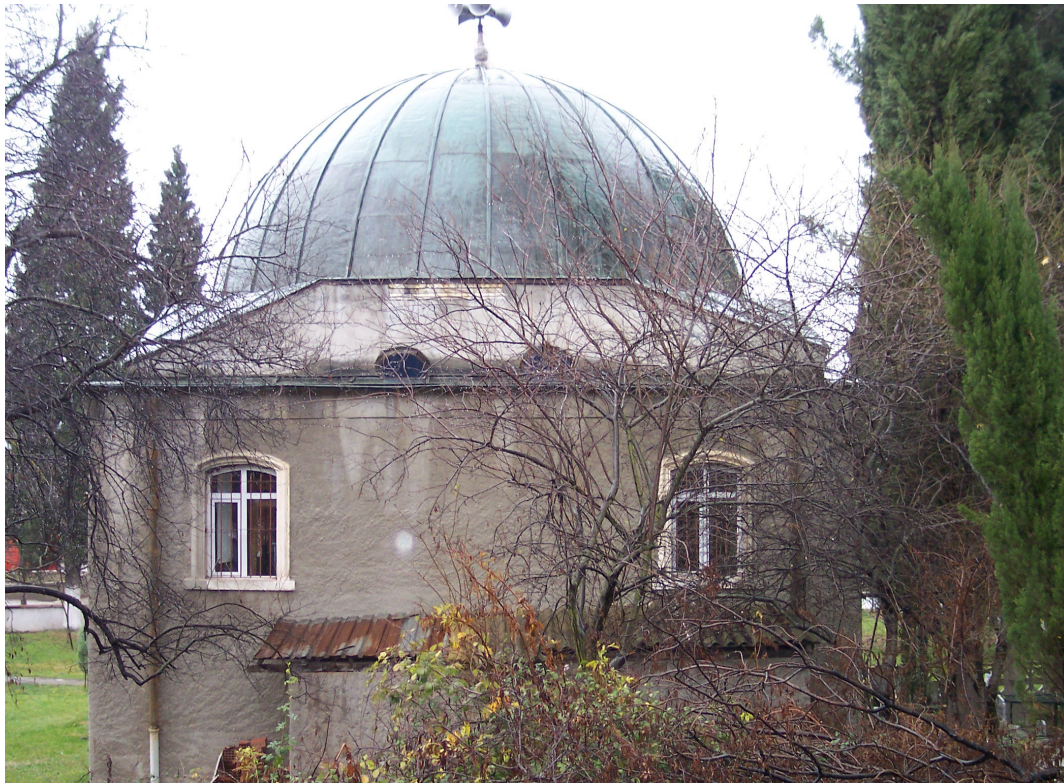
Şekil 4.12 Rahime Sultan Camii güney cephesinden görünüşü
