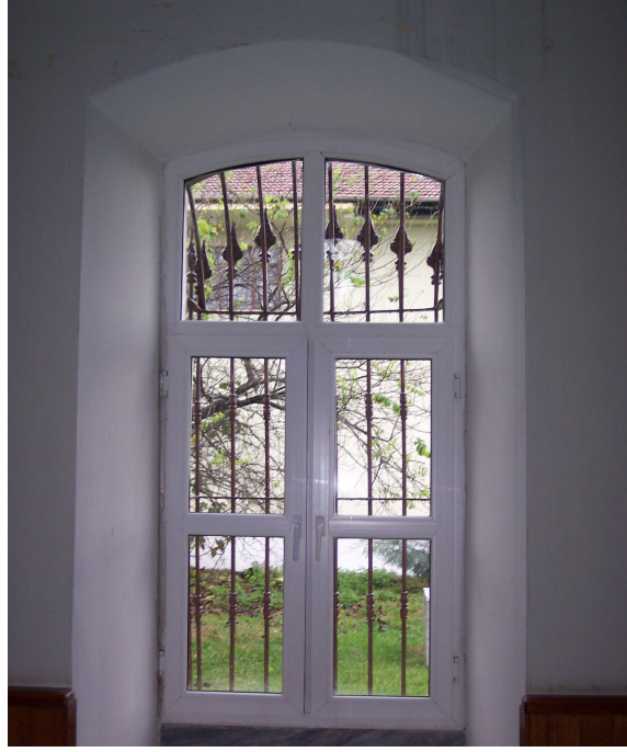
Şekil 4.9. Rahime Sultan Camii pencere-duvar görünüşü
