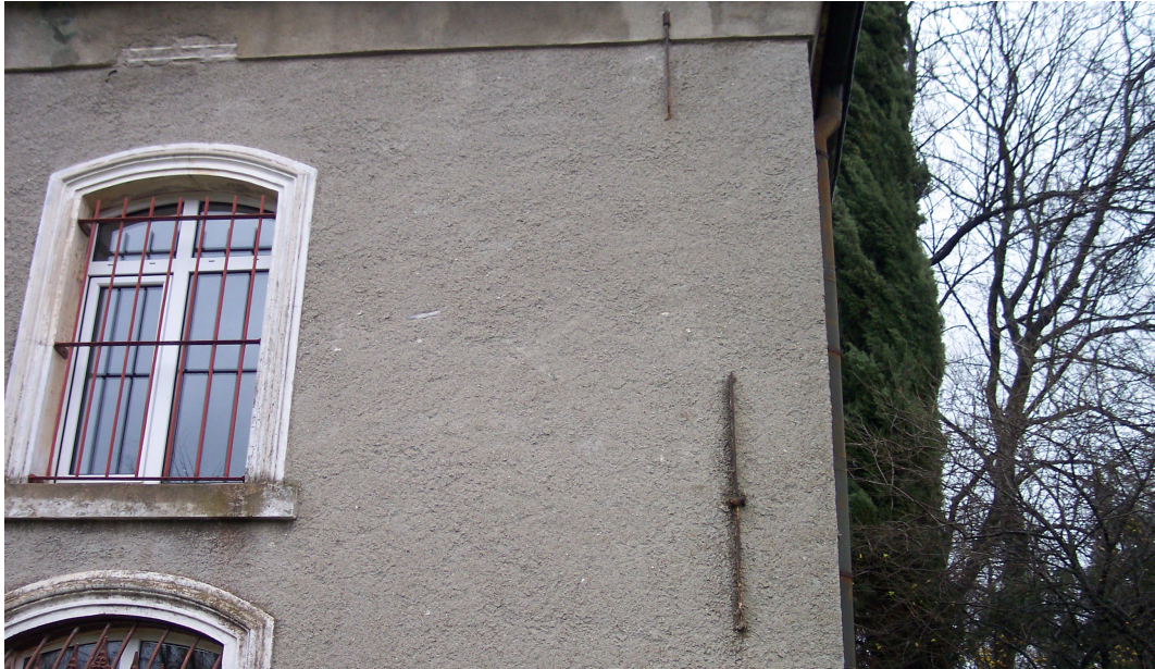
Şekil 4.14. Duvar gergi çubukları
