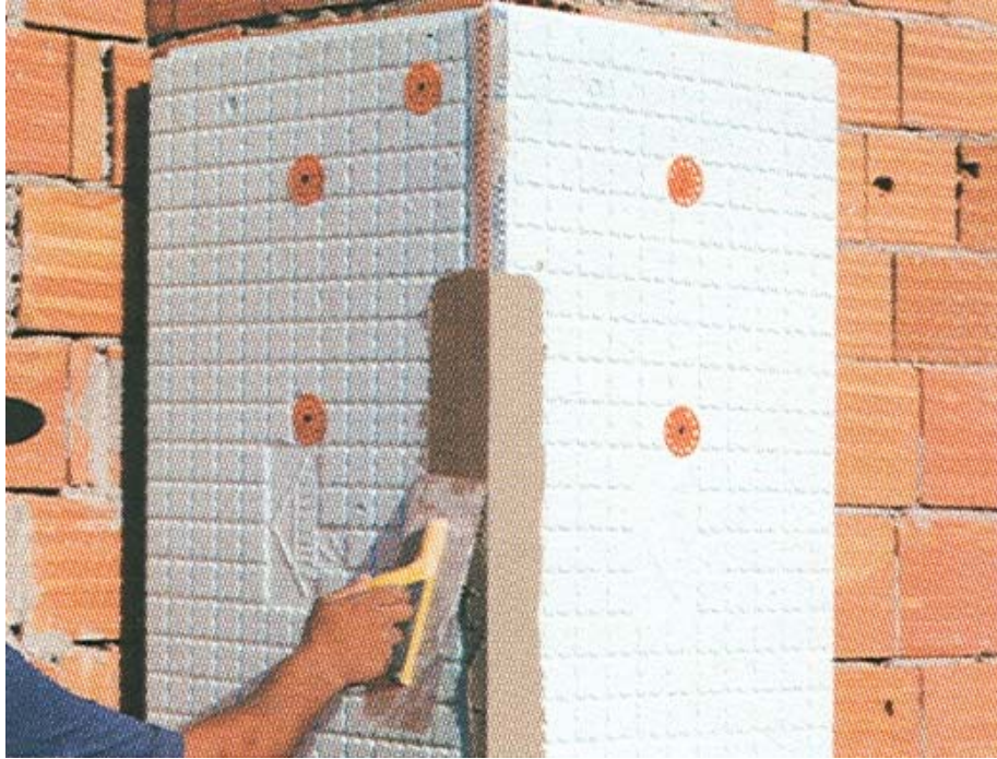
Şekil 3.17 Kenar ve köşelerin oluşturulması
