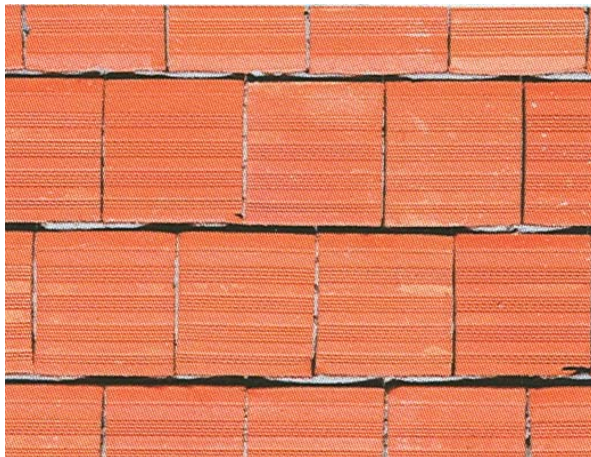
Şekil 3.13 Yüzeyin uygulamaya hazırlanması
