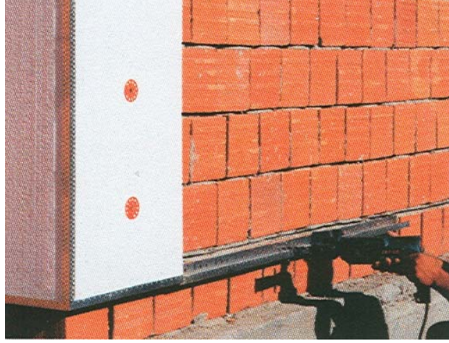
Şekil 3.14 Su basman profilinin yerleştirilmesi
