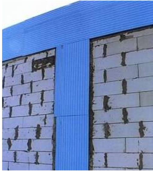
Şekil 4.5 (a,b) Isı köprüleri yalıtımında kullanılan Wallmate TB duvar yalıtımı
