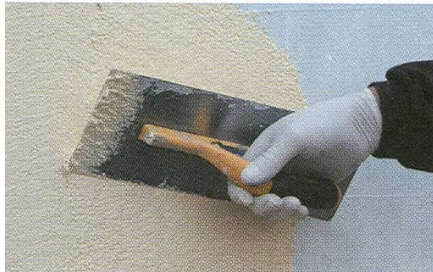
Şekil 3.12. Son kat dekoratif kaplama(silikonlu, hazır renkli sıva)
