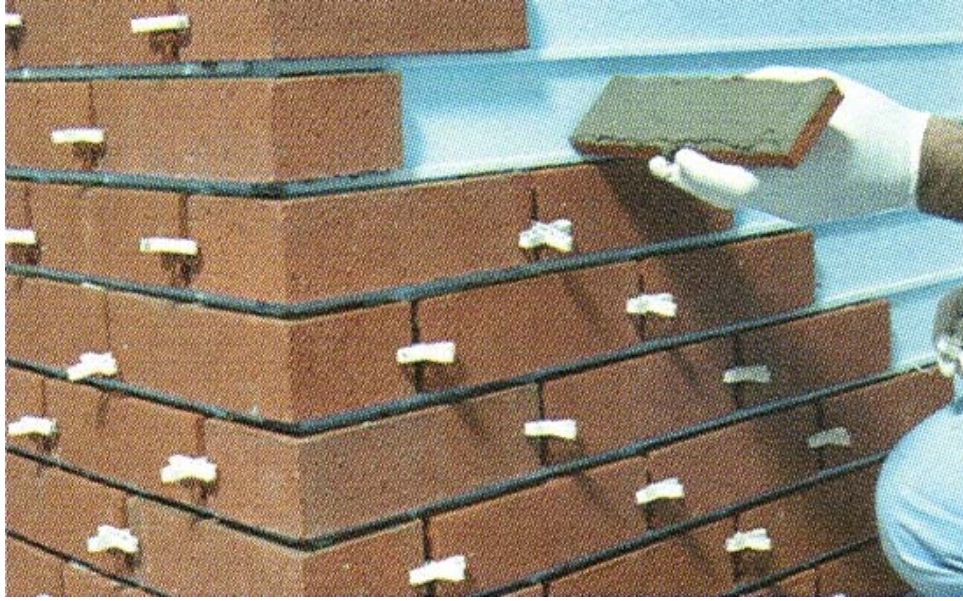
Şekil 3.20 Tuğla bitişli son kat dekoratif uygulama
