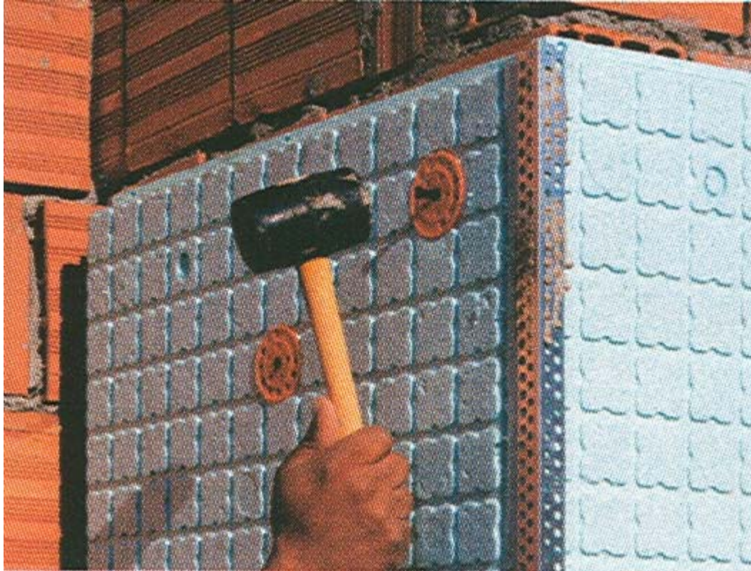
Şekil 3.16 Yalıtım levhasının dübellenmesi
