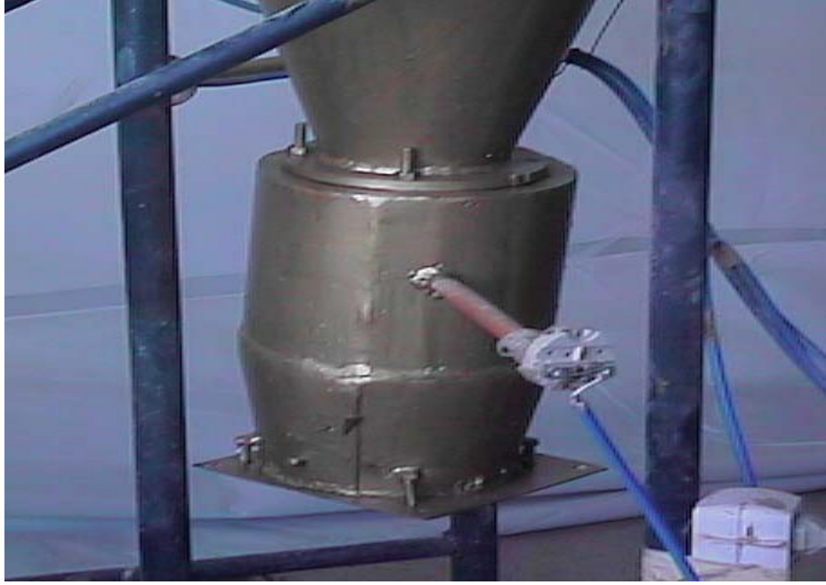
Şekil 3.1.16. Önısıtıcı Siklon Toz Toplama Haznesi
