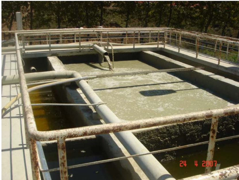
Şekil 2.7. Prese giden çamur havuzu
