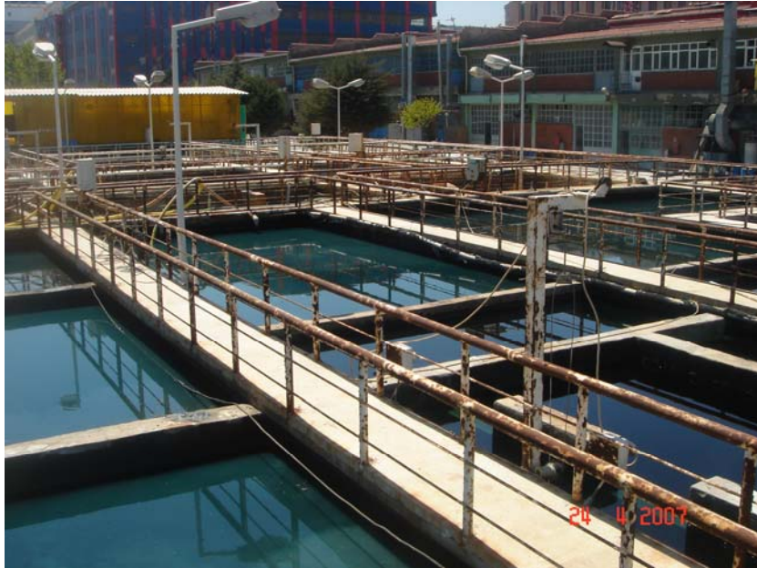
Şekil.2.3. İşletme paçal havuzları
