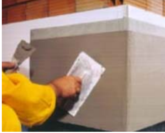
Şekil 4.17. İkinci Kat Sıva Uygulaması
