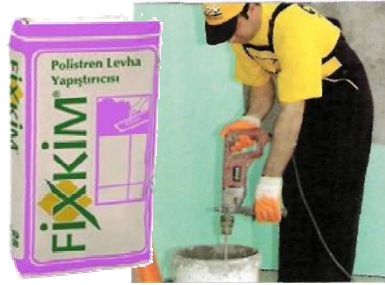
Şekil 4.1. Yapıştırıcı Malzeme ve Hazırlanması
