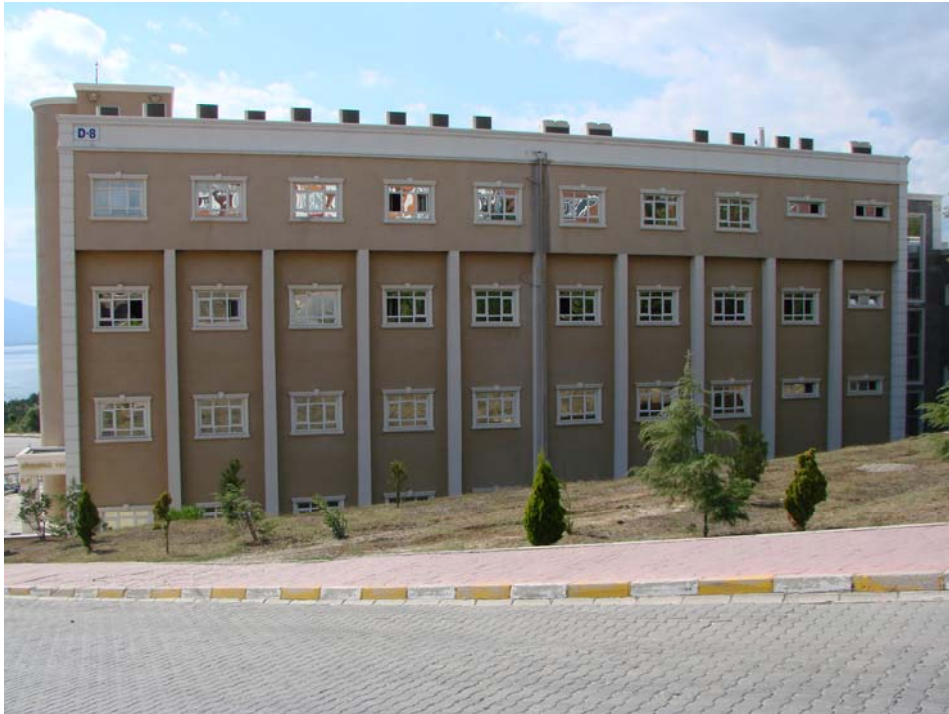
Şekil 4.25. SAÜ Mühendislik Fakültesi D-8 Binası
