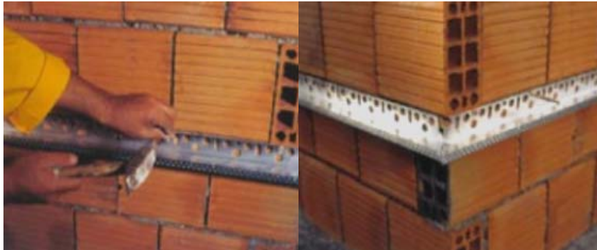
Şekil 4.9. Başlangıç Profilinin Duvara Uygulanması
