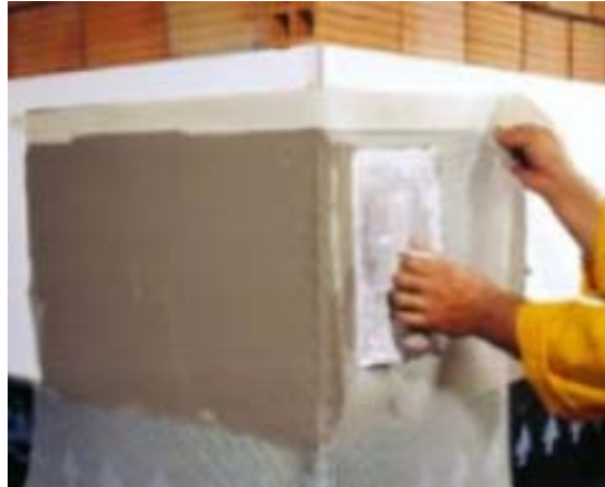
Şekil 4.16. Donatı Filesinin İlk Sıva Katmanı Üzerine Uygulanması
