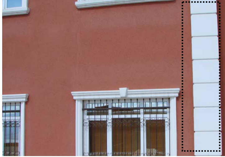
Şekil 4.27. Binaya dıştan uygulanmış dekoratif amaçlı yapı malzemesi
