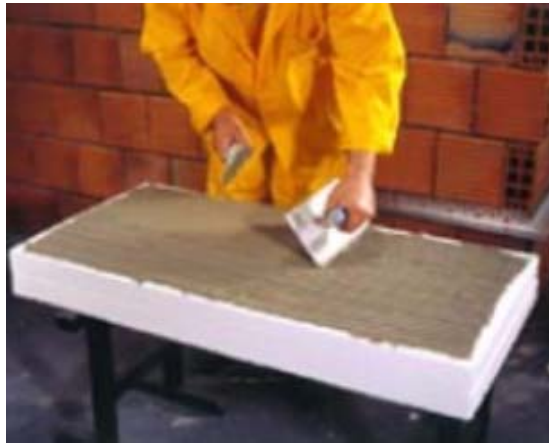
Şekil 4.11. Düzgün Yüzeyle Levha Yüzeyine Tırtıklı Mala İle Yapıştırıcı Uygulanması
