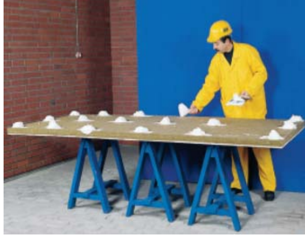
Şekil 4.10. Yapıştırıcı Harcın Yalıtım Levhasına Noktasal Olarak Uygulanması
