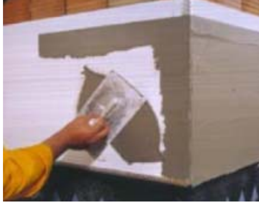
Şekil 4.15. Isı Yalıtım Levhasının Yüzeyine İlk Kat Sıva Uygulaması
