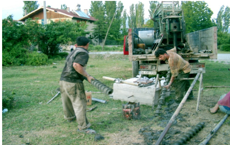
Şekil 3.2. Sondaj çalışması uç değişimi
