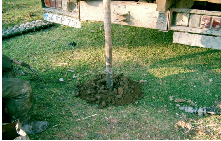
Şekil 3.1. Zemin laboratuvar deneyleri için sondaj çalışması
