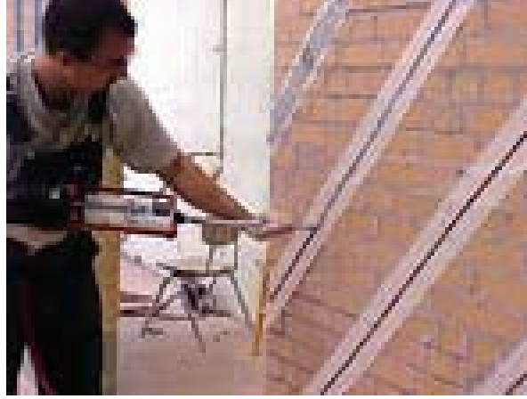
Şekil 3.9. FRP'lerle güçlendirilmiş duvar
