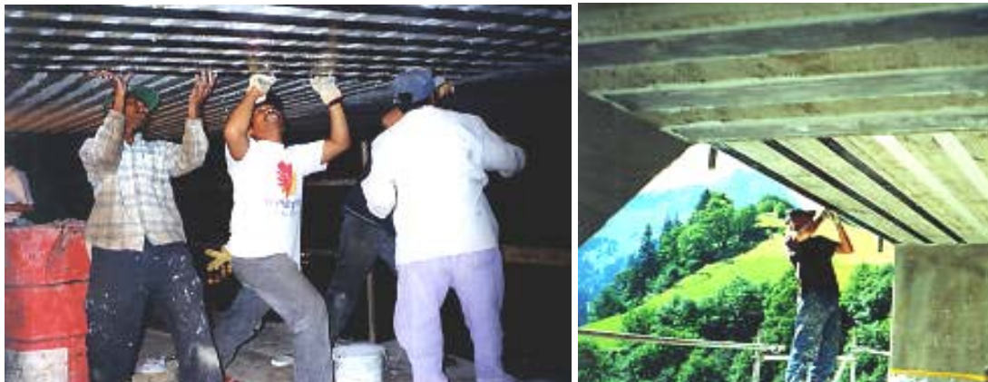
Şekil 3.8. FRP'lerle güçlendirilmiş betonarme döşeme ve köprü tablası
