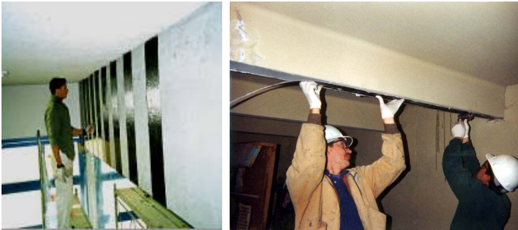
Şekil 3.7. FRP'lerle güçlendirilmiş betonarme kirişler
