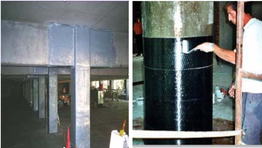
Şekil 3.6. FRP'lerle güçlendirilmiş betonarme kolonlar
