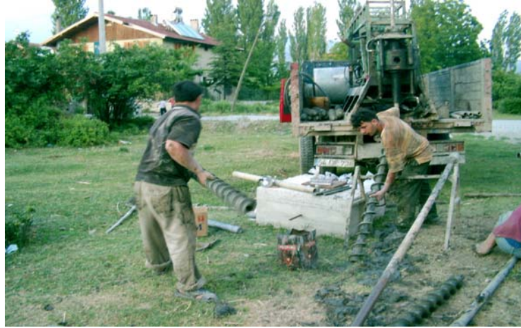
Şekil 4.7 Sondaj çalışması uç değişimi
