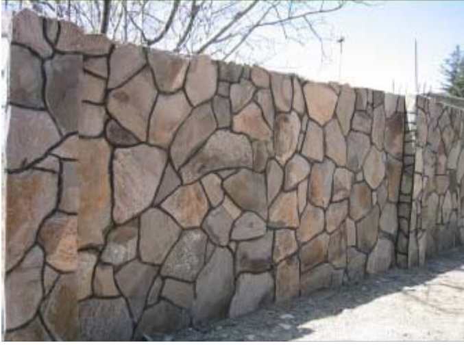
Şekil 4.4. Bazalt taşlarının duvar kaplaması olarak kullanımı [31]
