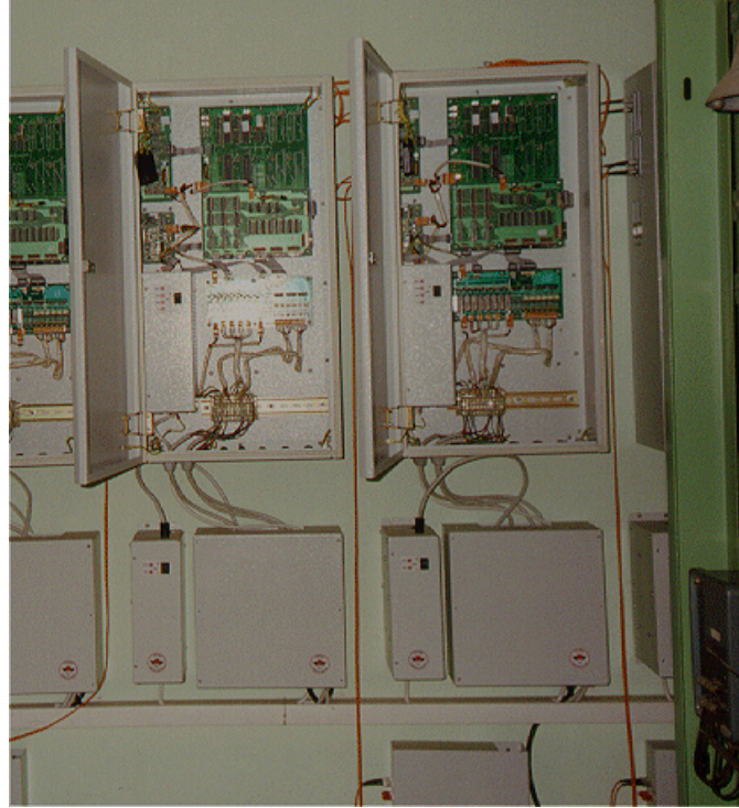
Şekil 13.3. İndirici Merkezde Montajdan Bir Görünüm
