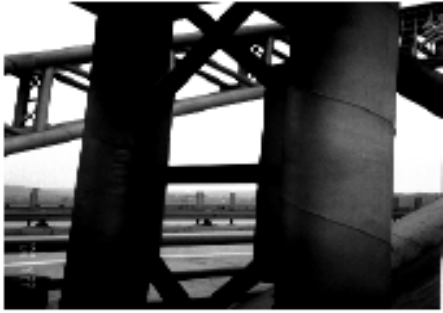
(g) Köprü borularının korozyona karşı kaplanması
