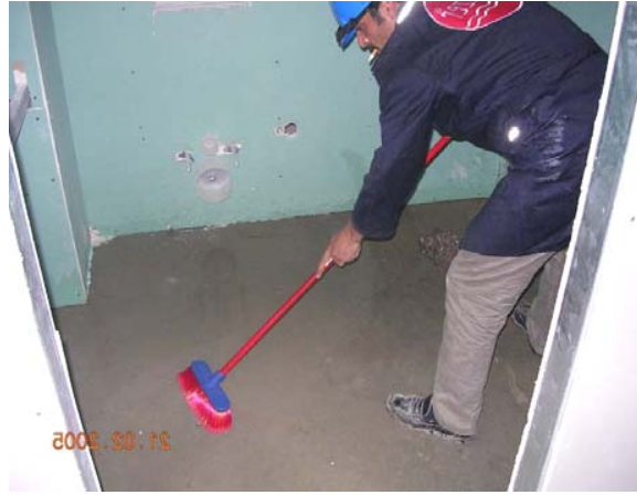
Şekil 2.2. Sure Tip Su Yalıtım Malzemesinin Uygulanması
