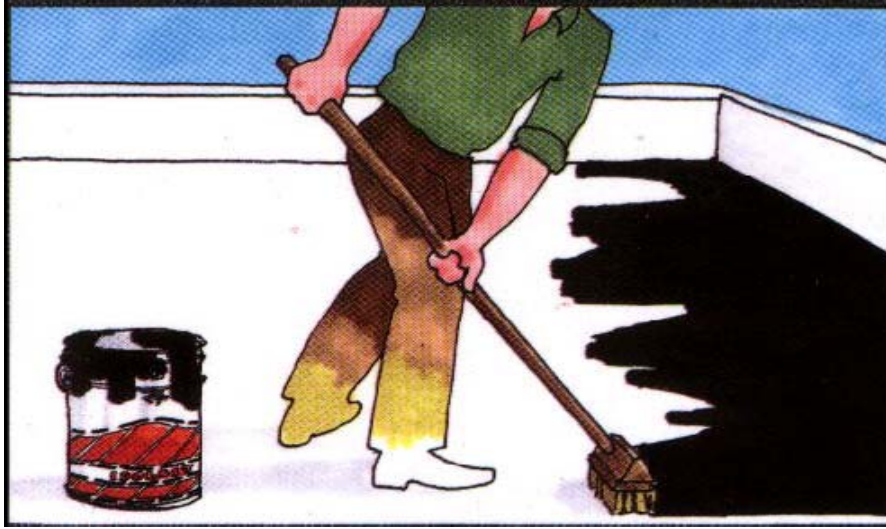
Şekil 2.6. Bitüm Esaslı Malzemeler İle Su Yalıtım Uygulanması
