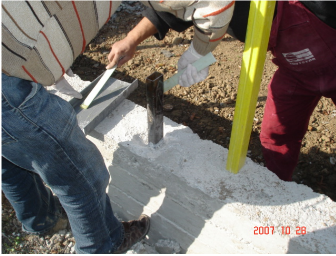
Şekil 5.11. Çelik profil yüzeylerine çift karışimli epoksi reçine sürülmesi
