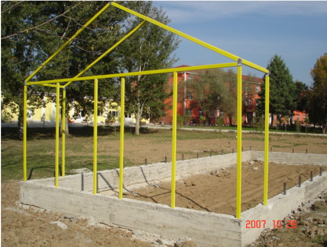
Şekil 5.14. CTP çerçeve sistemlerin taşınması ve kolonların temele montajı
