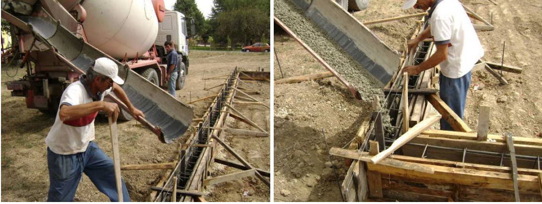
Şekil 5.5. Sera temel betonun dökümü
