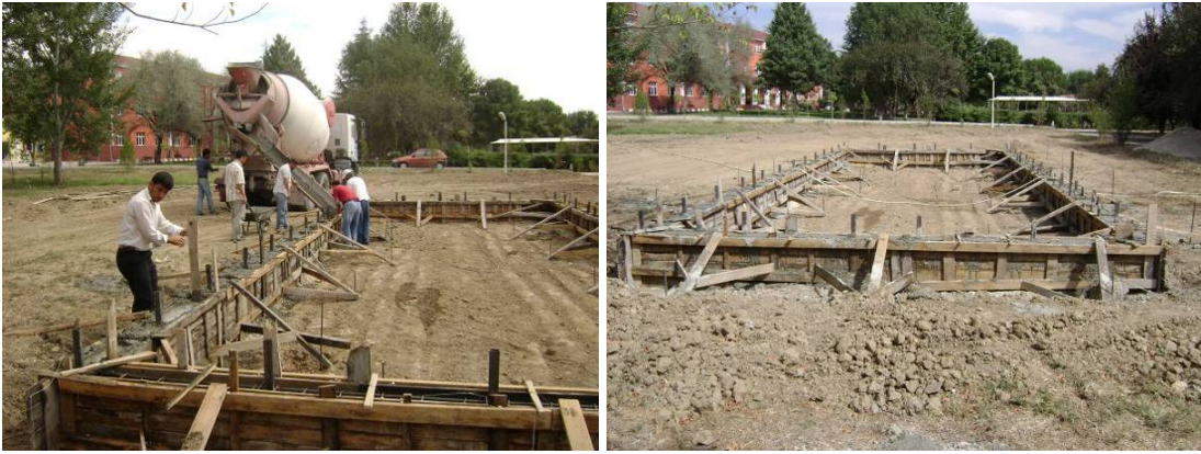
Şekil 5.6. Sera temel sıkıştırılması ve tesviye edilmesi
