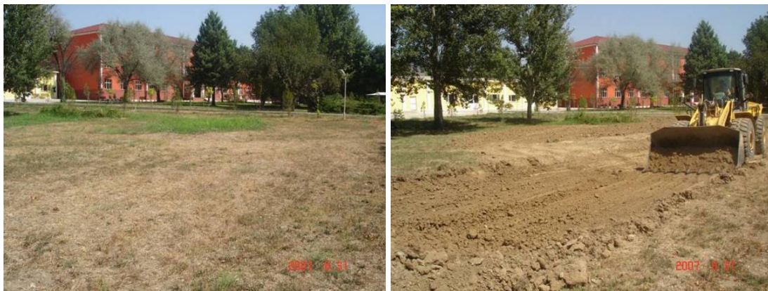
Şekil 5.1. SAÜ Pamukova Meslek Yüksek Okulu bahçesi sera temel kazısı
