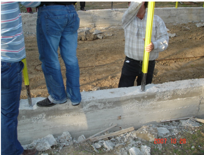
Şekil 5.12. Kolonların temele montajının yapılması
