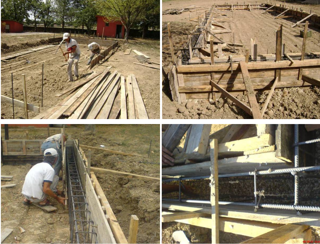
Şekil 5.2. Sera temel kalıbı hazırlanması ve demir donatının bağlanması
