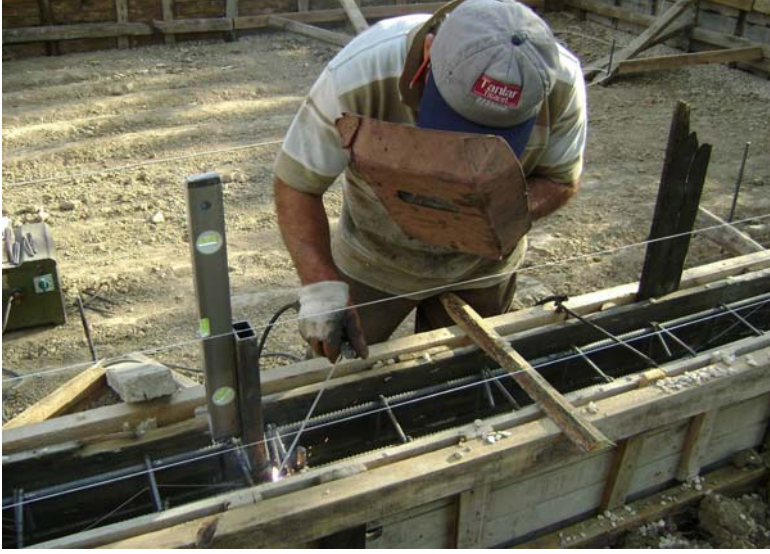
Şekil 5.3. Çelik kutu profillerin temele ankraji
