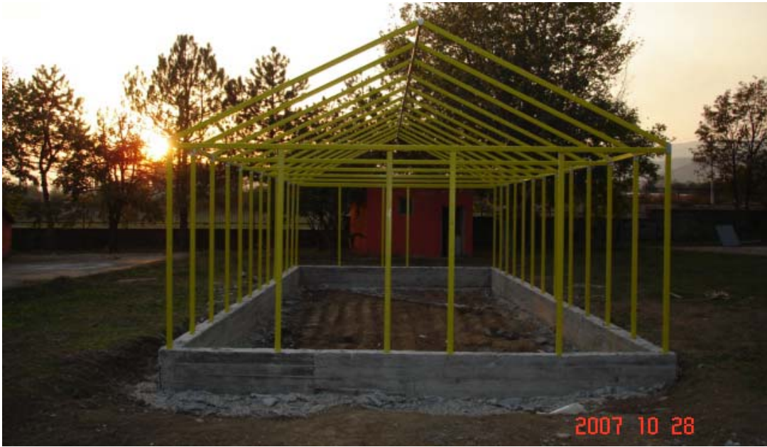
Şekil 5.18. Taşıyıcı kısmı tamamlanan CTP seranın ön görünüşü
