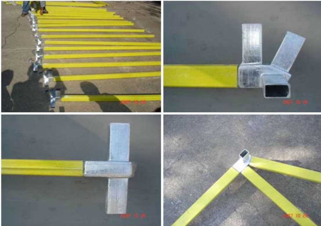
Şekil 5.9. CTP profillerin kolon-çatı birleştirme elemanlarına montajı
