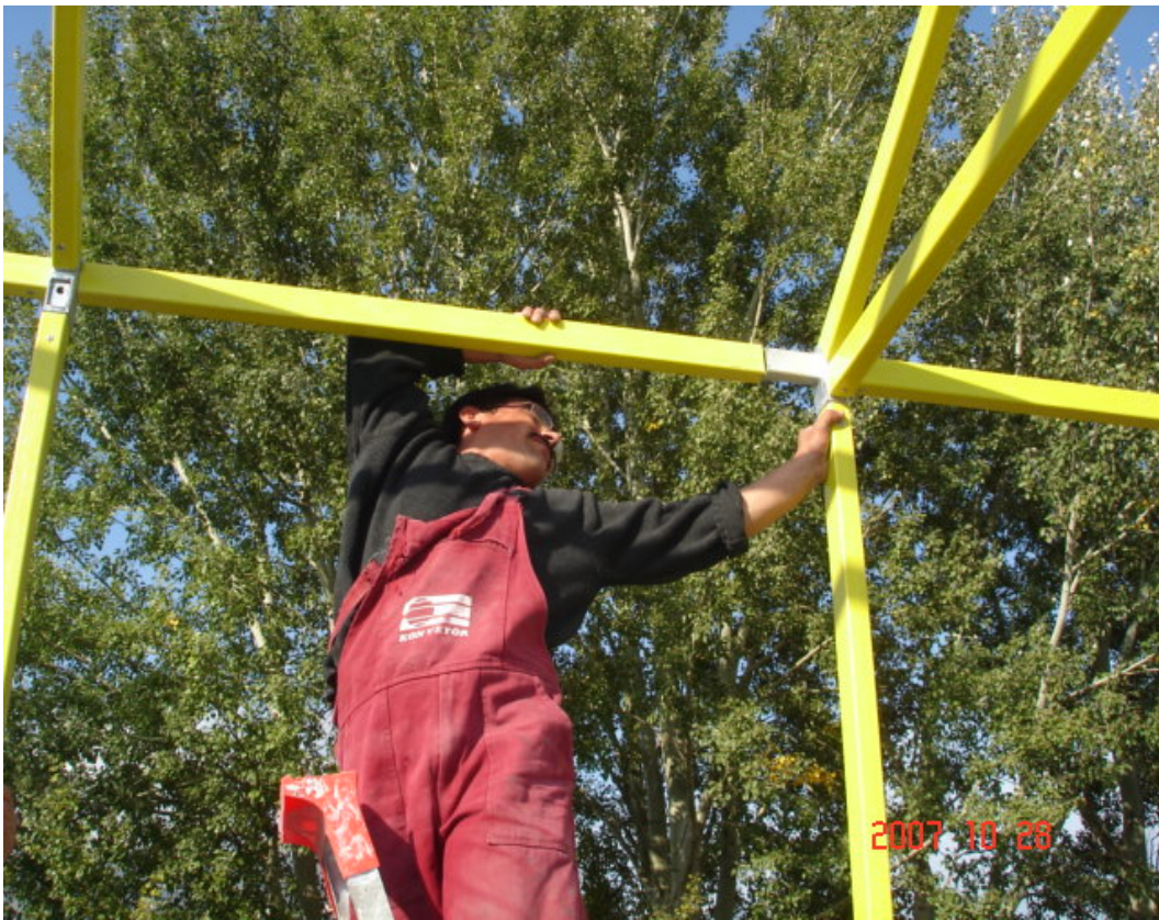
Şekil 5.16. Çerçeve aralarında kalan damlalık aşığı ve mahyaların montajı
