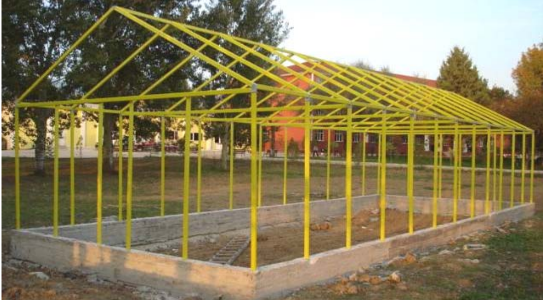
Şekil 5.17. Taşıyıcı kısmı tamamlanmış seranın yan görünüşü
