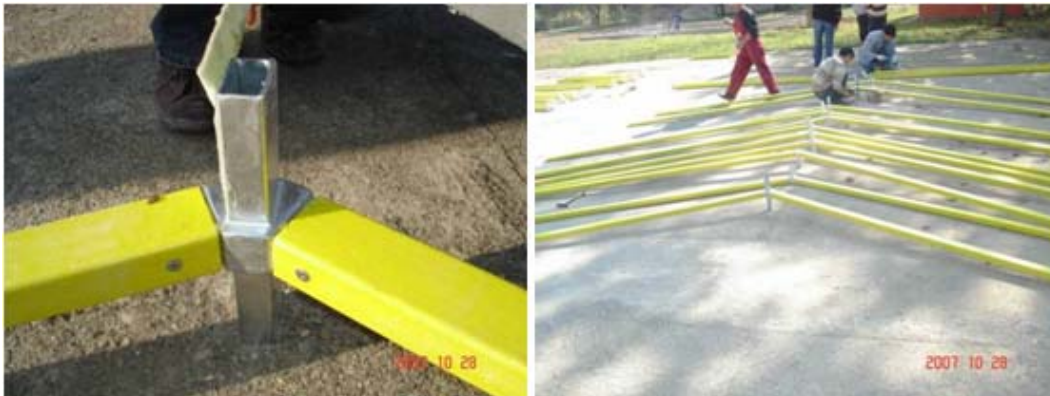
Şekil 5.10. CTP profillerin mahya birleştirme elemanlarına montajı
