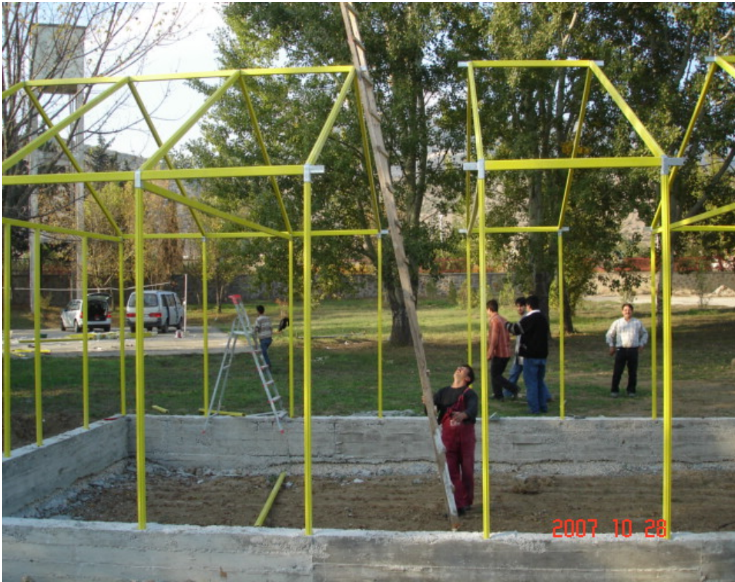
Şekil 5.15. CTP sistemlerinin taşınması ve kolonların temele montajı
