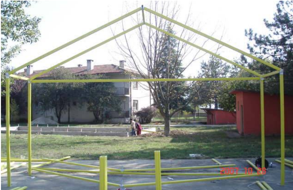
Şekil 5.13. CTP seranın çerçeve sistemlerinin oluşturulması
