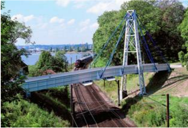
Şekil 3.18. CTP yaya ve hafif araç köprüsü
