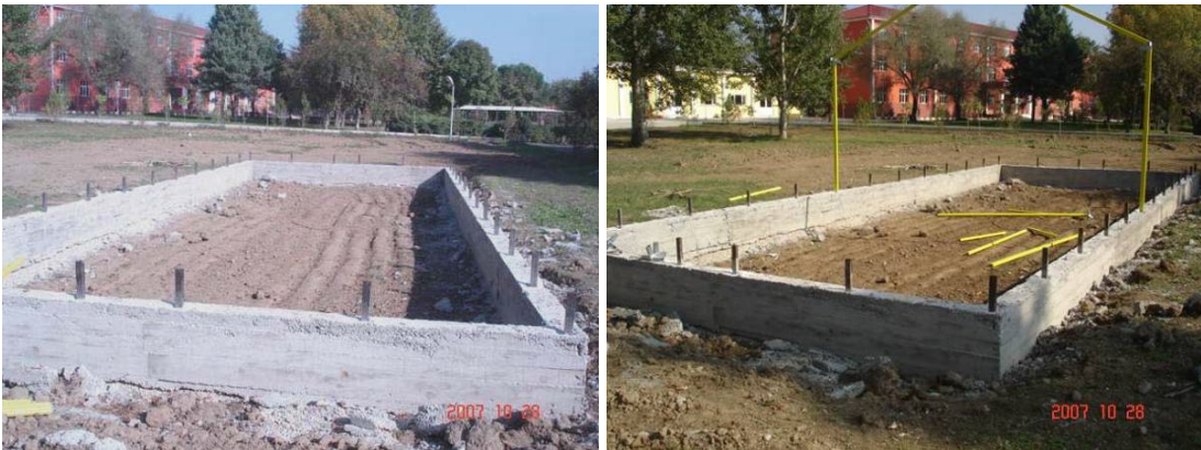
Şekil 5.7. Kalıbı sökülmüş temel betonu
