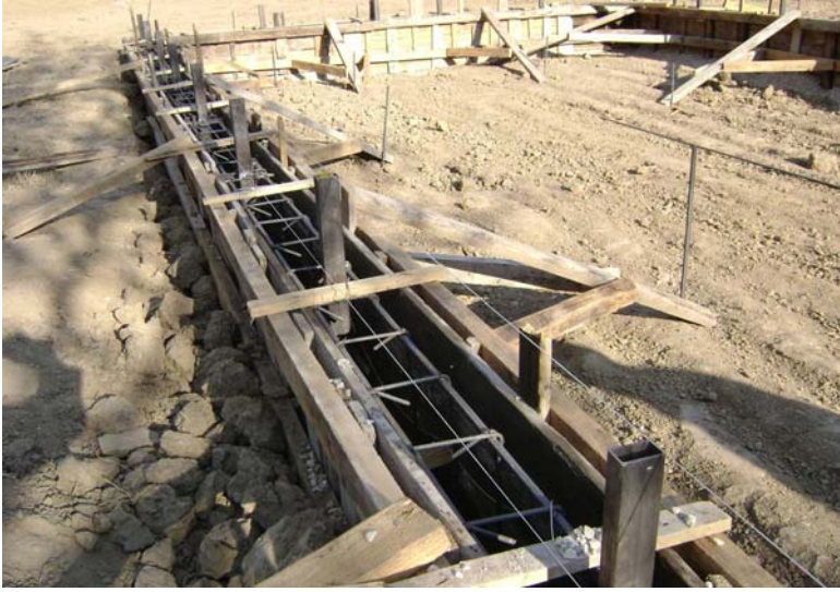
Şekil 5.4. Çelik kutu profillerin donatıya ankraji
