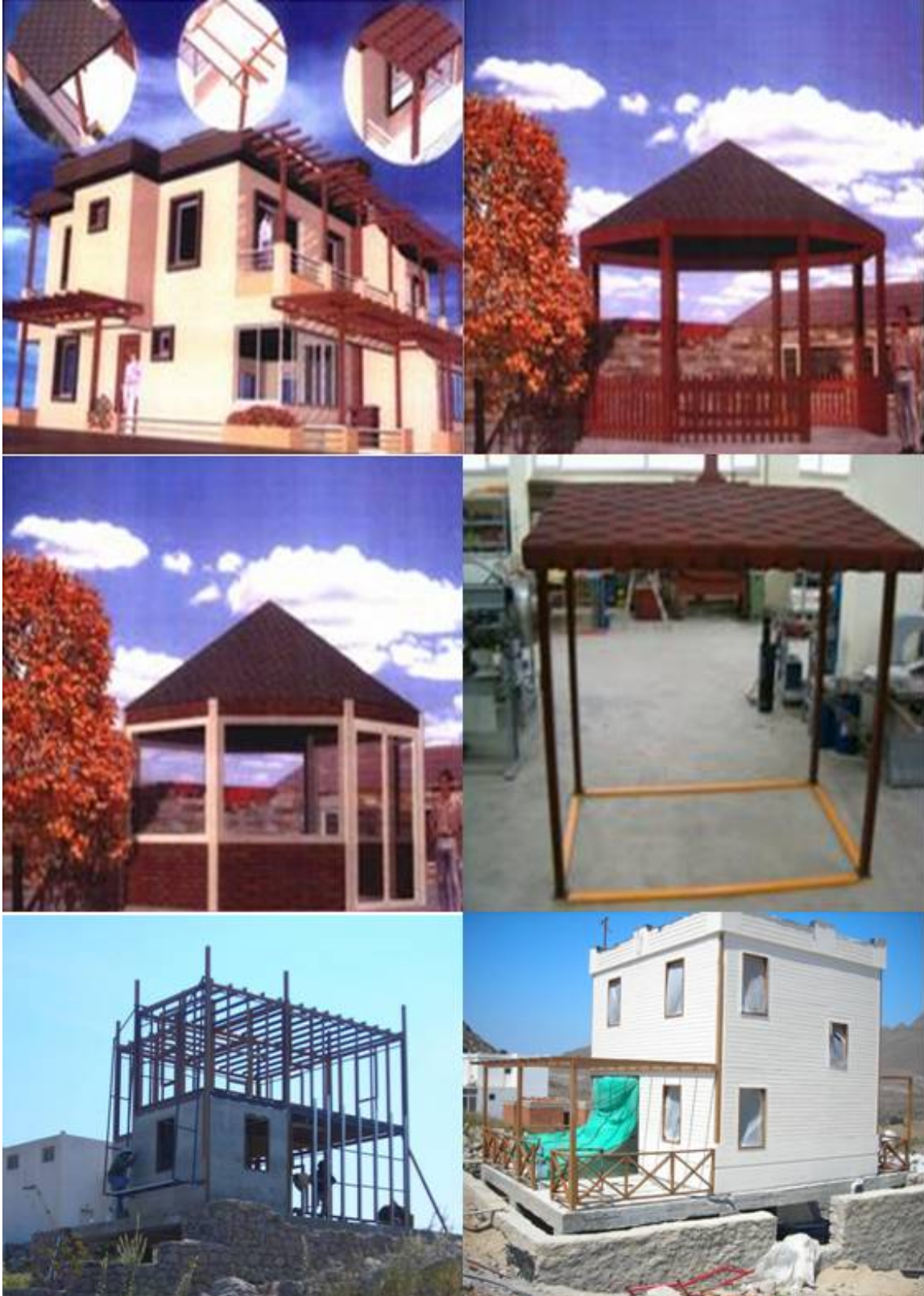
Şekil 3.22. Pultruzyonla üretilmiş CTP'lerin Türkiye'de uygulama örnekleri
