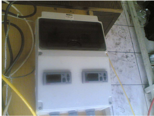
Şekil 4.7. Dijital termostatlı sigorta panosu
