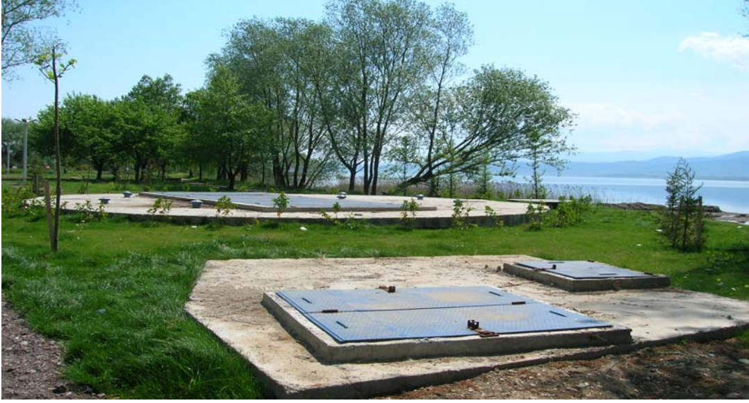
Şekil 4.2 Eşme terfi istasyonundan görünüm.
