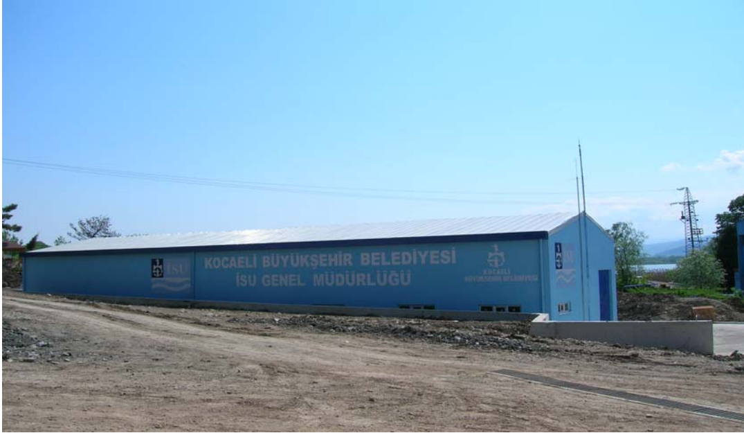
Şekil 4.3. İSU Seka terfi istasyonundan görünüm.
