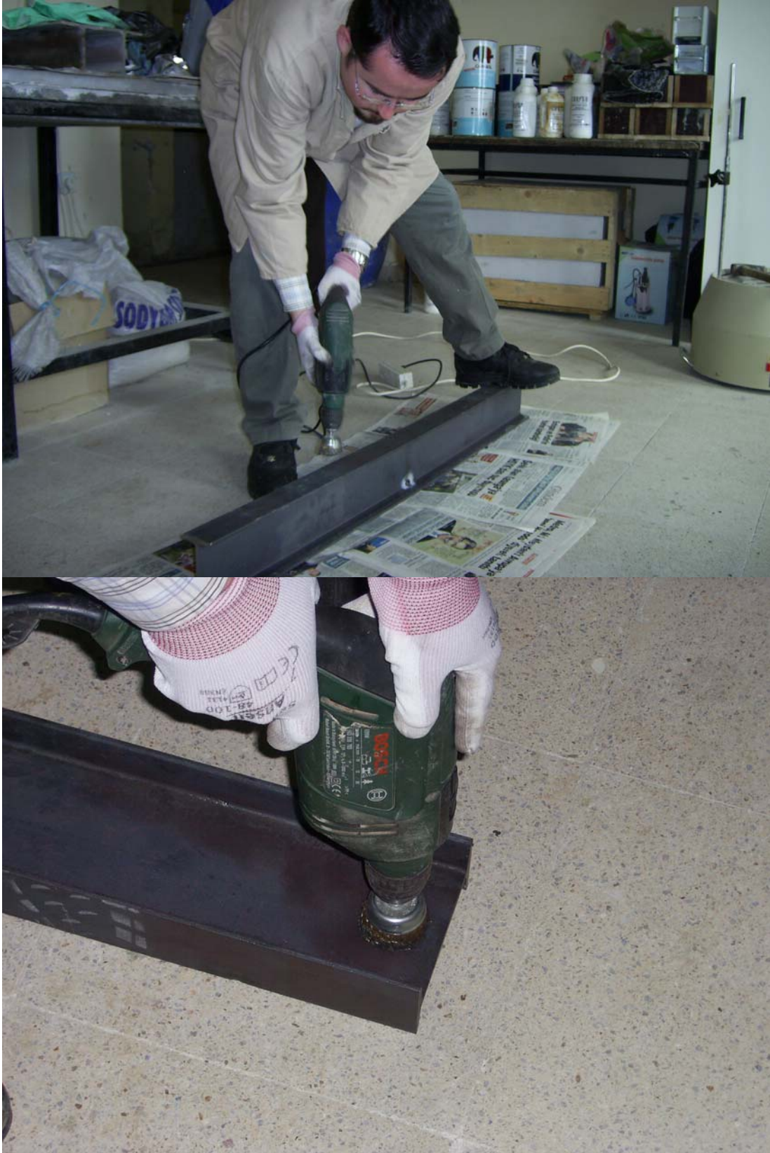
Şekil 3.6. Yüzeyin Tel Fırça ile Temizlenmesi
