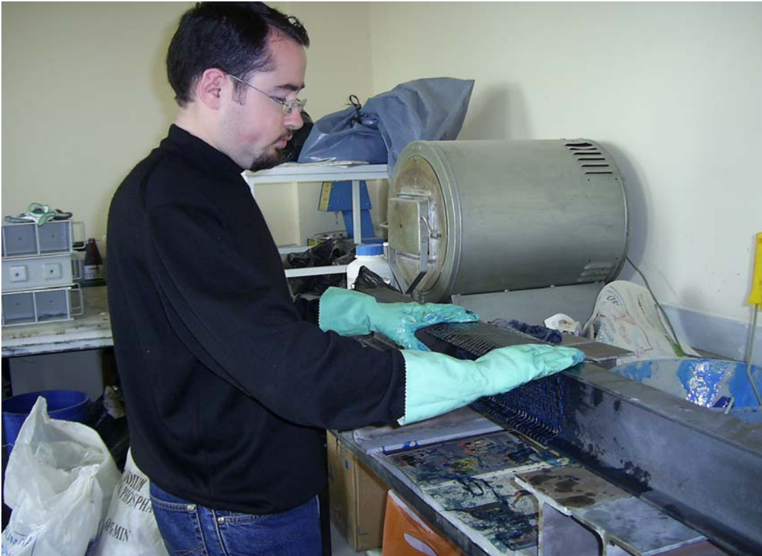
Şekil 3.18. İkinci Kat CFRP'nin Yapıştırılması
