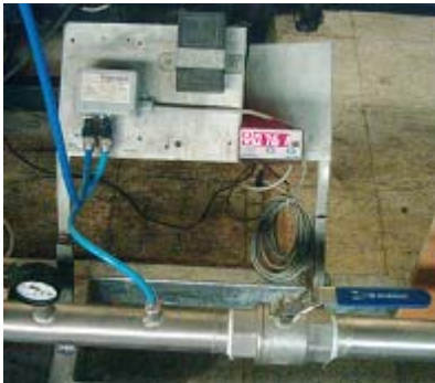
Şekil 1.8 Fark basınç ölçer
