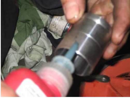
Şekil 1.25 Boruya yapıştırıcı sürülüşü
