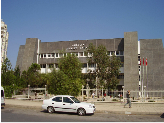
Şekil 4.1. Antalya adliye binası görünüşü
