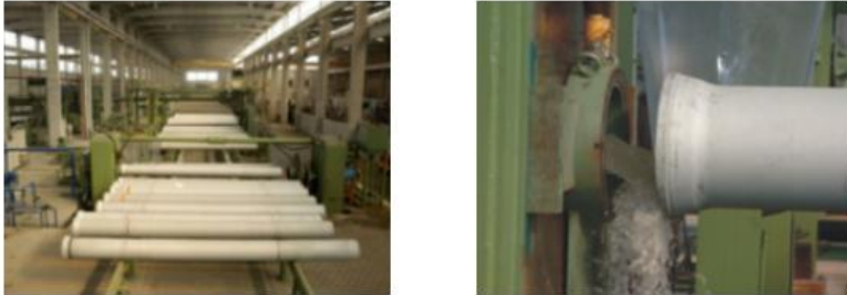
Şekil 4.23. Hidrolik test uygulaması
