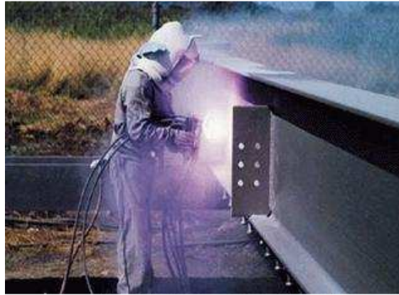
Şekil 3.14. Köprü konstrüksiyonunun korozyona karşı kaplanması[37]
