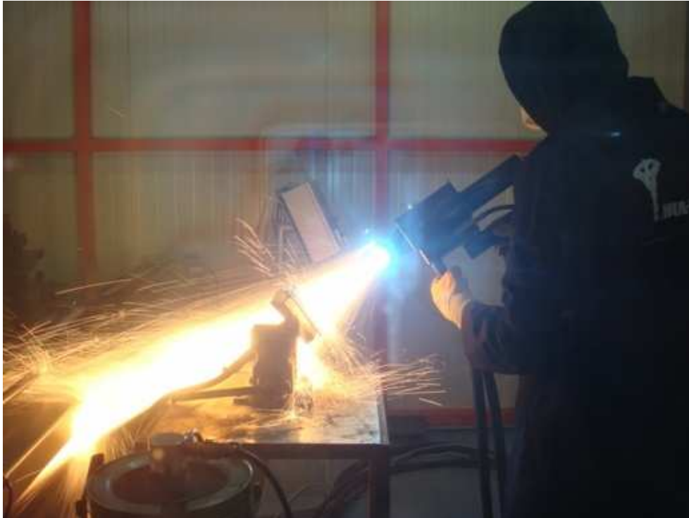
Şekil 5.6. Kaplamanın manuel uygulanması
