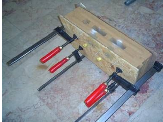
Şekil 3.11. Döküme hazır kalıp görünüşü
