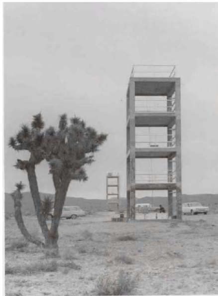
Şekil 1.1. Nevada deney sahasında üzerinde statik itme deneyi yapılan betonarme yapılar [1].
