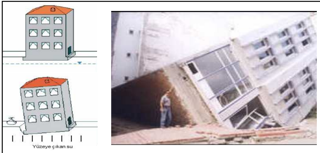
Şekil 2.7. Taşıma gücü kaybının şematik gösterimi ve bir örnek (Ulusay, 2000)
