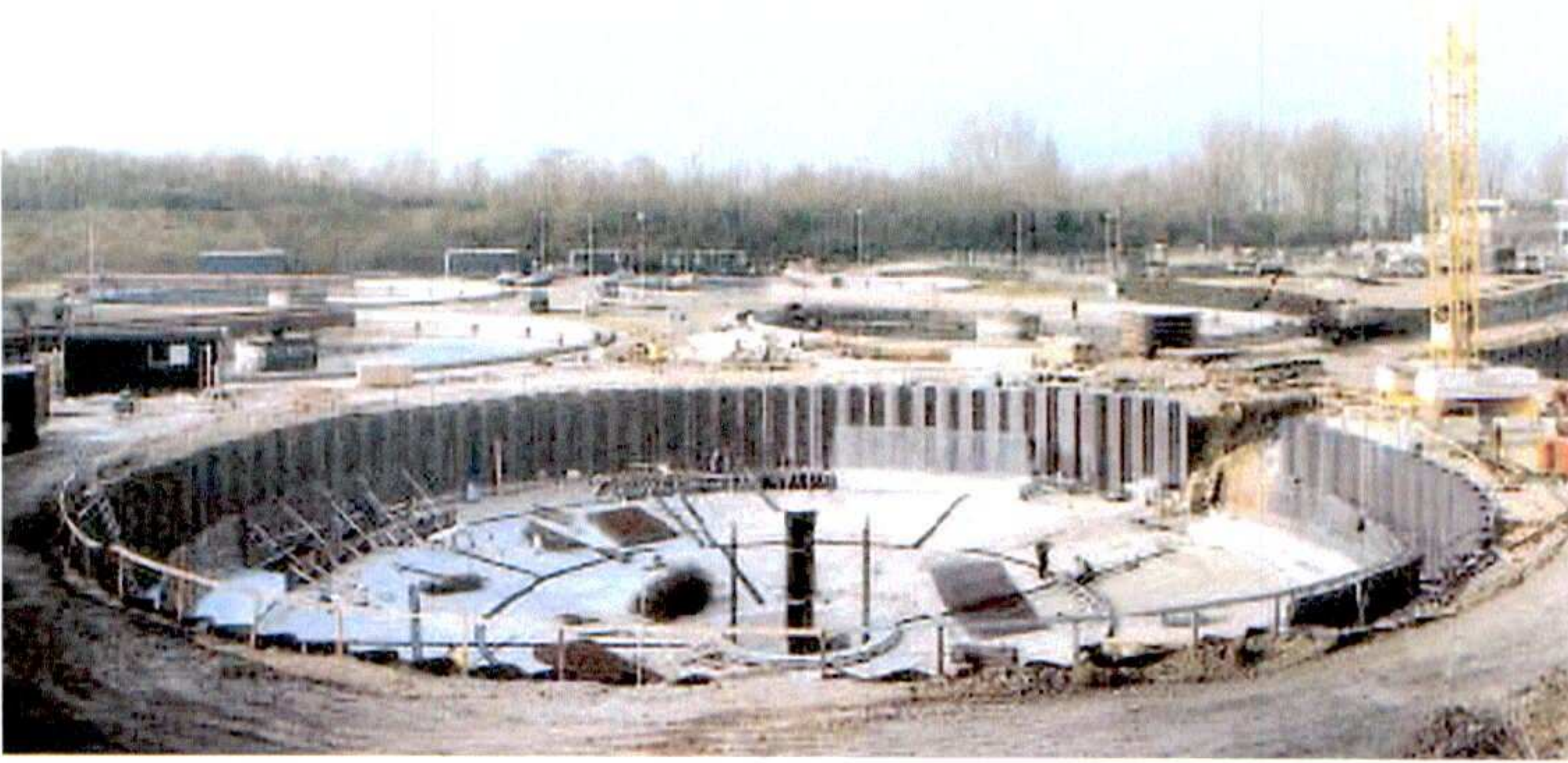
Şekik 2.16. Çelik palplanş duvarı (Arcelor)
