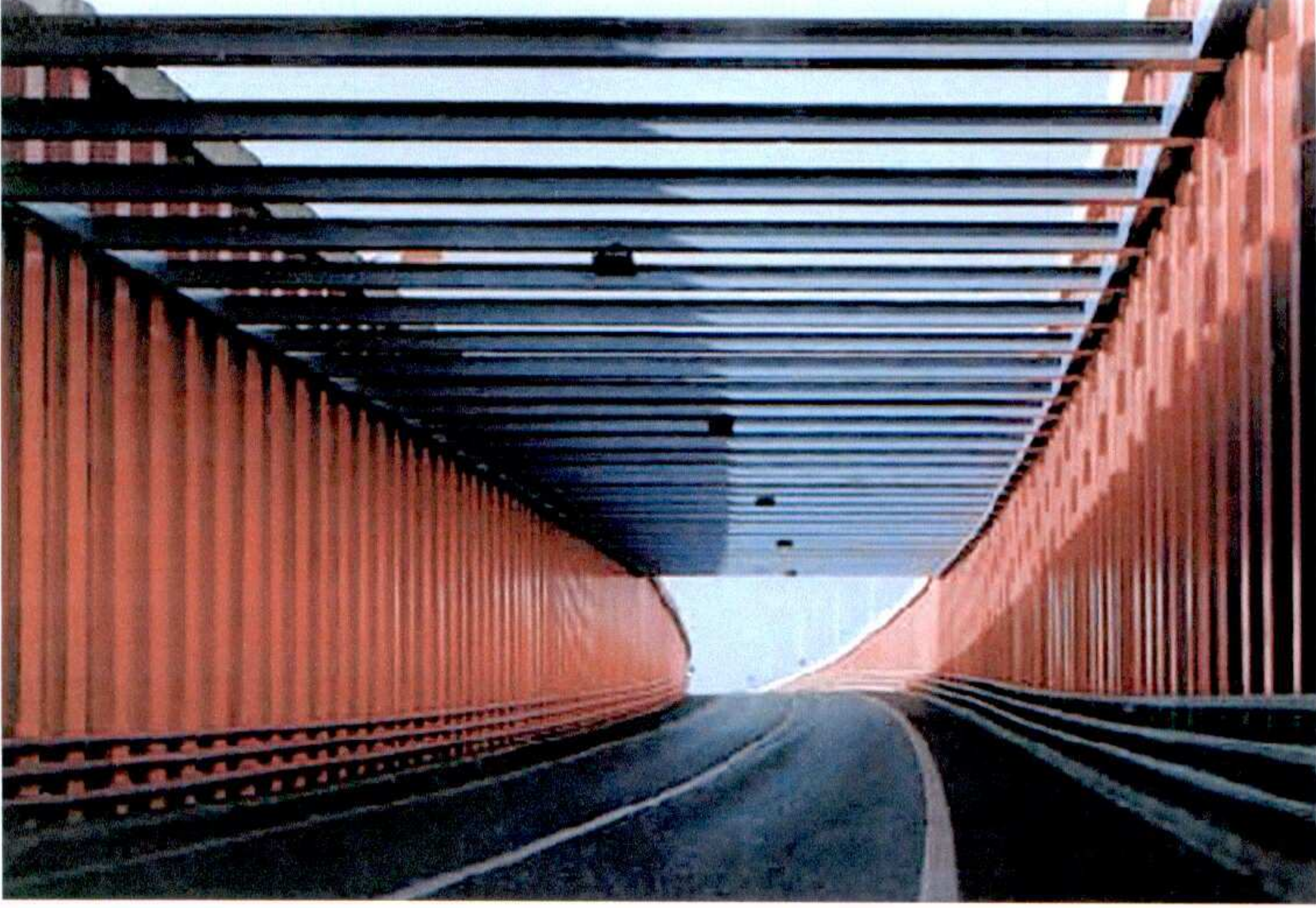
Şekil 3.2. Çelik palplanş ile yapılan bir alt geçit uygulaması (Arcelor)
