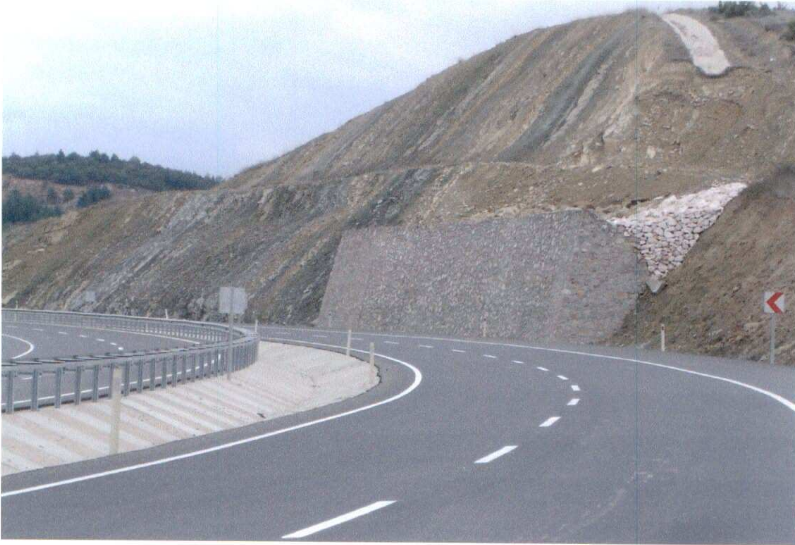
Şekil 2.1. Ağırlık tipi dayanma duvarı fotoğrafı (Mekece – Bilecik yolu, Osmaneli Kısmı)
