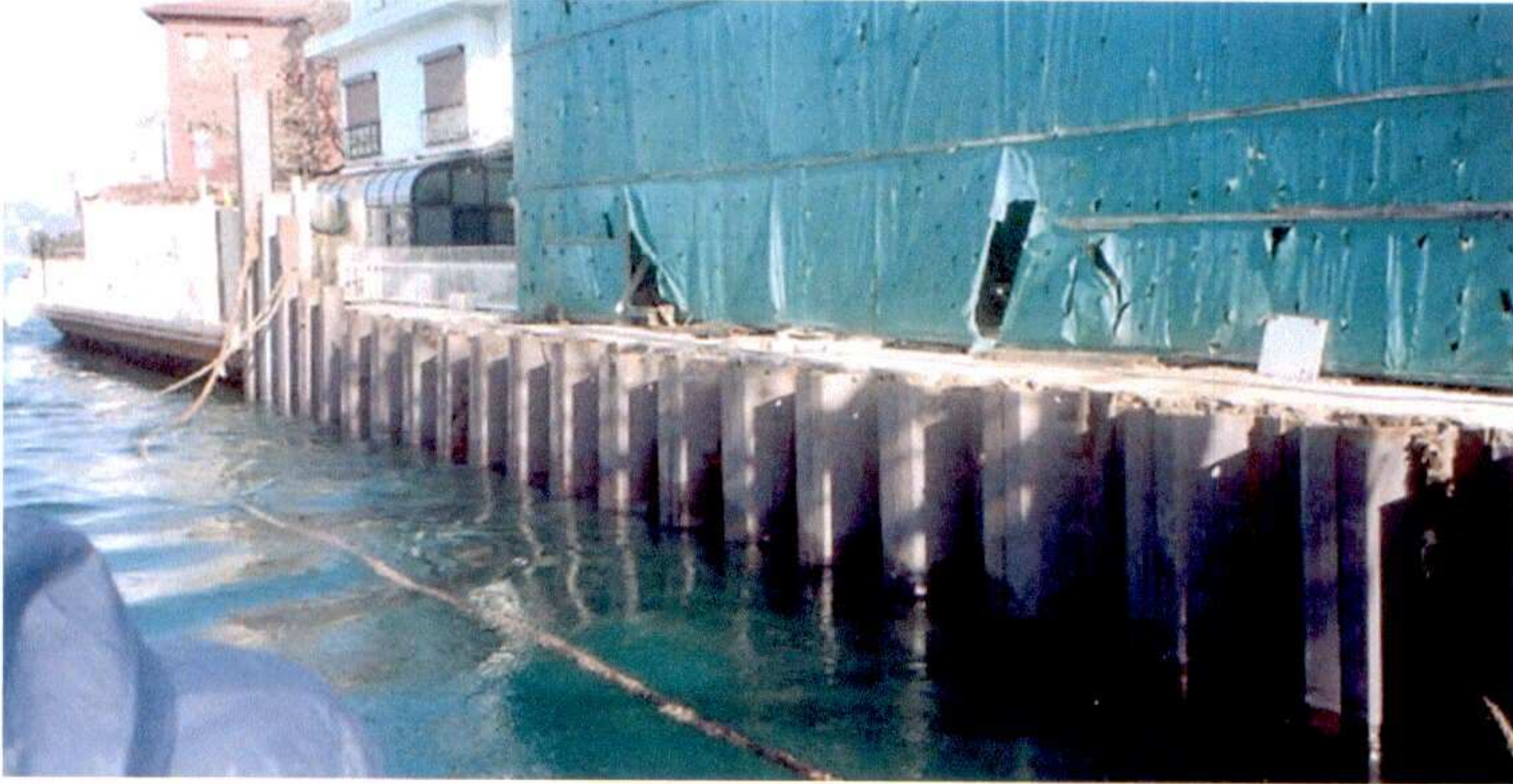
Şekil 2.15. Çelik palplanş duvarı (Arcelor – Ülker yalısı iksa projesi / İstanbul)
