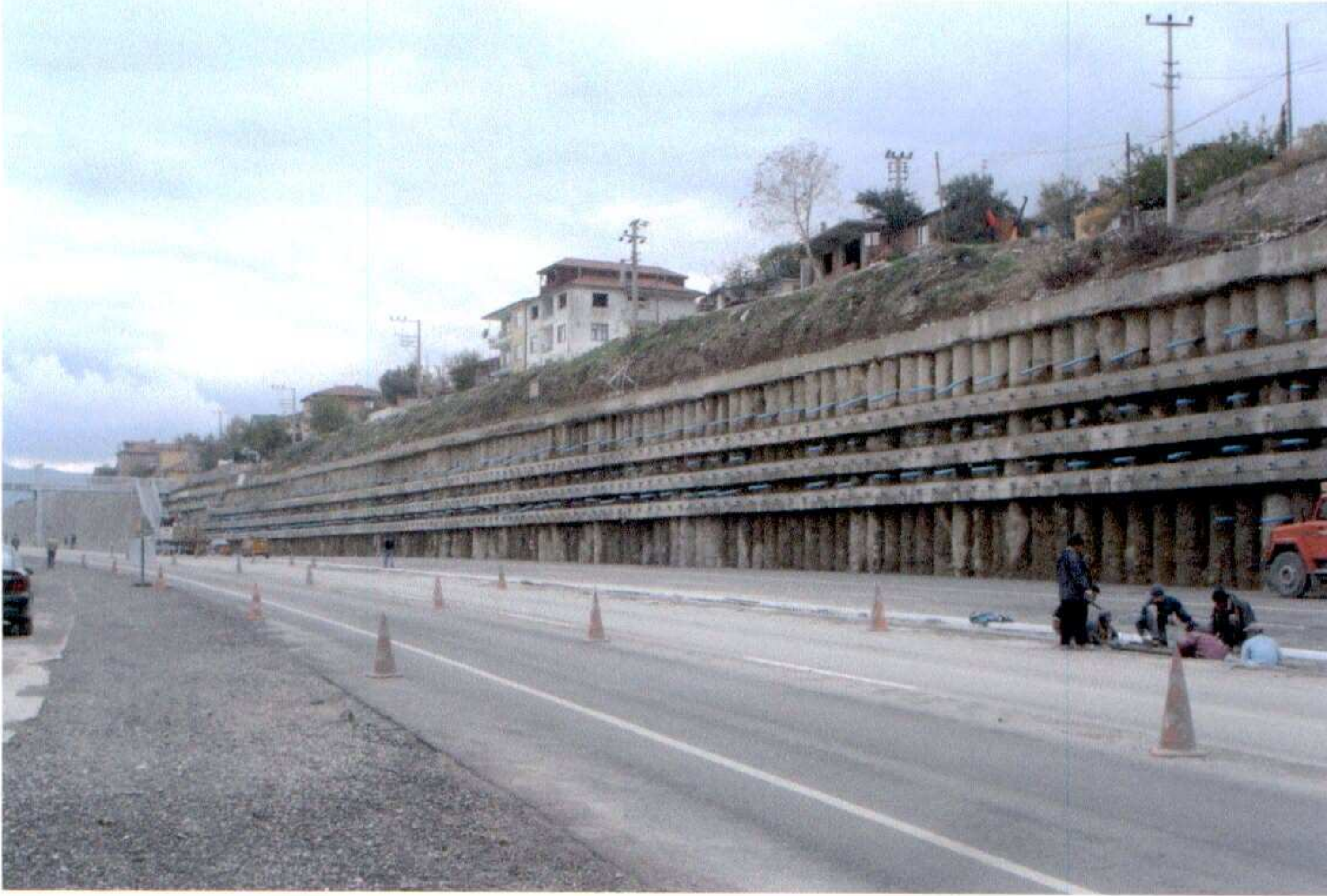
Şekil 2.11. Kazıklı perde görüntüsü (Adapazarı – Pamukova yolu Geyve kısmı)
