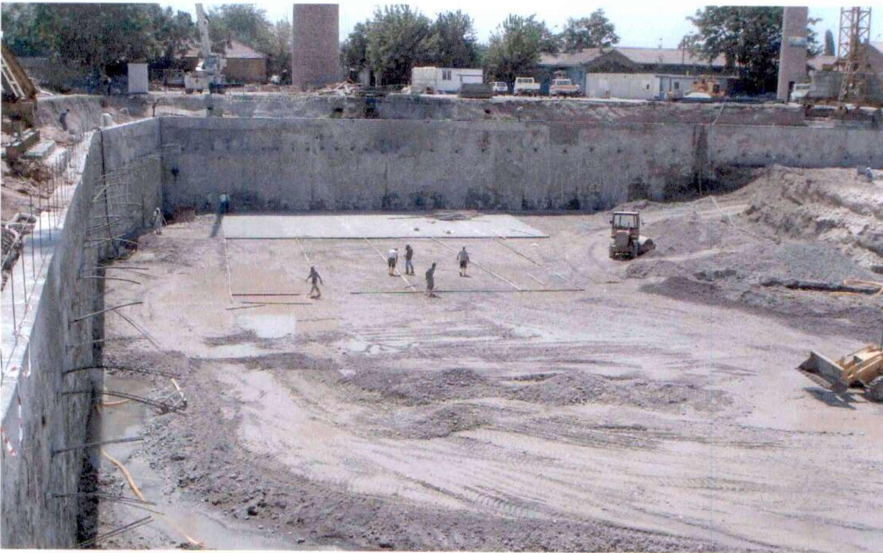
Şekil 2.13. Diyafram duvar (Zetaş A.Ş.)
