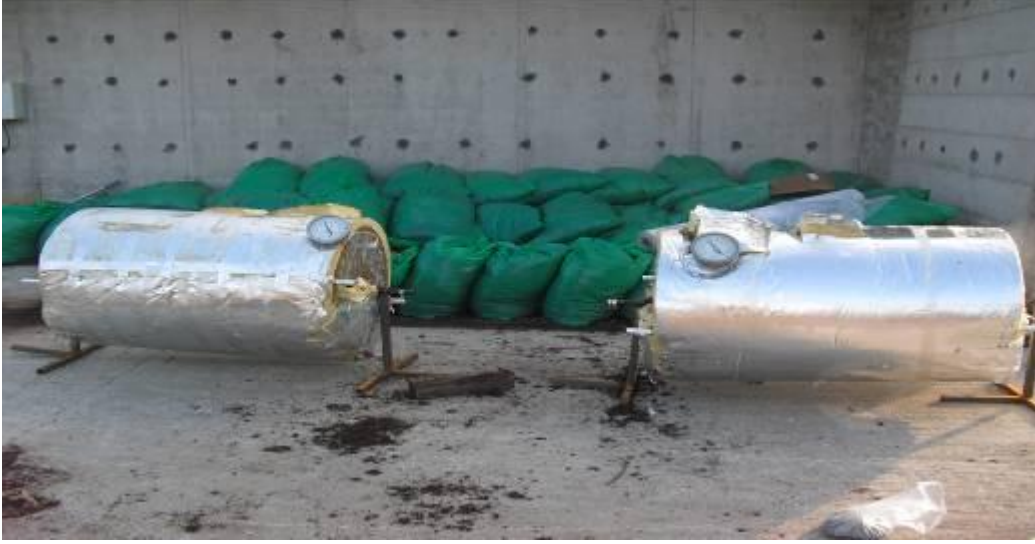
Şekil 6.4. Kompost tanklarının dışarıdan görünüşü
