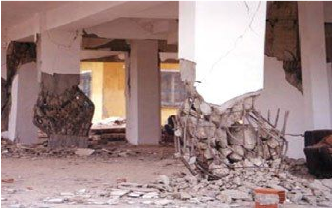
Şekil 3.4. Yetersiz etriye ve burulma kuvveti tesirinde kalmış kolonlar
