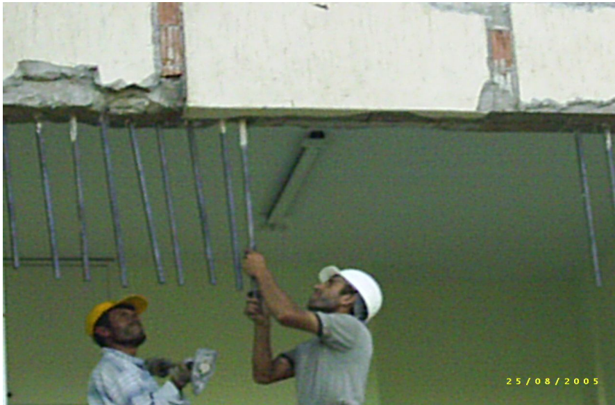
Şekil 9.6 Perde filizi çakılması
