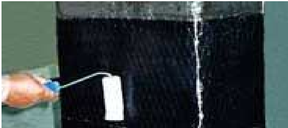
Şekil 8.1 Kolona FRP kumaşı uygulaması
