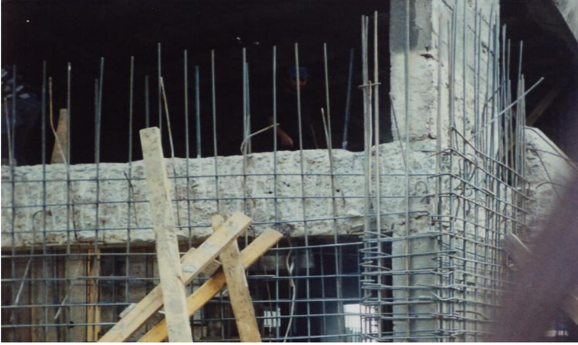
Şekil 10.4 Kolon mantolama uygulaması
