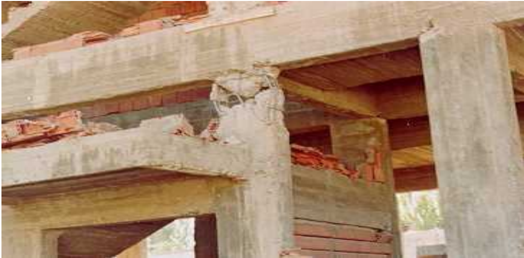
Şekil 3.21 Kısa kolon davranışı
