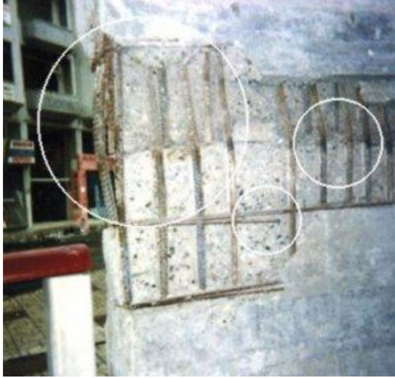
Şekil 3.11 Kanca paylarının yetersiz ve birleşim yerlerinde eklerin yeterli boyda olmadığı bir perde örneği
