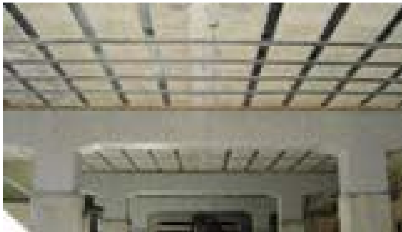
Şekil 8.4 Döşemede FRP uygulaması
