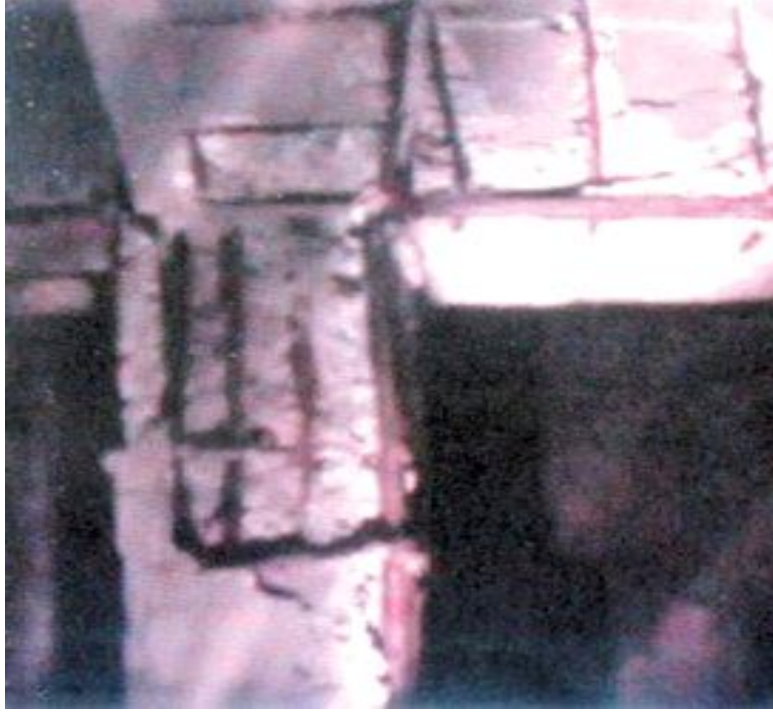
Şekil 3.8 Yetersiz etriye aralığı ve kanca boyu kullanılan bir kolon örneği
