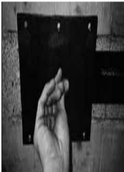
Şekil 8.9 Plakaların bitim noktalarından çelik plaka ve cıvata ile ankrajlanması
