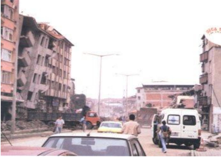
Şekil 3.16 Çekişleme etkisinde yıkılmış bir bina (2)
