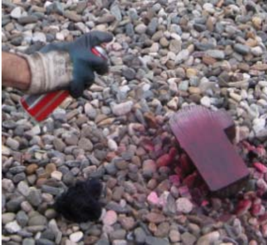
Şekil 3.15.a Penetrant boya uygulaması
