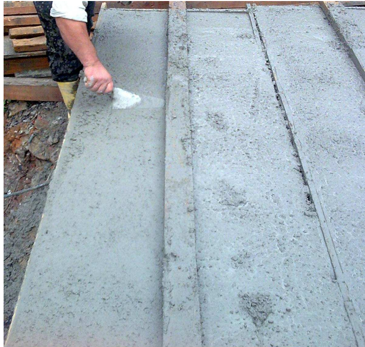
Şekil 3.4 Betonun üst yüzeyinin düzleştirilmesi işlemi
