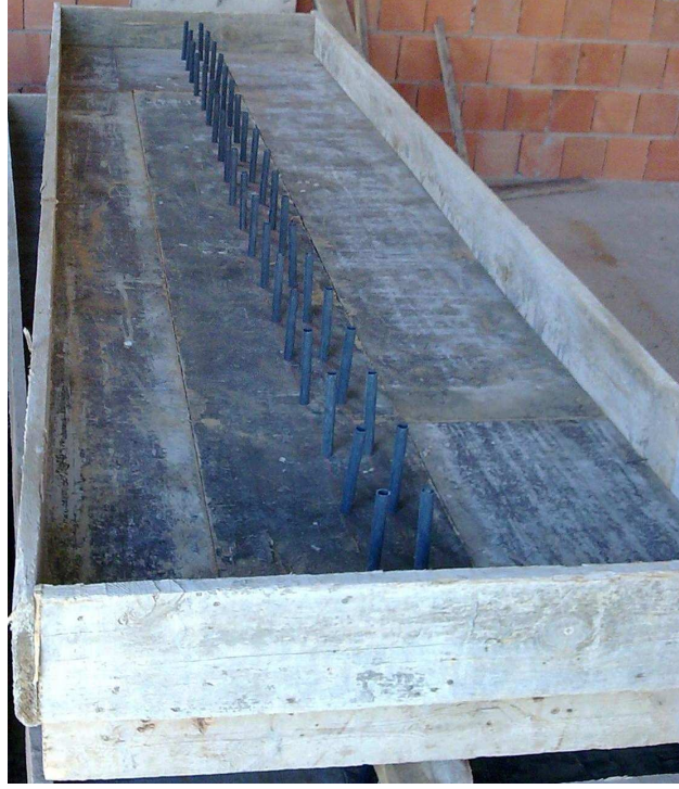
Şekil 3.1 Betonarme plağın borular ile görünüşü
