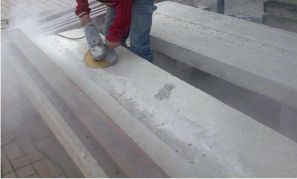
řekil 3.5.Spiral ile betonun dzeltilmesi
