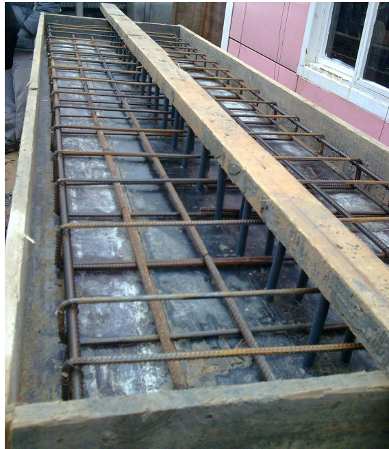
Şekil 3.2. Beton dökülmeden önceki betonarme plağın durumu
