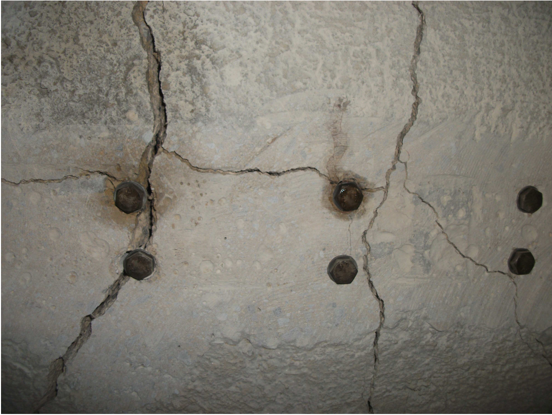
Şekil 5.2. Beton çatlaklarının bulonlar etrafında oluşumunun gösterilmesi
