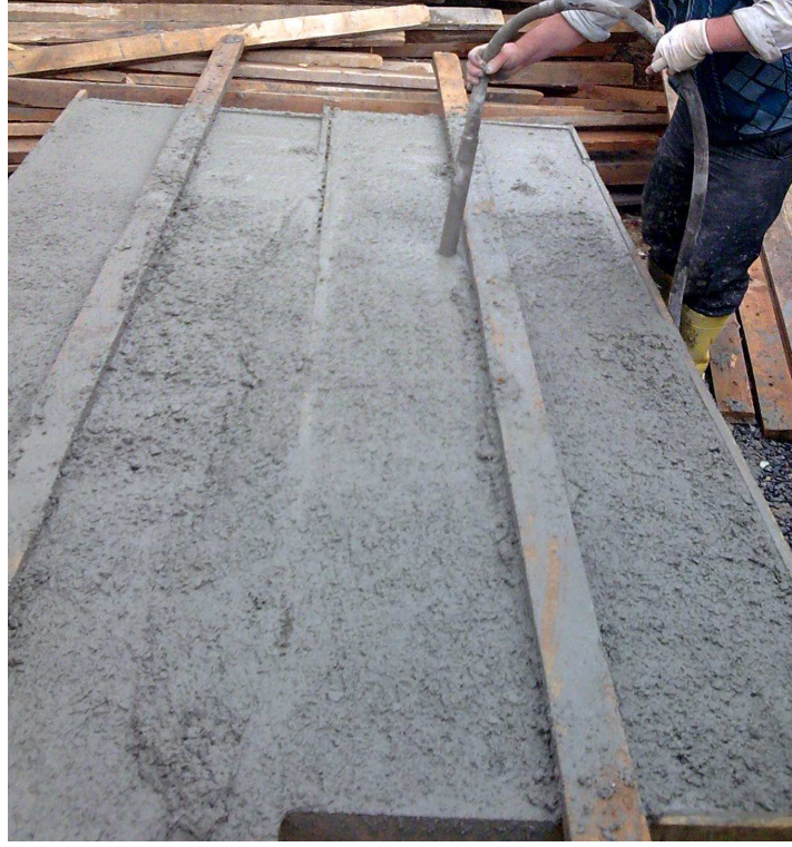
Şekil 3.3. Beton dökümü esnasında vibratör kullanımı
