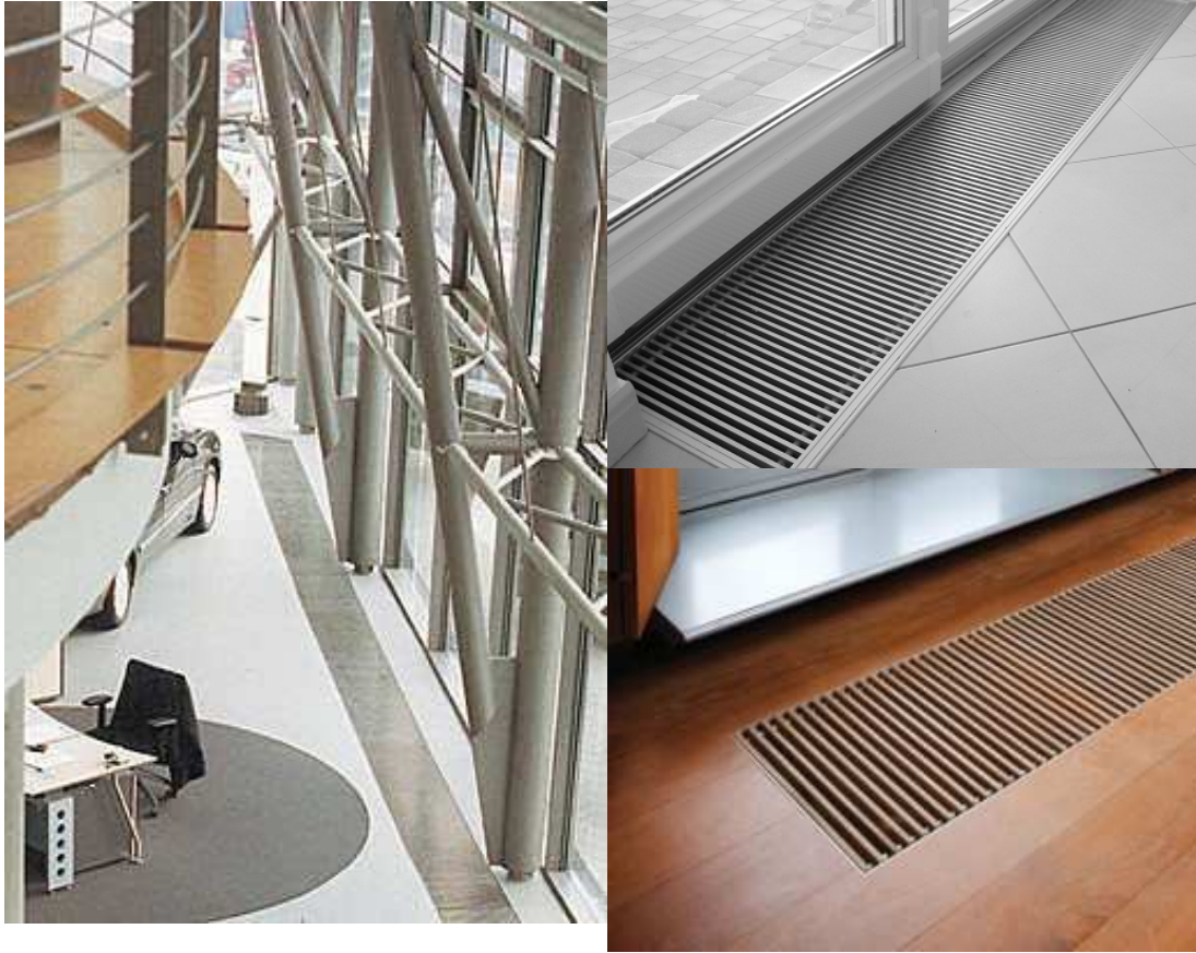
Şekil 2.6. Gömülü tip konvektörlerin uygulamaya ait örnekleri
