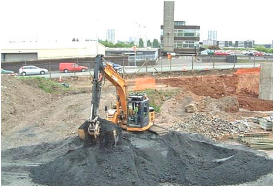
Şekil 2.2. Termik santral atığı uçucu kül yığını [15]
