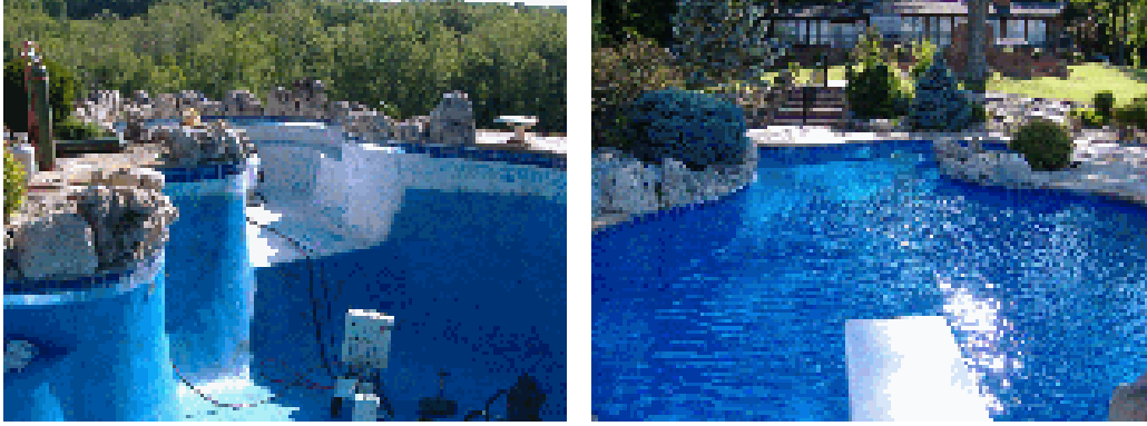
Şekil 3.5. Havuzun alev sprej yöntemiyle polimer kaplanmasının görünümü [22]
