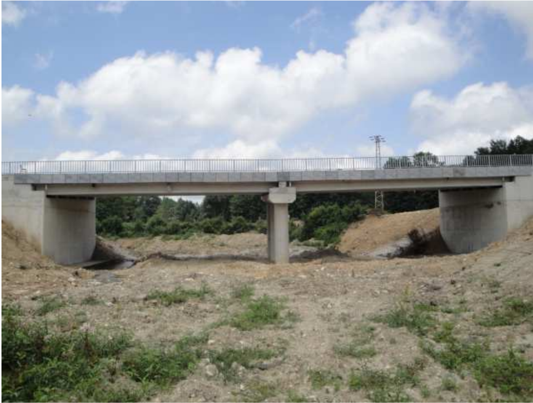
Fotoğraf 15. Yeni yapılan Lala dere köprüsü mansaptan bakış
