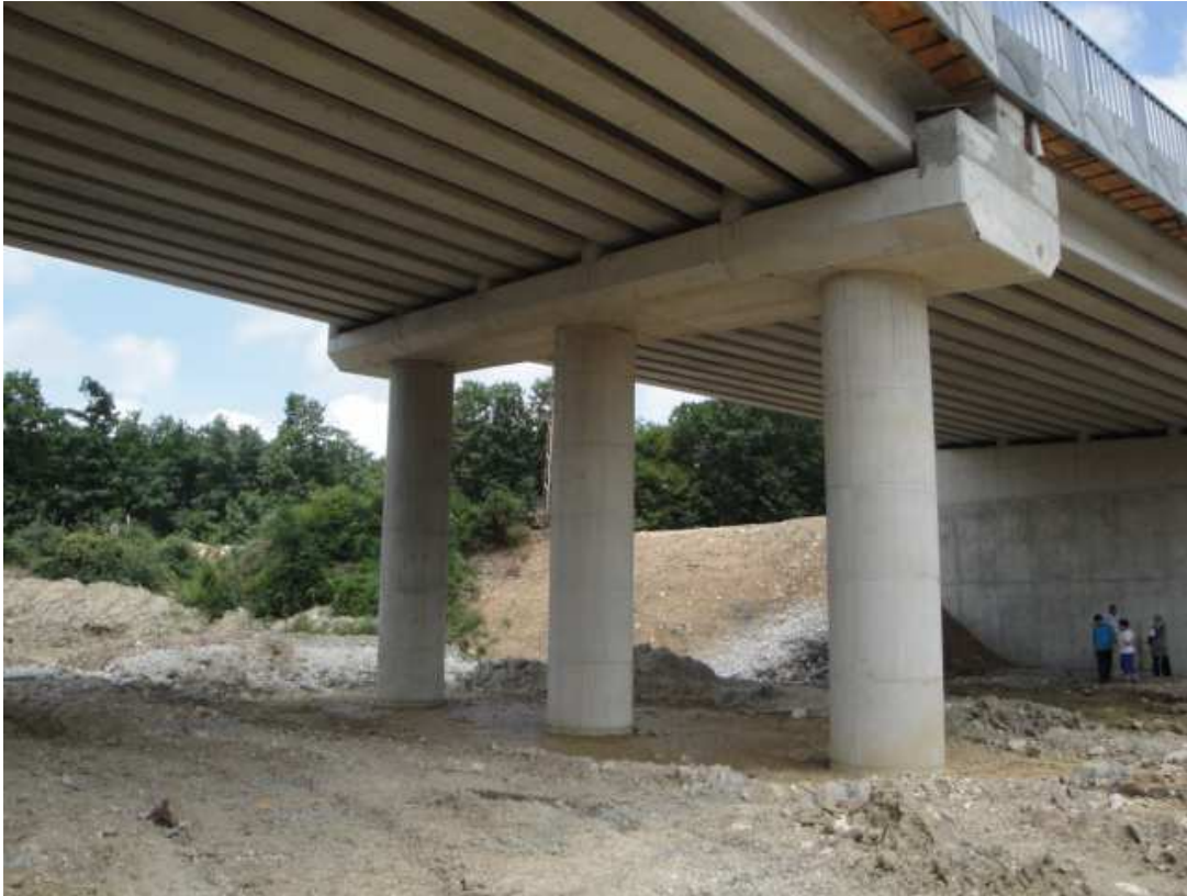
Fotoğraf 13. Yeni yapılan Lala dere köprüsü orta ayakları
