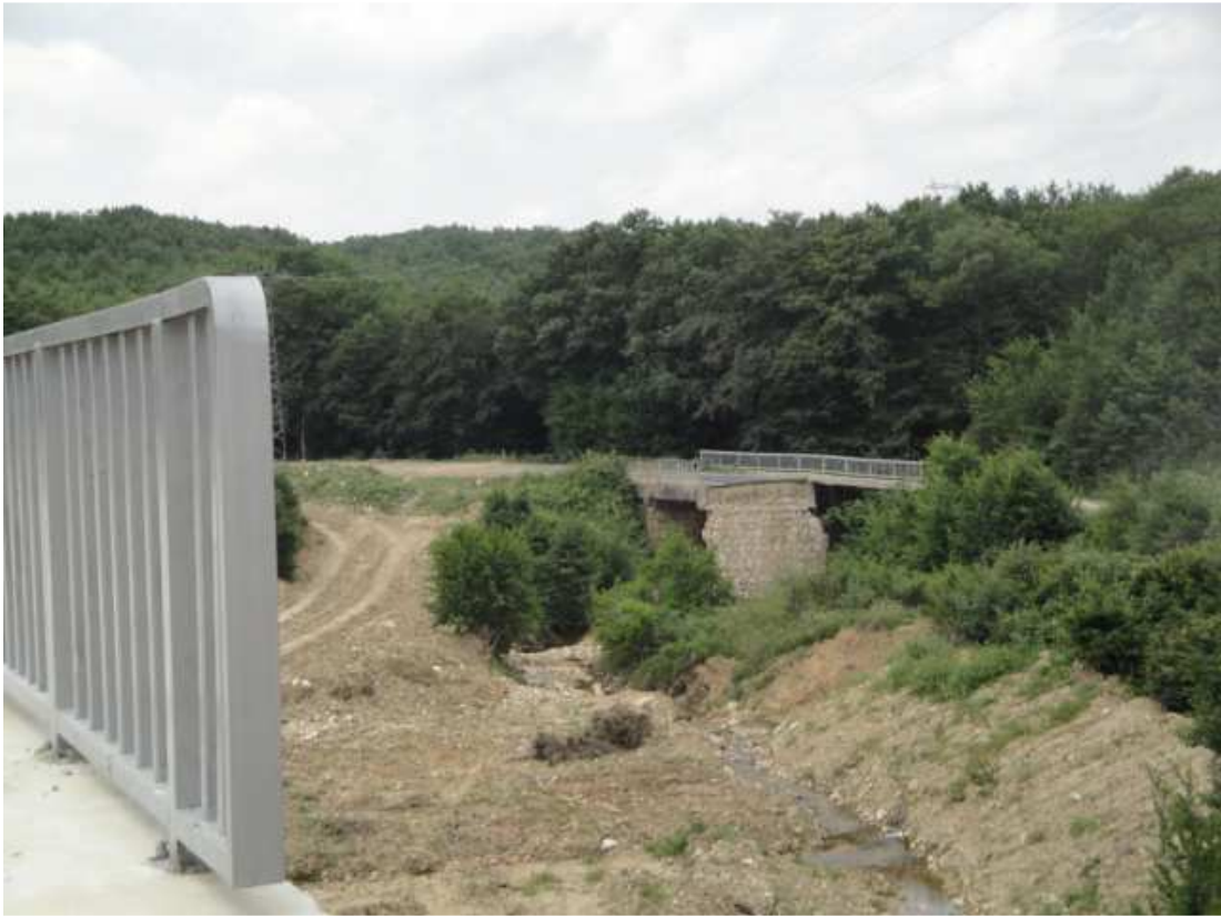
Fotoğraf 9. Yıkılan Laladere köprüsü ile yeni yapılan Lala dere köprüsü
