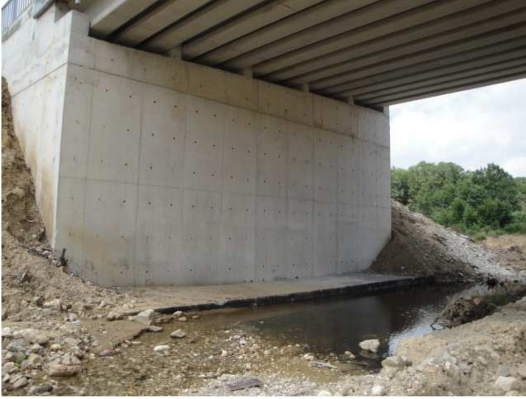
Fotoğraf 12. Yeni yapılan Lala dere köprüsü kenar ayağı
