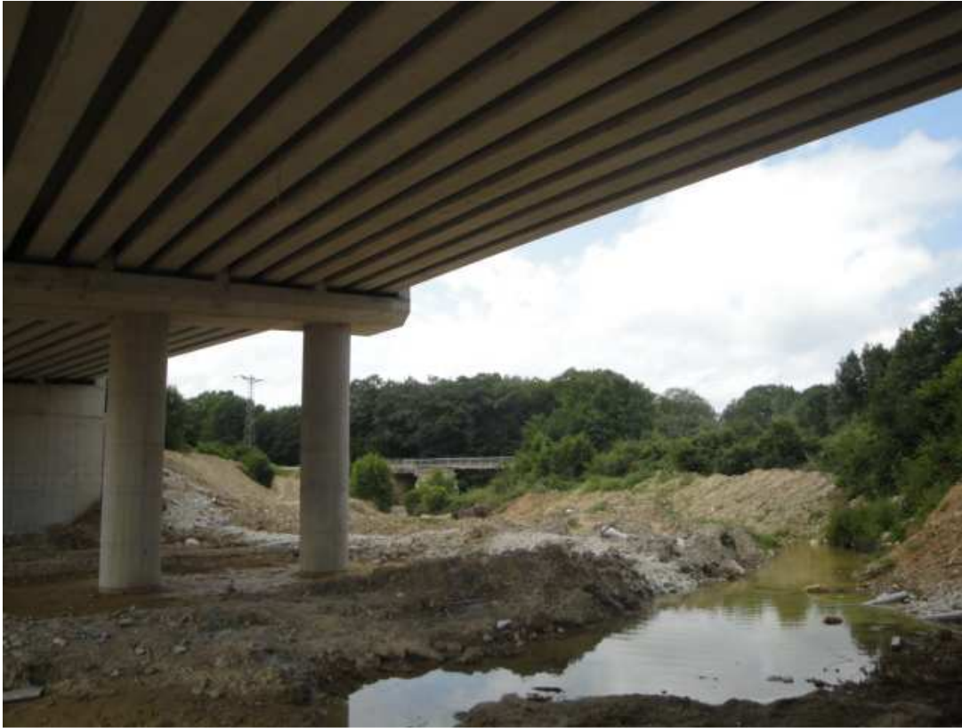
Fotoğraf 11. Yıkılan Laladere köprüsü ile yeni yapılan Lala dere köprüsü
