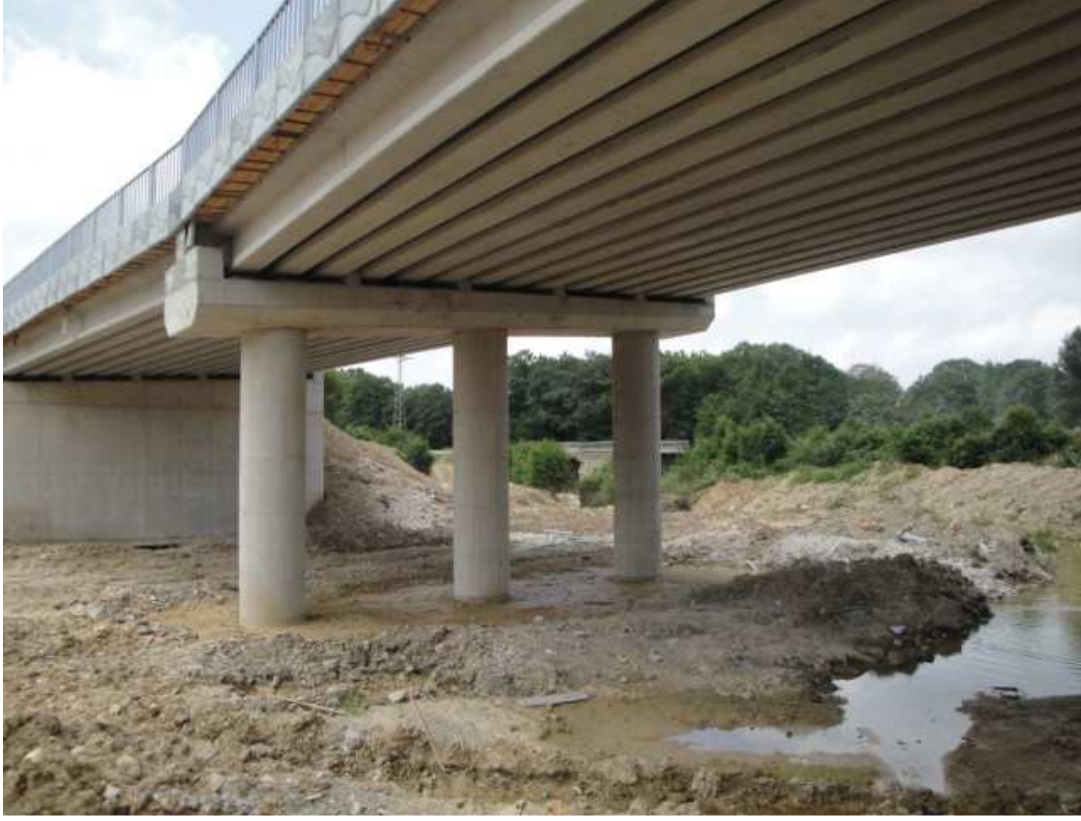
Fotoğraf 10. Yıkılan Laladere köprüsü ile yeni yapılan Lala dere köprüsü
