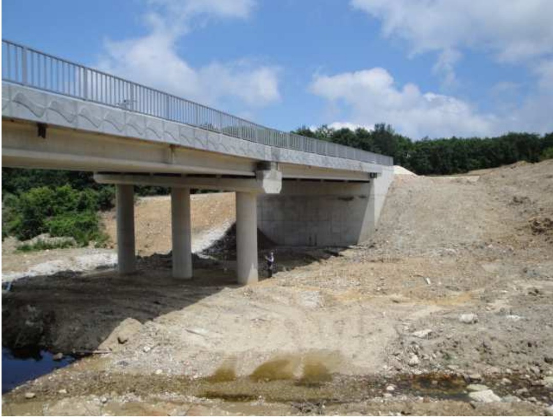
Fotoğraf 14. Yeni yapılan Lala dere köprüsü mansaptan bakış
