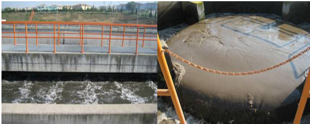
Şekil 4.3. Karaman Kentsel Atıksu Arıtma Tesisi kum tutucu ve aktif çamur çıkışından bir görünüm
